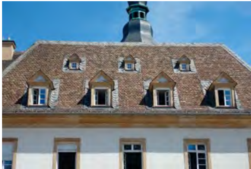
Speyer, typische pfälzische Ziegeldeckung mit Schiefereinfassungen
