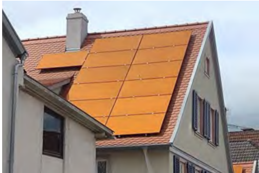
Farblich angepasste PV-Anlage
