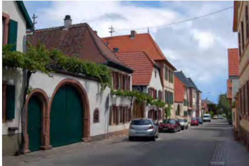
Rhodt unter Rietburg, ortsbildprägender Straßenzug mit giebelständigen Gehöften
