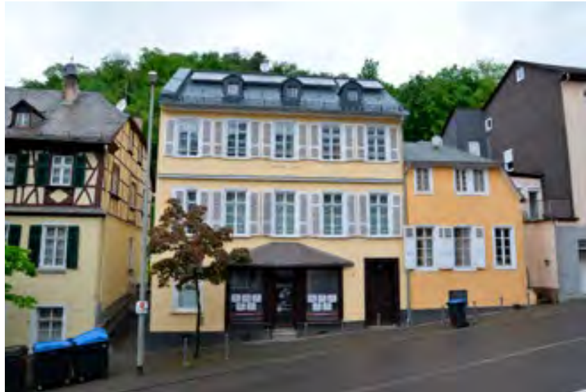
Als Band gestaltete, zurückhaltende PV-Anlage oberhalb der Dachgauben in der Denkmalzone
