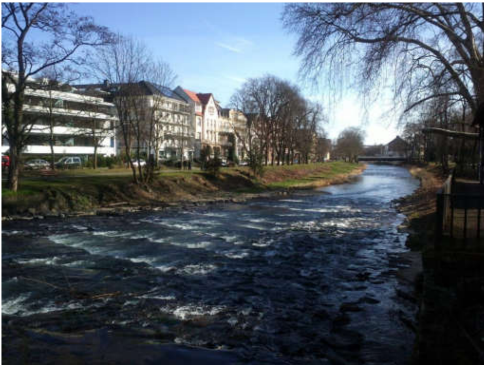
Abb. 89 Die 2013 eingerichtete Sohlgleite in der Ahr am Terrassen-Sitzplatz. Ansicht von Westen. Fotografie Verfasserin, März 2014.
