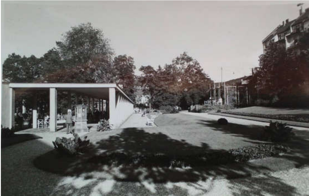
Abb. 55 Der Südgarten und die südliche Wandelhalle von Westen.. Der Höhenunterschied wird durch eine Rasenböschung abgefangen. Fotografie, um 1938/39. Archiv der AG Bad Neuenahr
