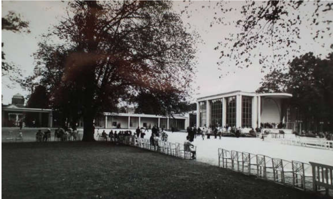
Abb. 44 Die große Trinkhalle mit der zum Platz gedrehten Orchesterbühne. Links das Hauptportal und der Verbindungsgang zur kleinen Trinkhalle. Ansicht von Nordwesten. Fotografie, um 1938/39. Archiv der AG Bad Neuenahr
