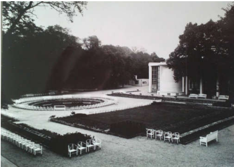
Abb. 35 Die Trinkhalle und die gestalteten Außenanlagen von Südwesten. Rasen- und Platzflächen sind durch Trockenmauern und Rabatten gegliedert. Im Vordergrund die Stechpalmenblöcke zu beiden Seiten des Weges. Fotografie, um 1934. Archiv der AG Bad Neuenahr
