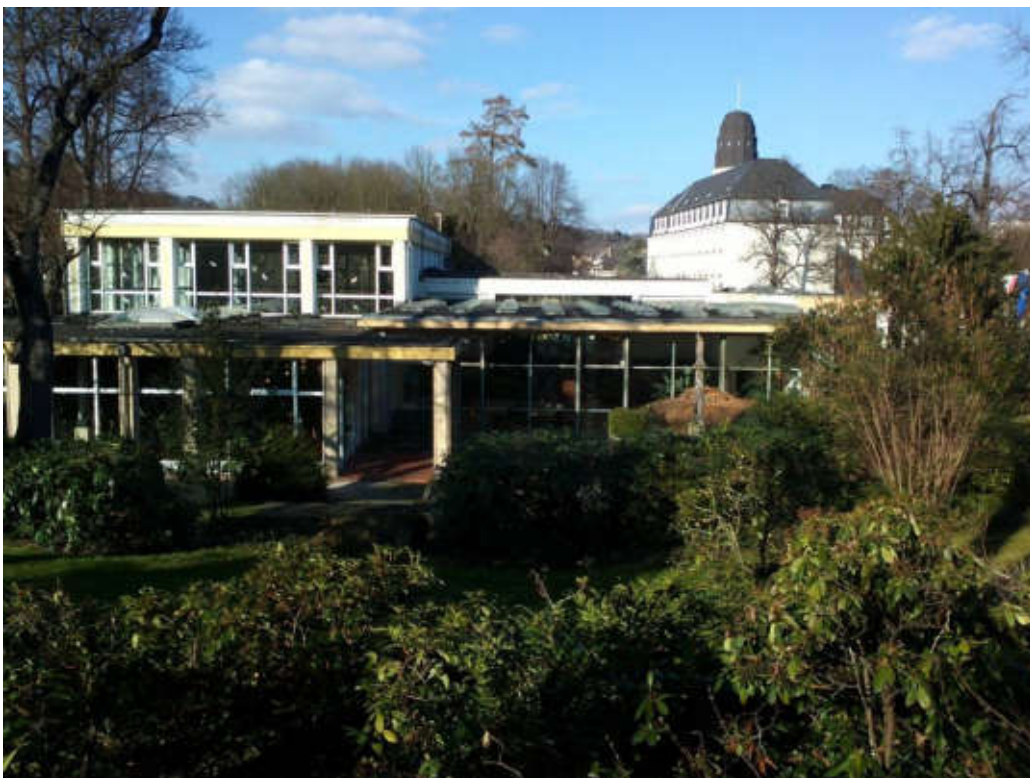
Abb. 75 Der „Ehrenhof“ nach dem Umbau zum geschlossenen Raum als Wintergarten in seinem heutigen Erscheinungsbild. Ansicht von Süden (vgl. Abb. 74). Fotografie Verfasserin, März 2014.
