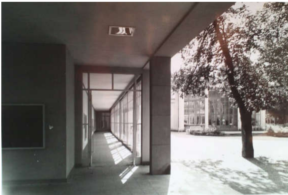
Abb. 45 Der Verbindungsgang vom Hauptportal zur kleinen Trinkhalle. Ansicht von Norden. Fotografie, um 1938/39. Archiv der AG Bad Neuenahr
