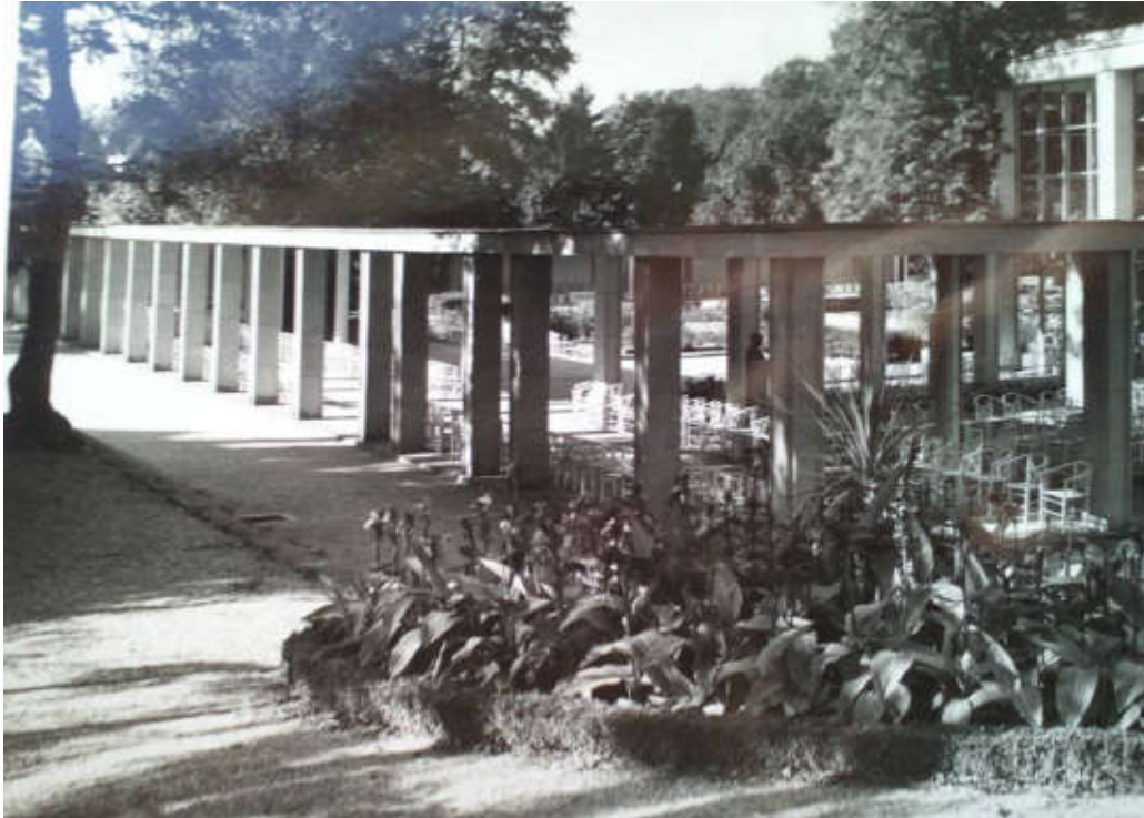
Abb. 72 Der „Ehrenhof“ mit offenen Wandelhallen. Ansicht von Südosten (vgl. Abb. 73). Fotografie, um 1938/39. Archiv der AG Bad Neuenahr
