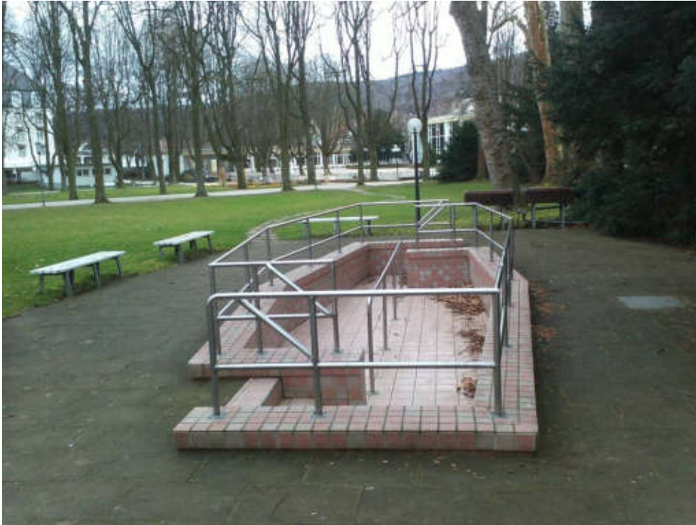
Abb. 84 Das Kneipp-Becken im landschaftlichen Bereich westlich der Alleen. Ansicht von Nordwesten. Fotografie Verfasserin, März 2014.
