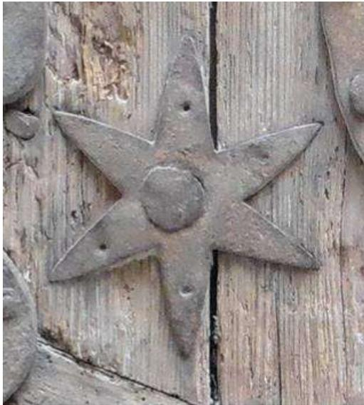
Die Zierlöcher wurden mit einem Vierkant-Locheisen eingeschlagen. Darauf deutet das von der Schauseite her eingesunkene Loch hin. Der durch die Lochung entstandene Grat wurde auf der Rückseite flach umgeschlagen.
