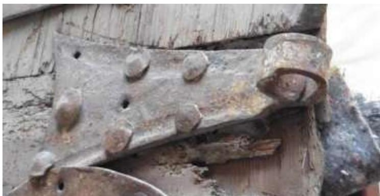
erfasst, fotografisch dokumentiert und kartiert. Bei den originalen Nägeln aus der Entstehungszeit der Tür handelt es sich um einen Nageltypus mit rundem, flachem bis wenig gewölbtem Kopf. Die Köpfe der Nägel sind von unterschiedlicher Größe. Die Schäfte der Nägel sind zu
