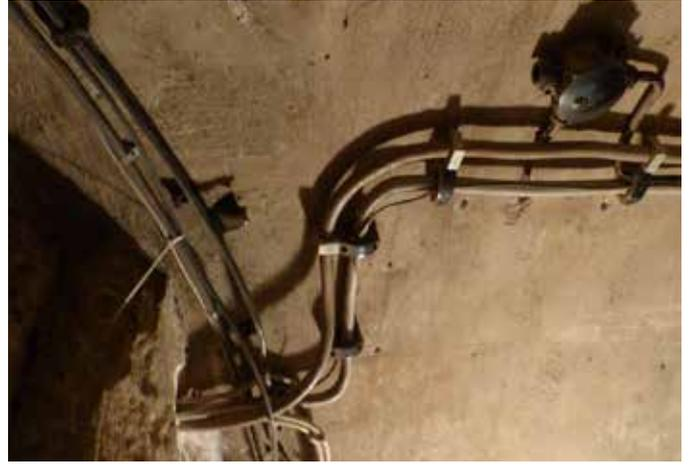
Elektroleitungen als Brandentstehungsrisiko und Gefahrenquelle einer möglichen Brandweiterleitung
