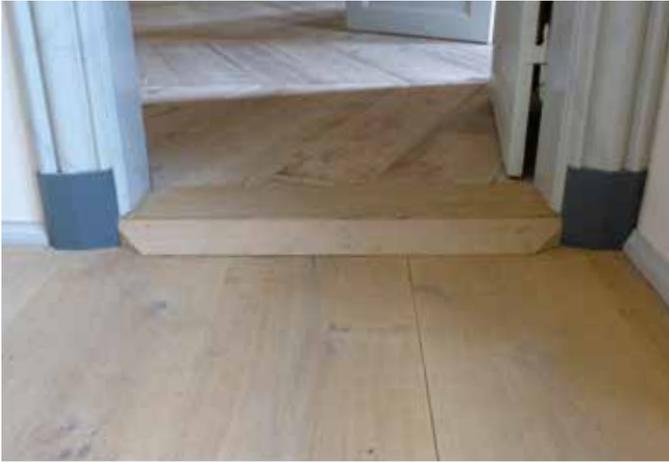
Barrierefreie Rettungswegführung durch angepasste neue Schwelle
