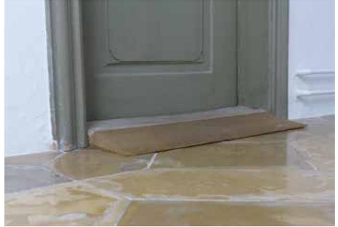
Barrierefreie Rettungswegführung durch hinzugefügten Keil
