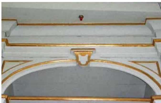
Löschdüse einer Hochdrucknebellöschanlage
