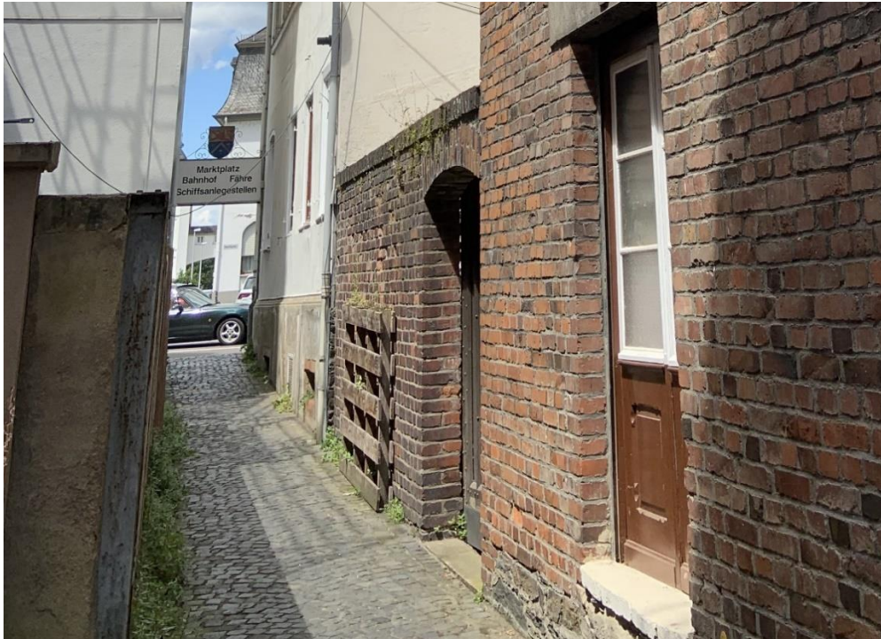
Abb. 7: Bei Burgstraße 5 , Backsteinmauer mit segmentbogigem Tor.
