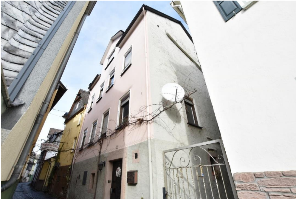
Abb. 27: Burgstraße 25 , südwestliche und südöstliche Fassade.
