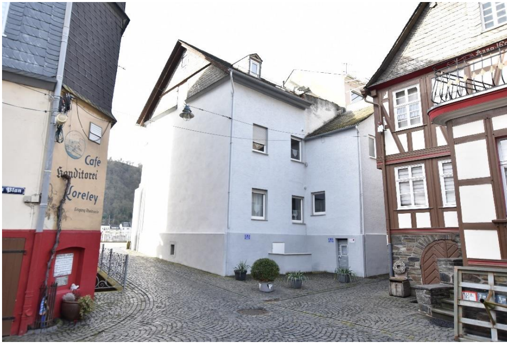
Abb. 55: Rheinstraße 16 , südöstliche und nordöstliche Fassade.
