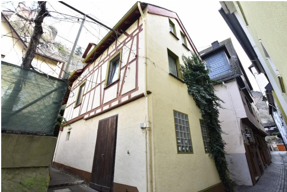
Abb. 30: Burgstraße 28 , nordwestliche und südwestliche Fassade.
