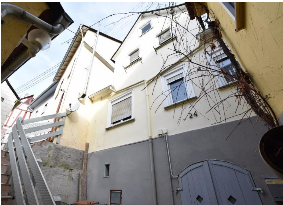
Abb. 26: Burgstraße 24 , südwestliche Fassade.
