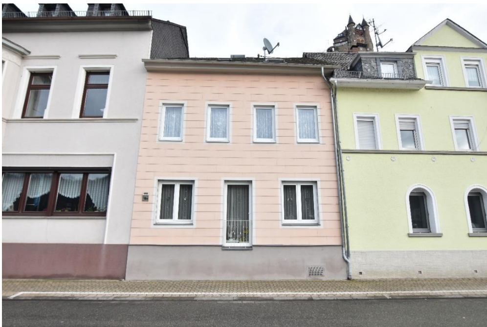
Abb. 60: Rheinstraße 19A , südwestliche Fassade.
