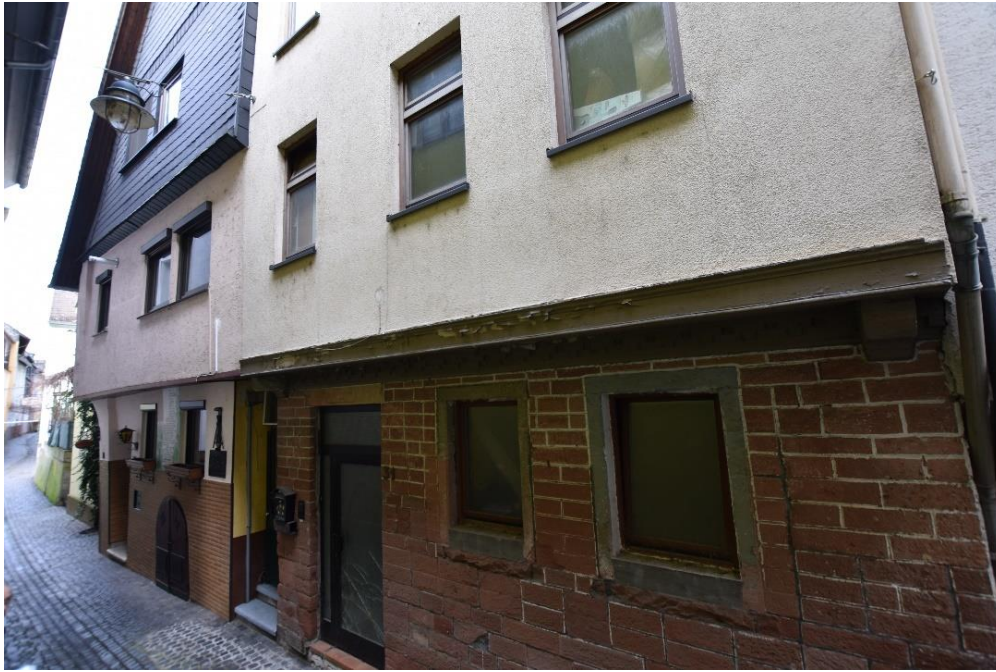
Abb. 33: Burgstraße 29/31 , südwestliche Fassade, Erdgeschoss.
