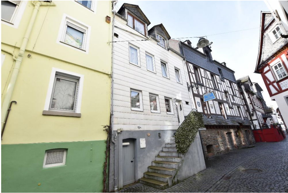
Abb. 61: Rheinstraße 19A , nordöstliche Fassade.
