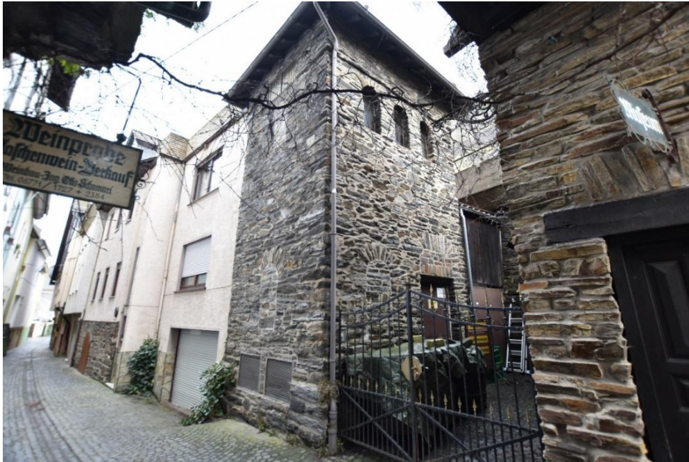
Abb. 35: An Burgstraße 33 , Trafoturmchen, südwestliche und südöstliche Fassade.
