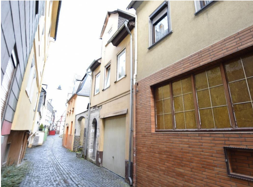
Abb. 21: Burgstraße 17 , südwestliche Fassade.
