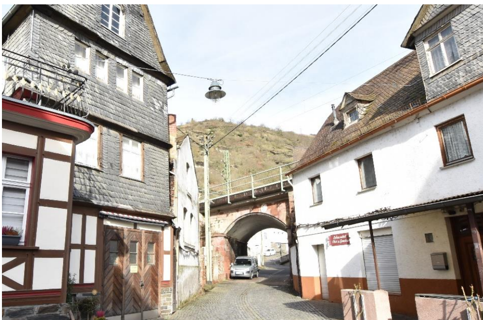
Abb. 10: Burgstraße o. Nr. , Bahnunterführung, Ansicht von Süden.
