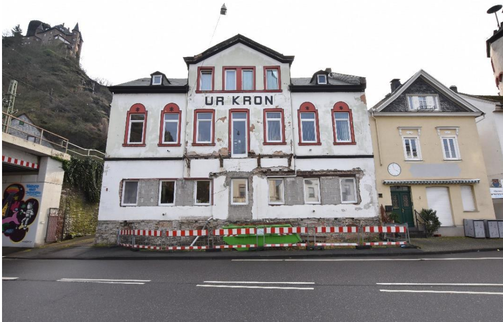
Abb. 44: Marktplatz 8 , nordwestliche Fassade.
