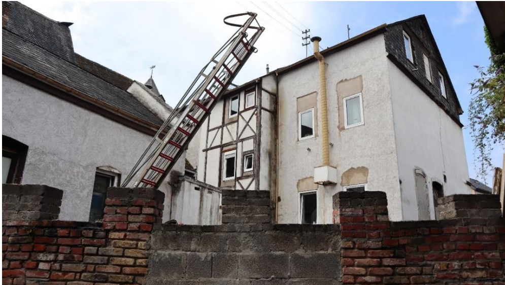
Abb. 45: Marktplatz 8 , südöstliche Fassade.
