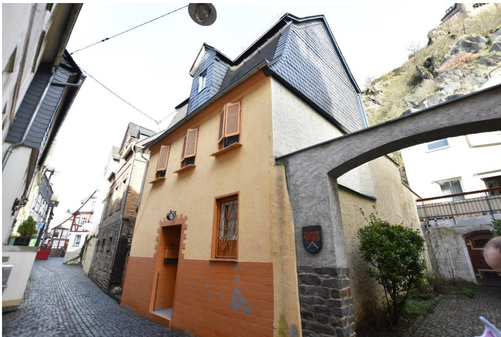
Abb. 20: Burgstraße 15 , südwestliche Fassade.
