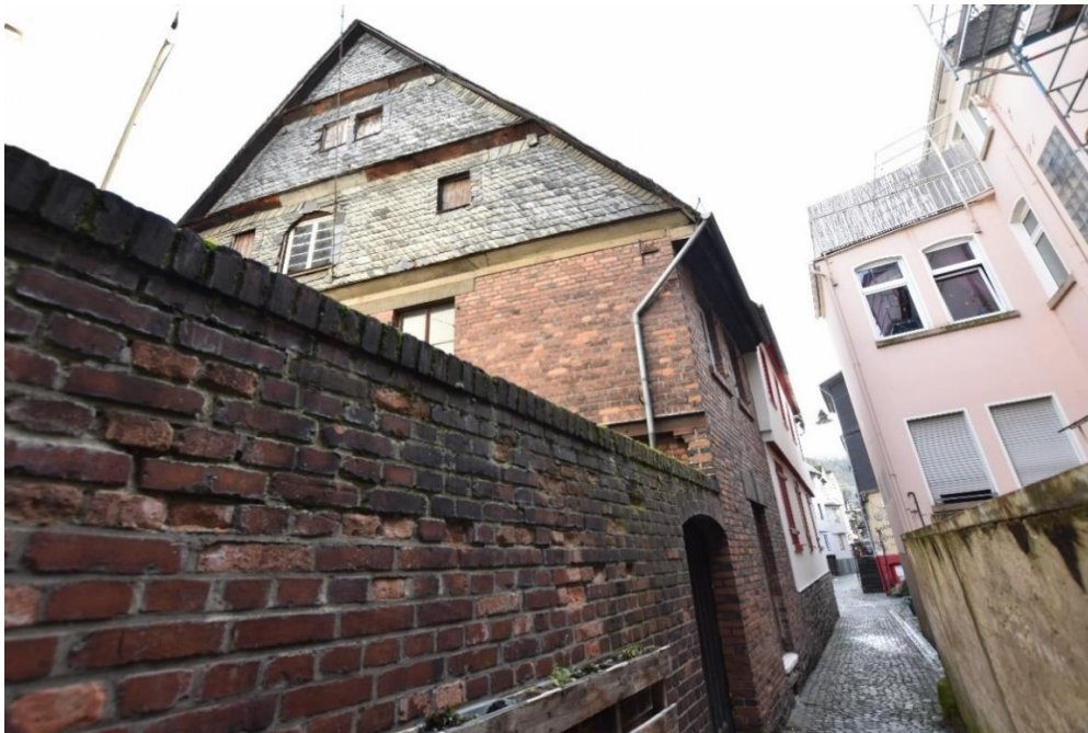
Abb. 13: Burgstraße 5 , nordwestliche Fassade.
