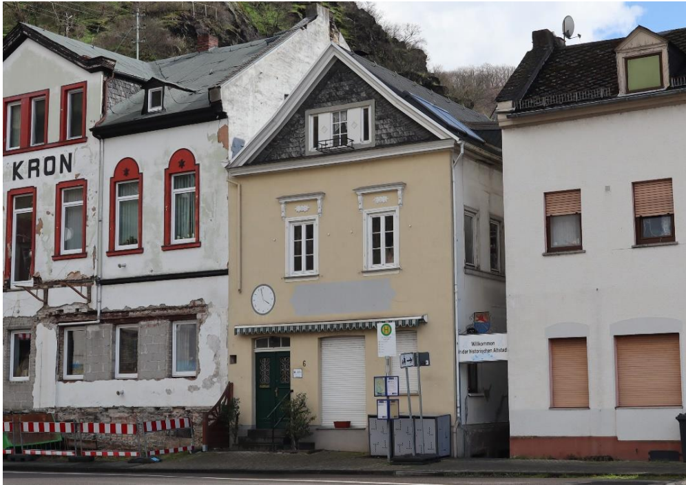
Abb. 43: Marktplatz 6 , nordwestliche Fassade.
