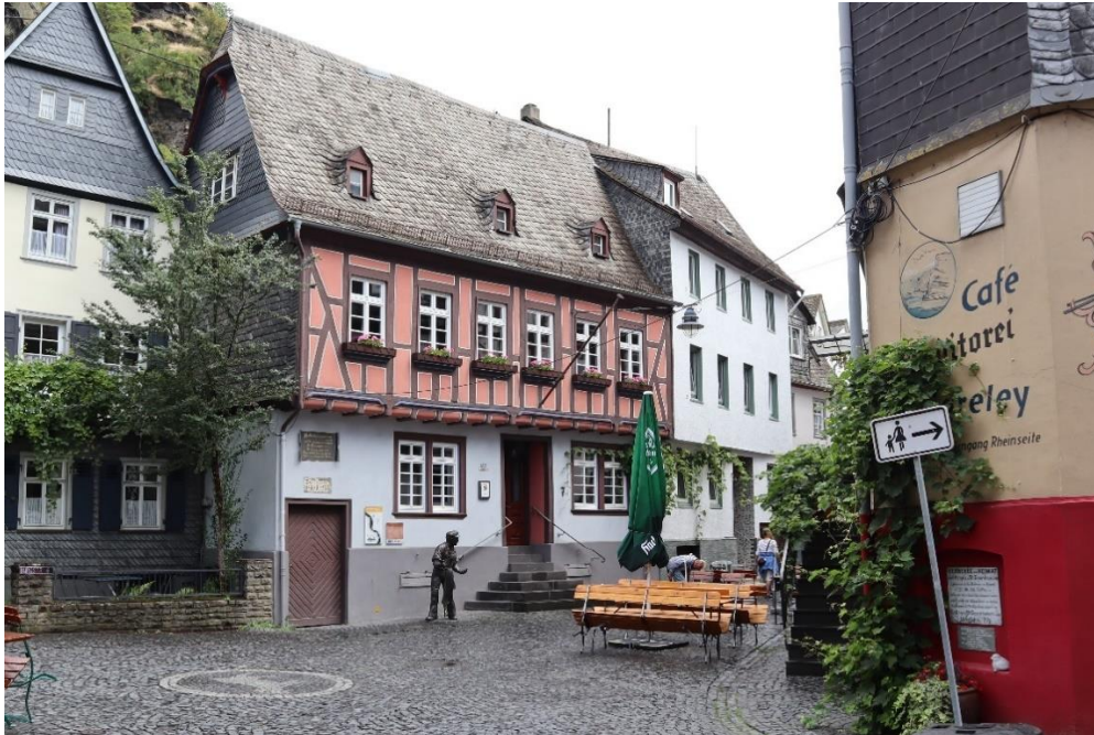
Abb. 15: Burgstraße 7 , ehemaliges Rathaus, südwestliche Fassade.
