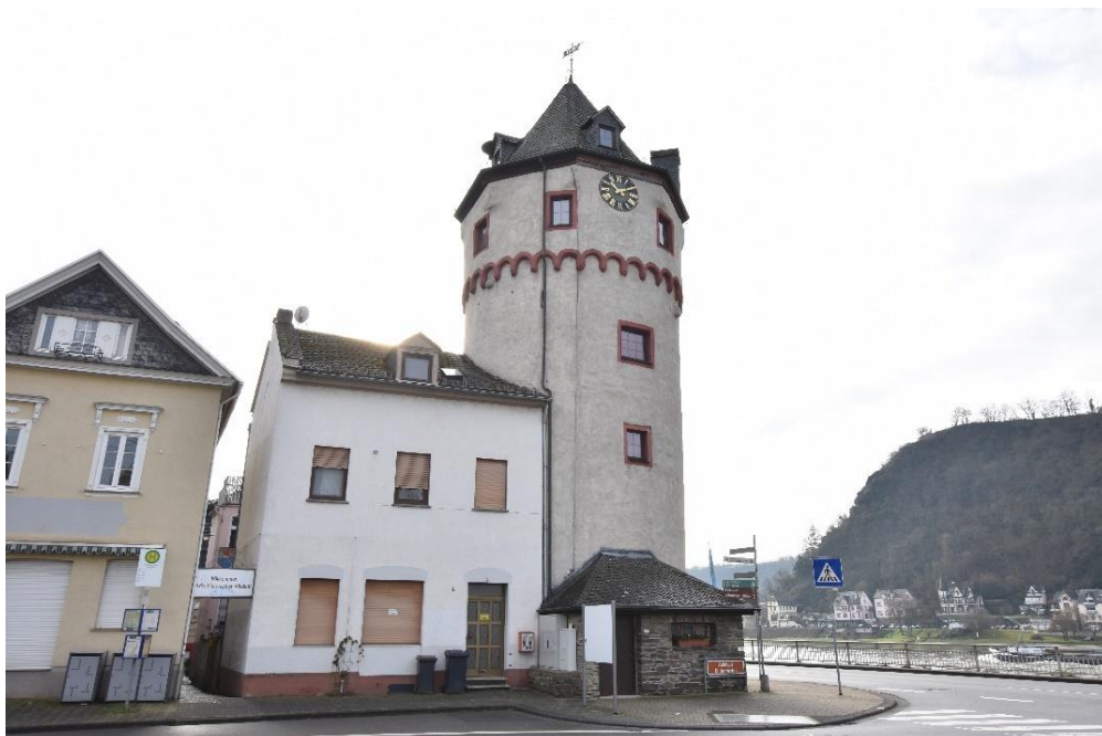
Abb. 42: Marktplatz 4 , nordwestliche Fassade.
