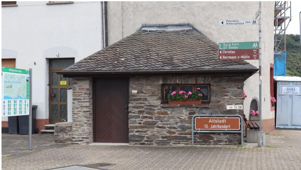
Abb. 41: Bei Marktplatz 2 , ehemaliges Wiegehäuschen, nordwestliche Fassade.
