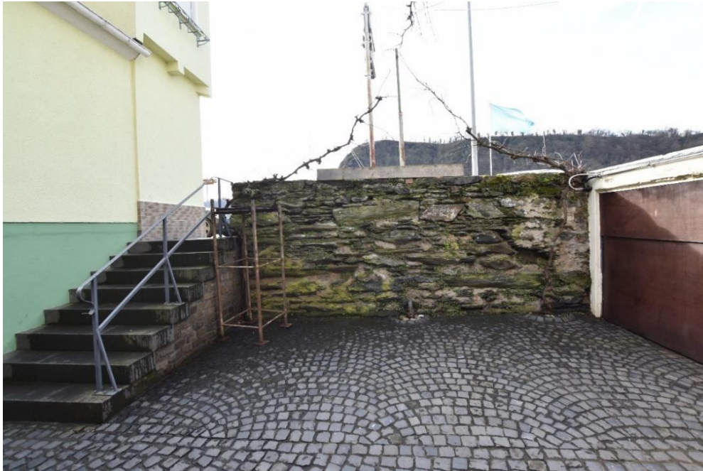
Abb. 75: Zwischen Rheinstraße 29 und 31 , Mauerabschnitt der ehemaligen mittelalterlichen Stadtmauer.
