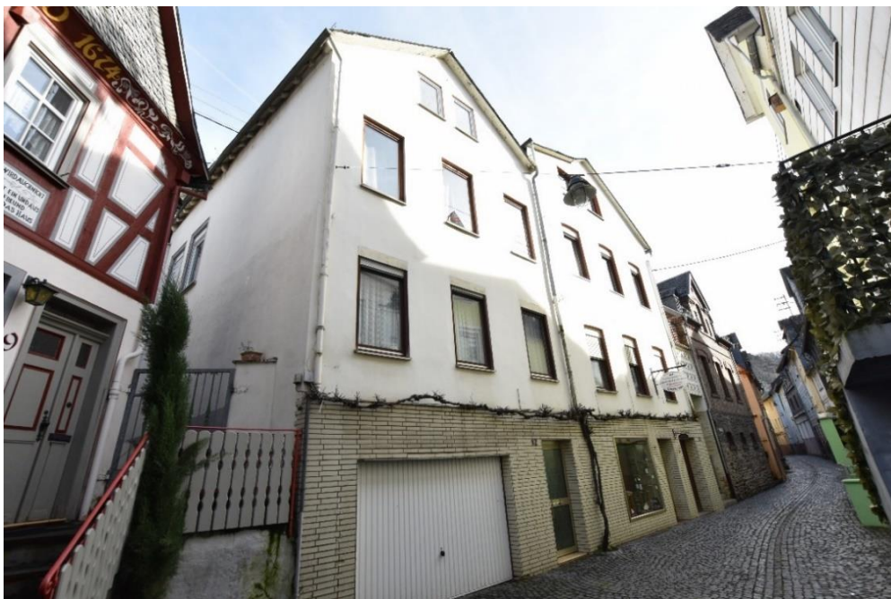
Abb. 18: Burgstraße 12 u. 13 , südwestliche Fassade.
