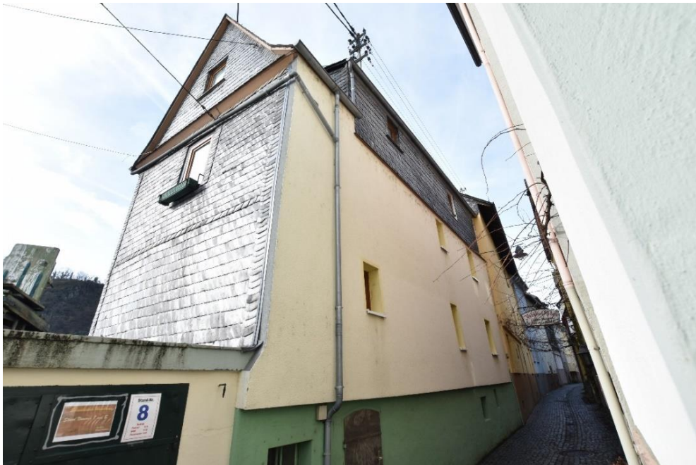
Abb. 74: Rheinstraße 29 , südöstliche und nordöstliche Fassade.
