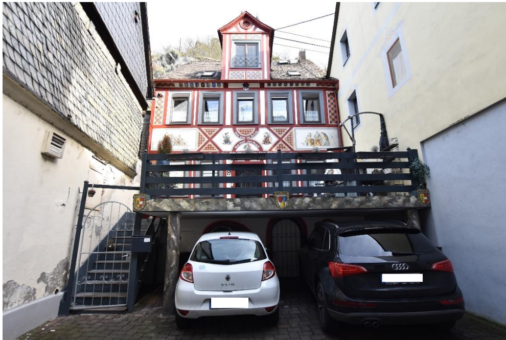
Abb. 23: Burgstraße 19 , südwestliche Fassade.
