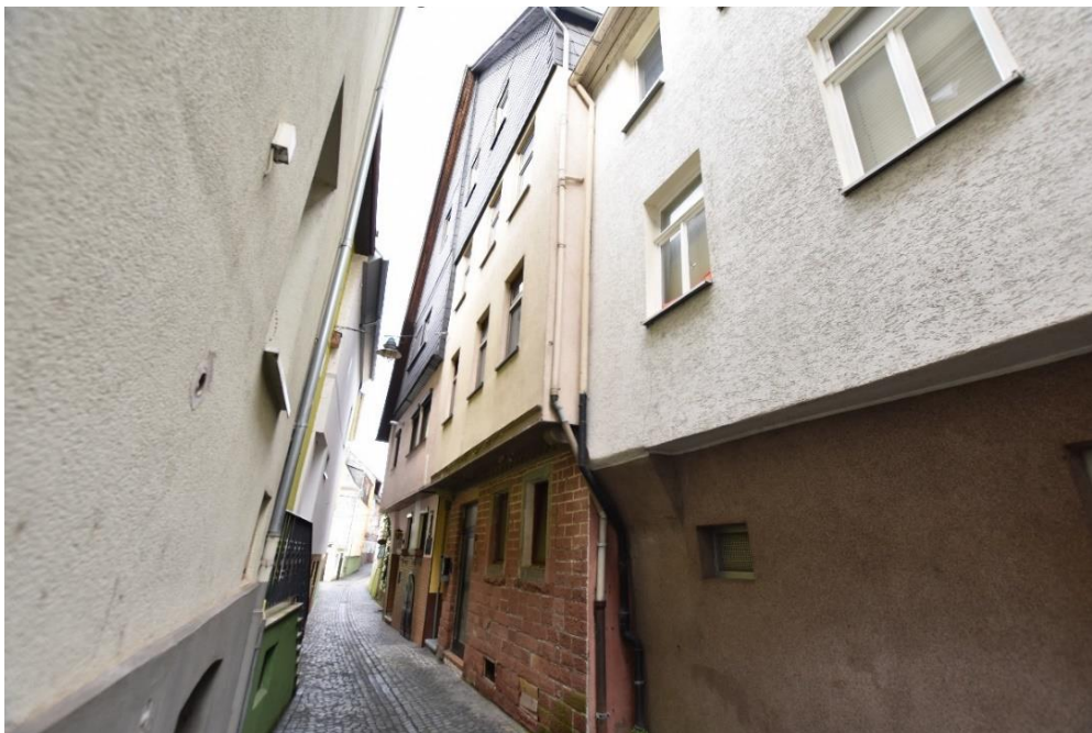
Abb. 32 : Burgstraße 29/31 , südwestliche Fassade.
