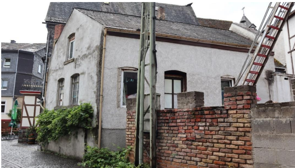
Abb. 46: Zu Marktplatz 8 , rückwärtiges Gebäude, südöstliche und nordöstliche Fassade; Backsteinmauer mit Zinnenbekrönung als Hofeinfriedung.
