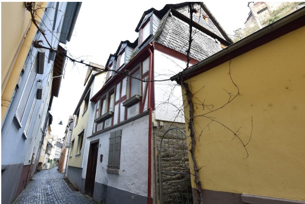
Abb. 24: Burgstraße 21 , südwestliche Fassade.
