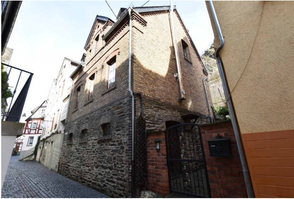
Abb. 19: Burgstraße 14 , südwestliche und südöstliche Fassade.
