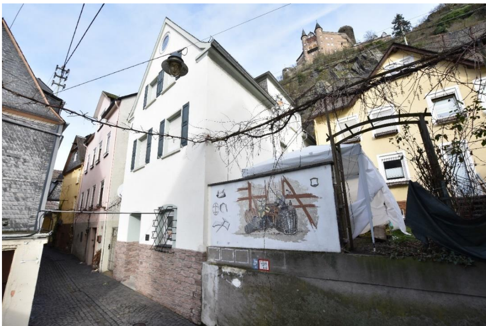
Abb. 28: Burgstraße 26 , südwestliche und südöstliche Fassade.
