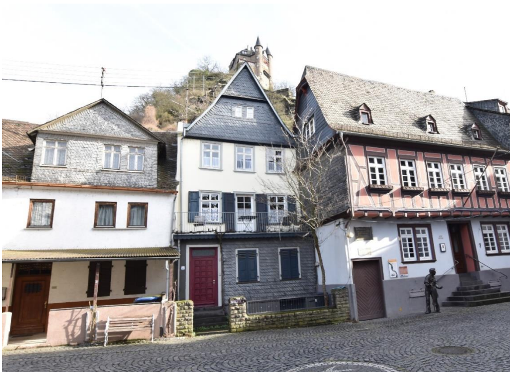
Abb. 14: Burgstraße 6 , südwestliche Fassade.
