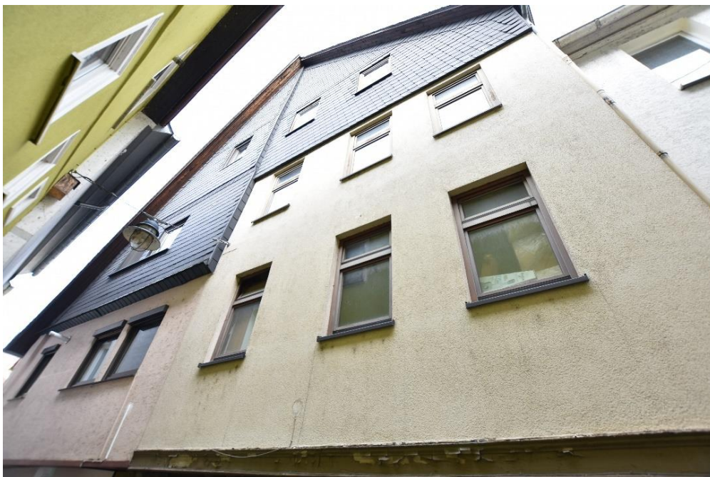
Abb. 34: Burgstraße 29/31 , südwestliche Fassade, Obergeschosse.
