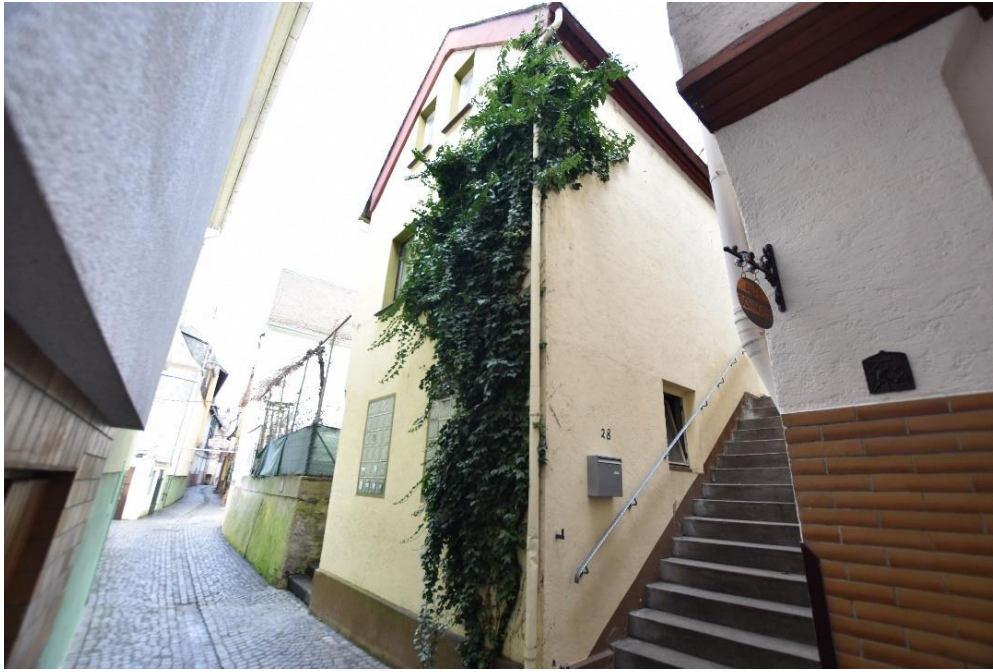
Abb. 31: Burgstraße 28 , südwestliche und südöstliche Fassade.
