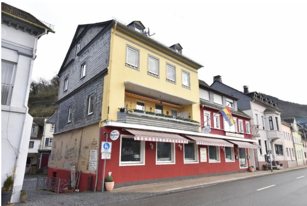
Abb. 56: Rheinstraße 17/18 , nordwestliche und südwestliche Fassade.
