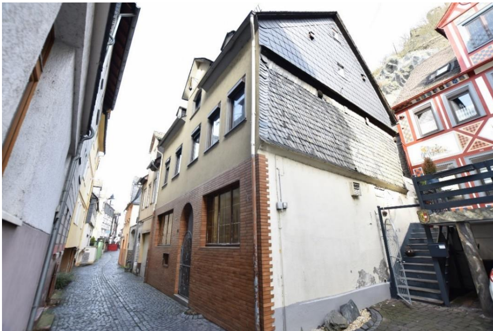
Abb. 22: Burgstraße 18 , südwestliche und südöstliche Fassade.
