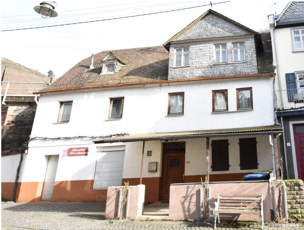
Abb. 11: Burgstraße 4 , südwestliche Fassade.
