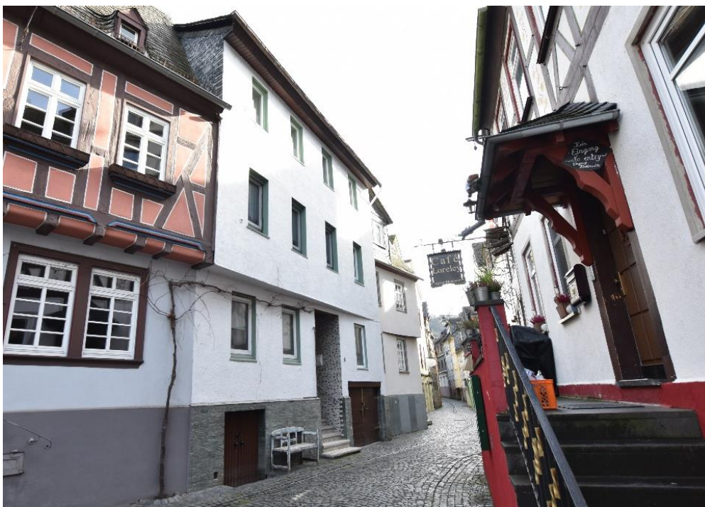
Abb. 16: Burgstraße 8 , südwestliche Fassade.
