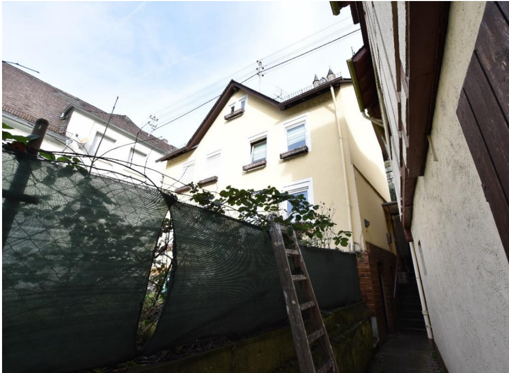
Abb. 29: Burgstraße 27 , südwestliche Fassade.
