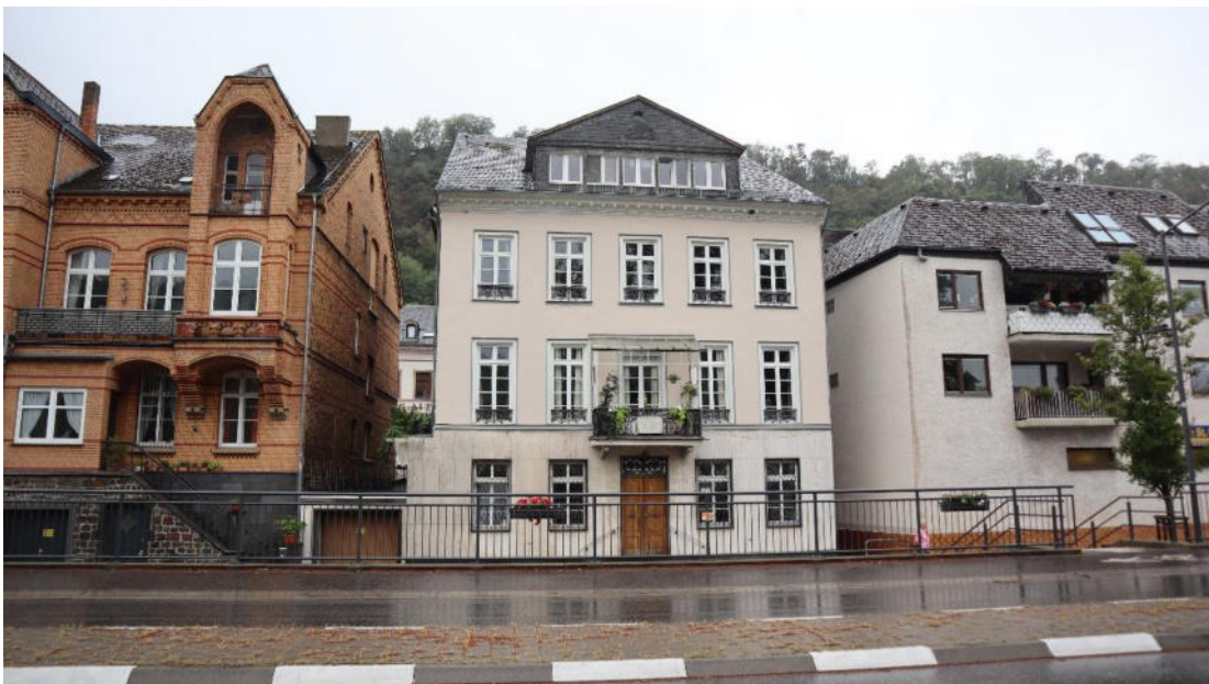
Abb. 54 : Heerstraße 106, Rheinseite, Ansicht von Norden.
