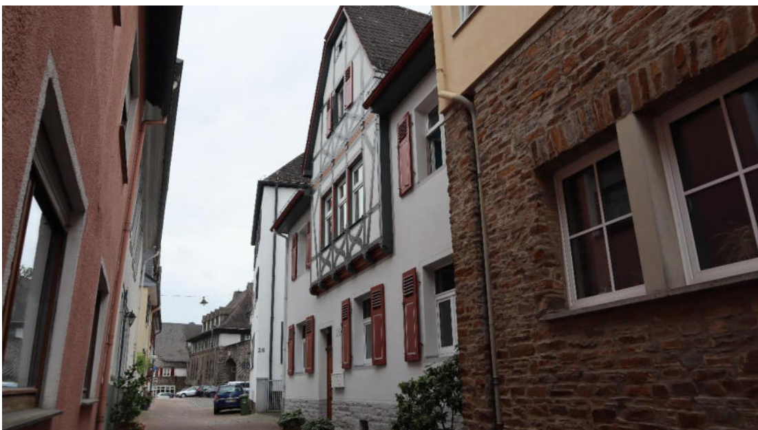
Abb. 116 : Oberstraße 26, Ansicht von Nordwesten.
