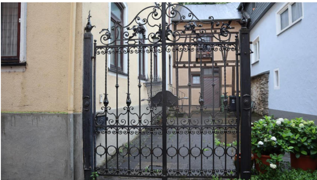
Abb. 134 : an Oberstraße 46, gusseiserne Einfriedung.
