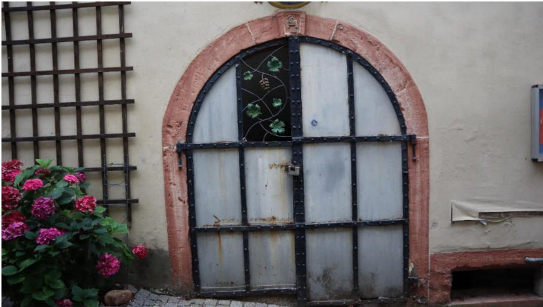
Abb. 173 : an Sonnengasse 8, Kellereingang.
