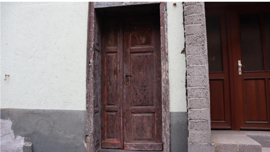
Abb. 156 : an Pumpengasse 9, Eingangsportal.
