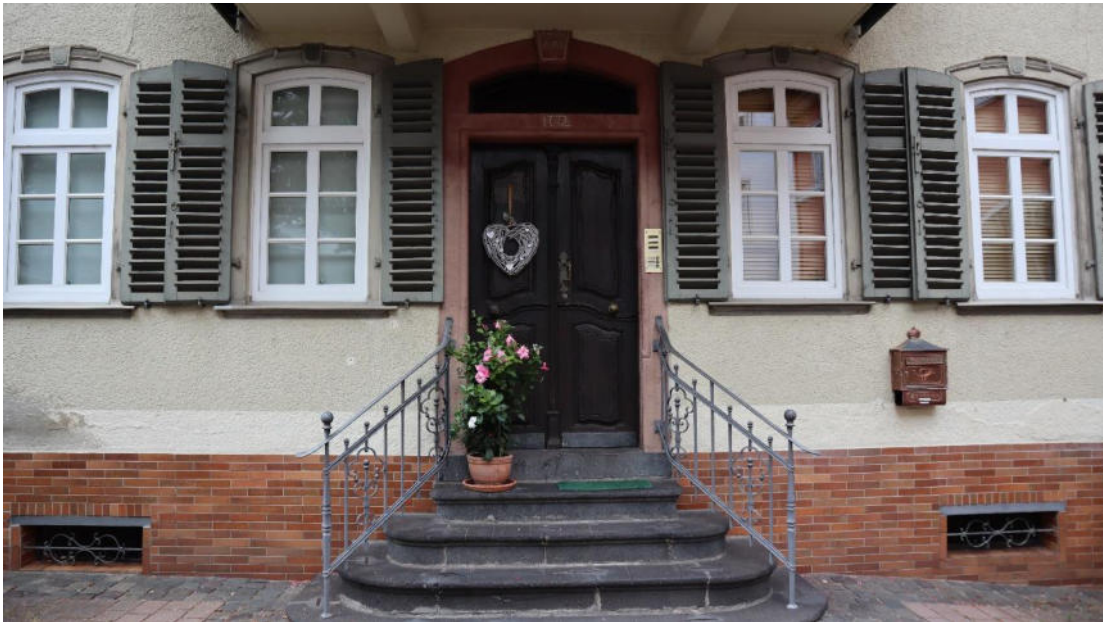
Abb. 89 : an Kirchplatz 6, Eingangportal, 1772.
