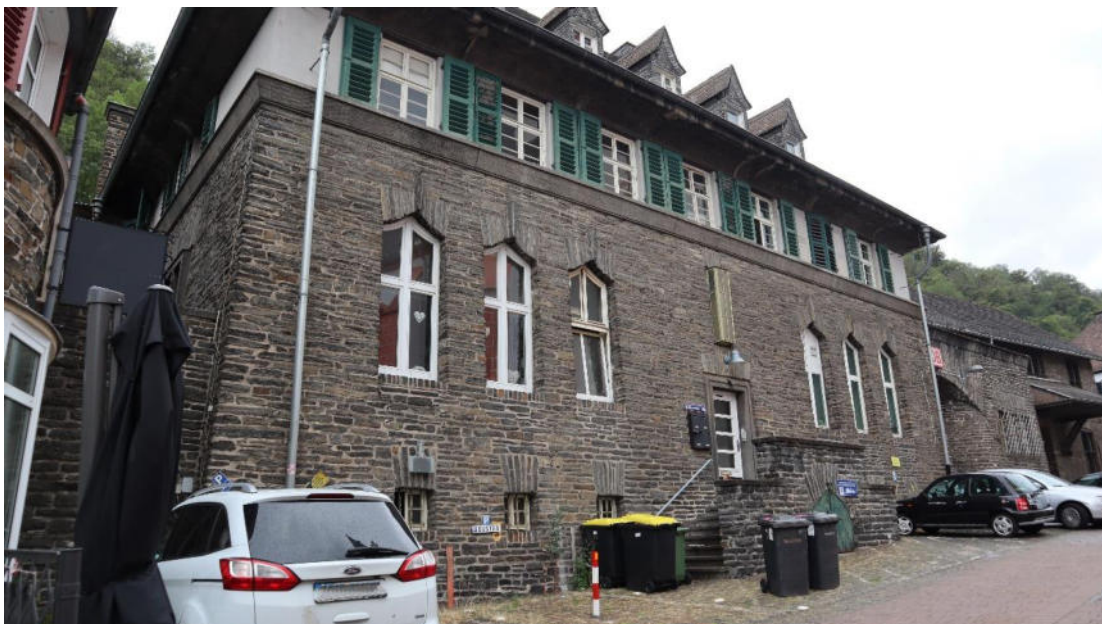
Abb. 124 : Oberstraße 32, Bahnhof, Empfangsgebäude, Ansicht von Nordosten.
