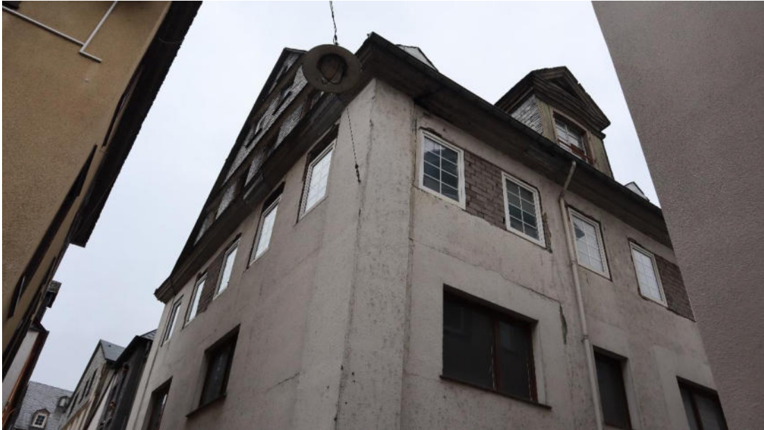
Abb. 77 : Herpellstraße 9, Ansicht von Westen.
