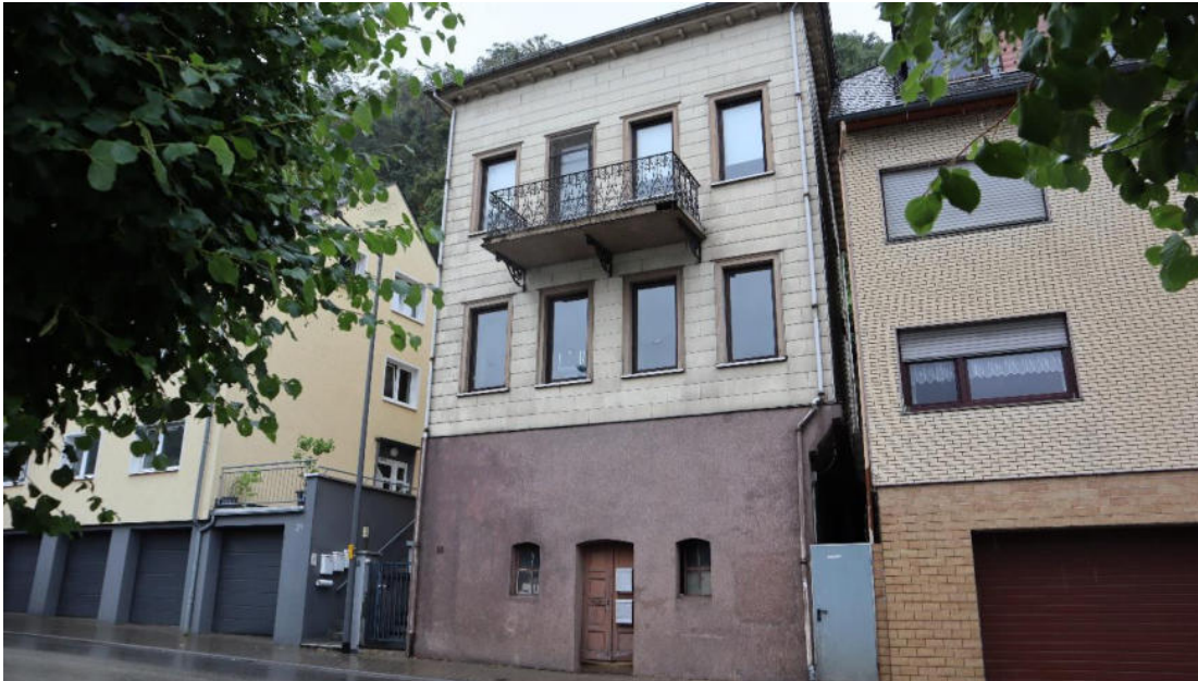
Abb. 21 : Heerstraße 33, Rheinseite, Ansicht von Norden.
