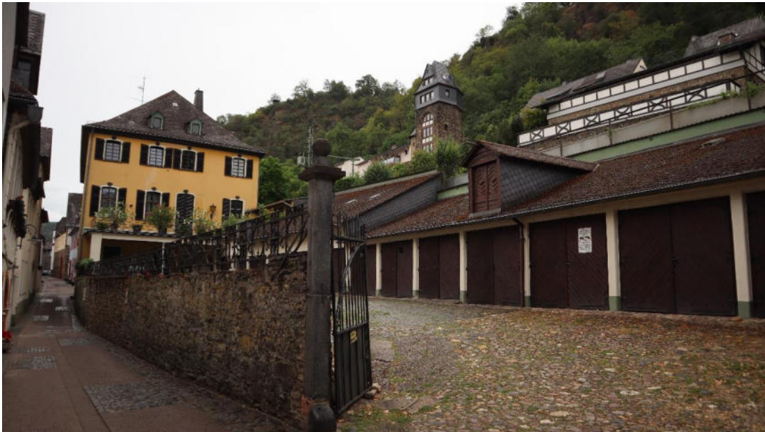
Abb. 109 : an Oberstraße 16, Hofanlage.
