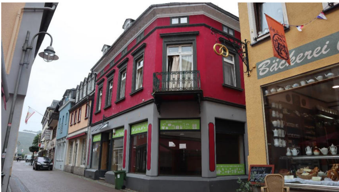
Abb. 42 : Heerstraße 93, Ansicht von Nordwesten.
