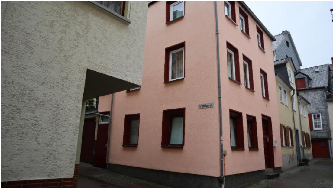
Abb. 75 : Herpellstraße 4, Ansicht von Osten.
