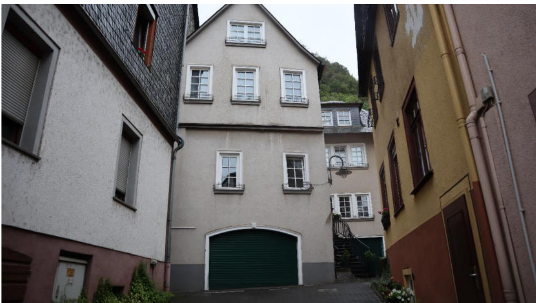
Abb. 138 : Oberstraße 50, Ansicht von Nordosten.
