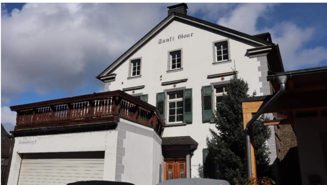
Abb. 164 : Schloßberg 9, Ansicht von Süden.
