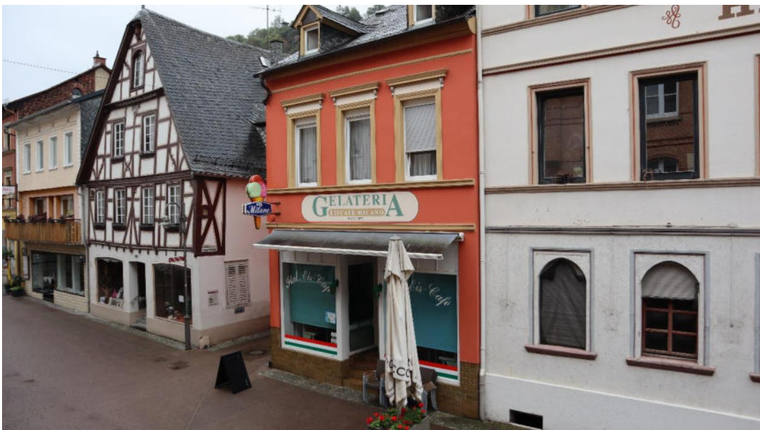
Abb. 48 : Heerstraße 103, Ansicht von Nordwesten.
