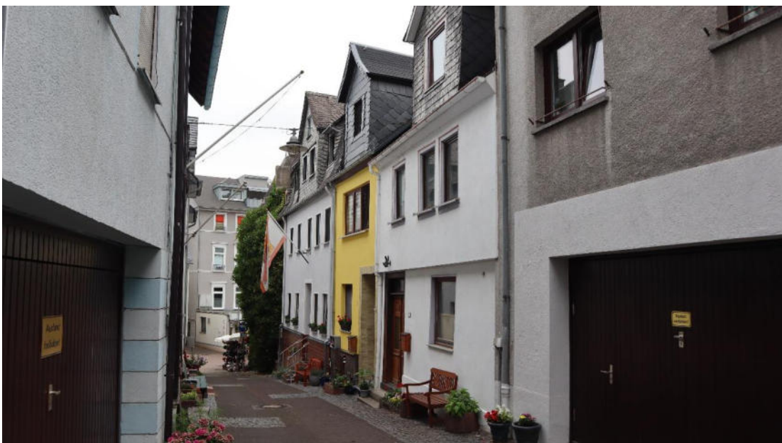
Abb. 158 : Schleiergasse 1 und 5, Ansicht von Südwesten.
