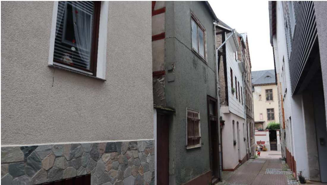
Abb. 11 : Borngasse 6, Ansicht von Südosten.
