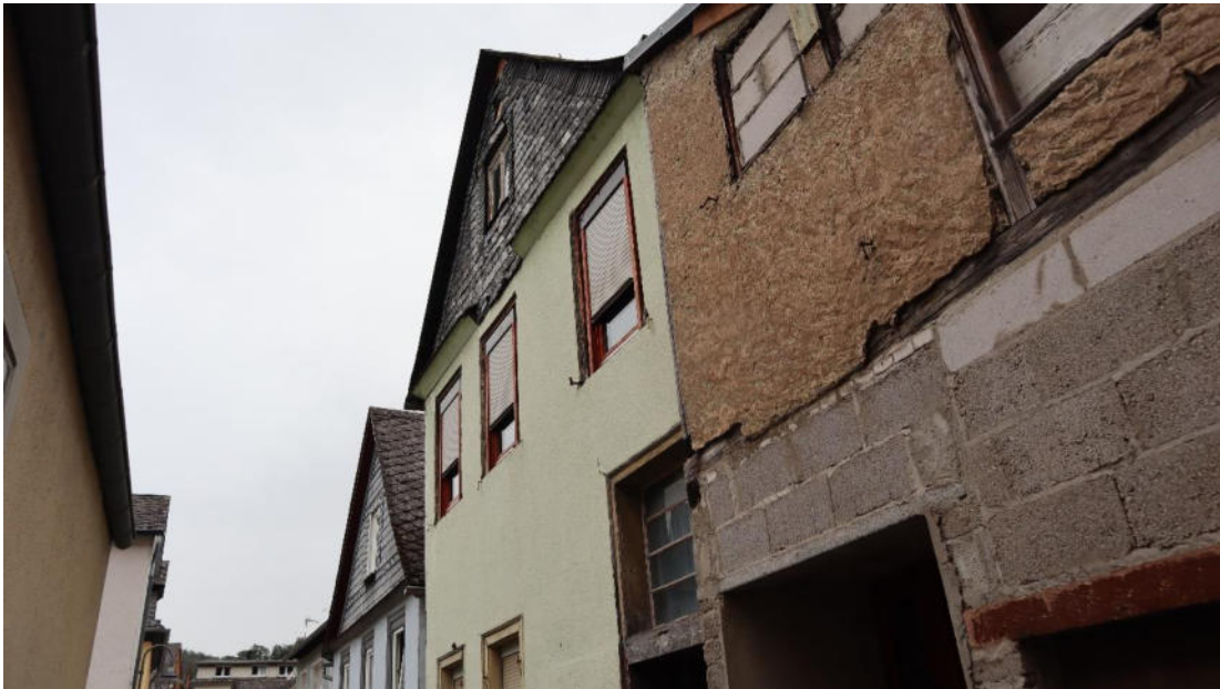
Abb. 155 : Pumpengasse 9, linksseitig Scheunenanbau , Ansicht von Südwesten.
