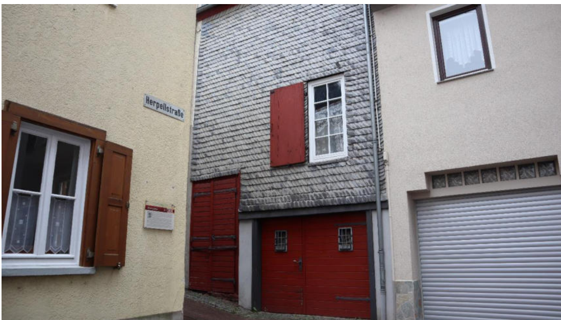
Abb. 12 : Borngasse 10, Ansicht von Südosten.
