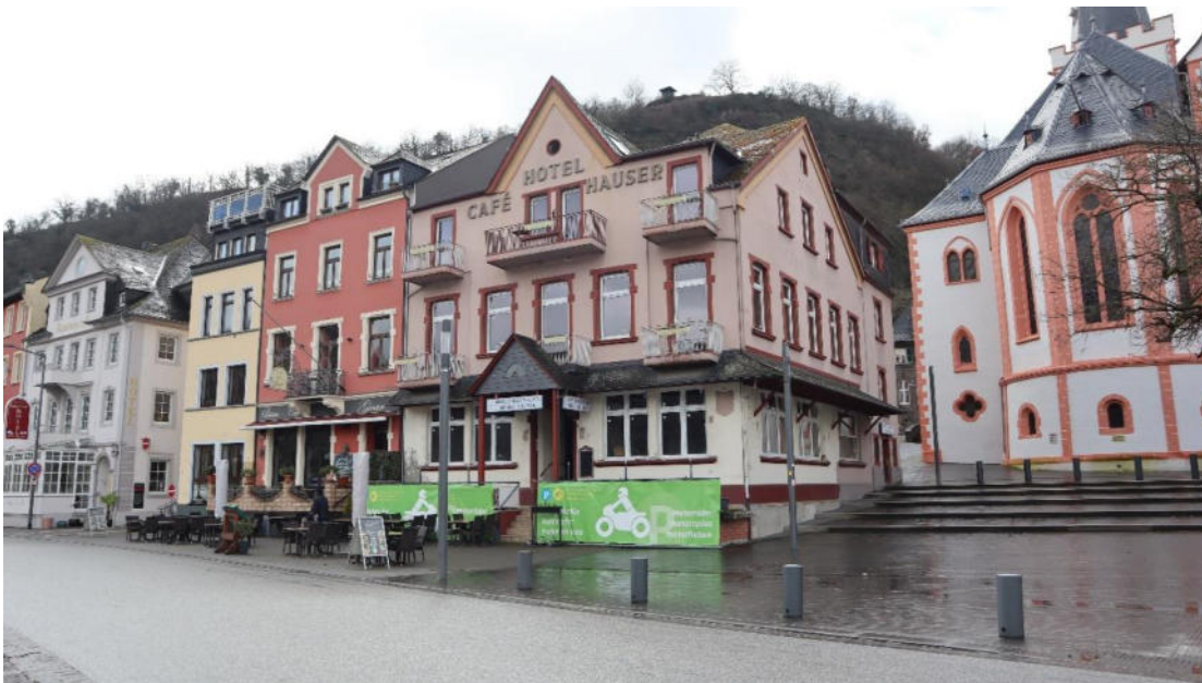
Abb. 31 : Heerstraße 75 und 77 „Hotel Hauser“, Rheinseite, Ansicht von Nordwesten.
