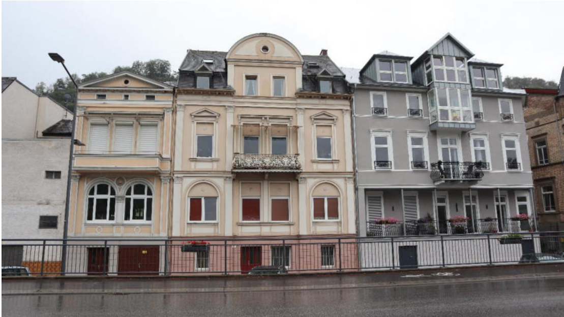
Abb. 63 : Heerstraße 114, 116 und 120 , Rheinseite, Ansicht von Norden.
