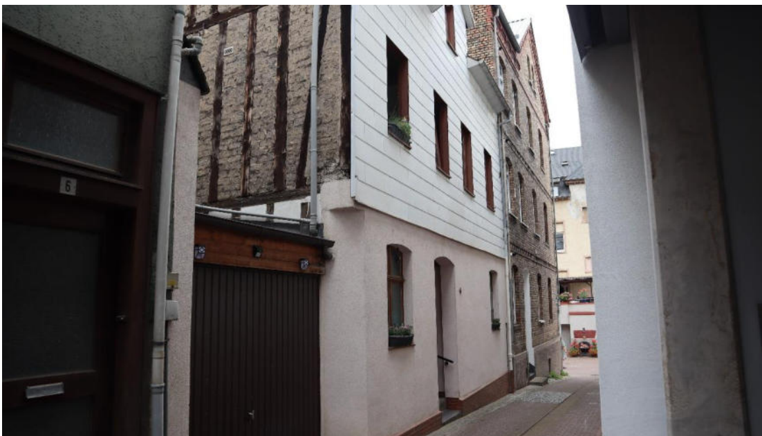
Abb. 10 : Borngasse 4, Ansicht von Südosten.
