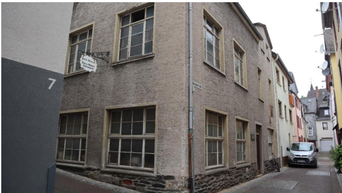
Abb. 72 : Herpellstraße o. Nr., Tischlerei „Hans Werner – Bau- und Möbelschreinerei“, Ansicht von Osten.
