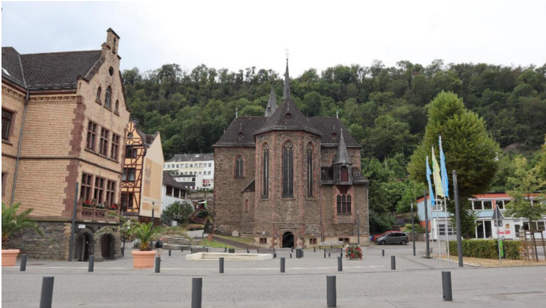
Abb. 69 : Heerstraße 133, Kath. Pfarrkirche St. Goar und St. Elisabeth, Rheinseite, Ansicht von Norden.
