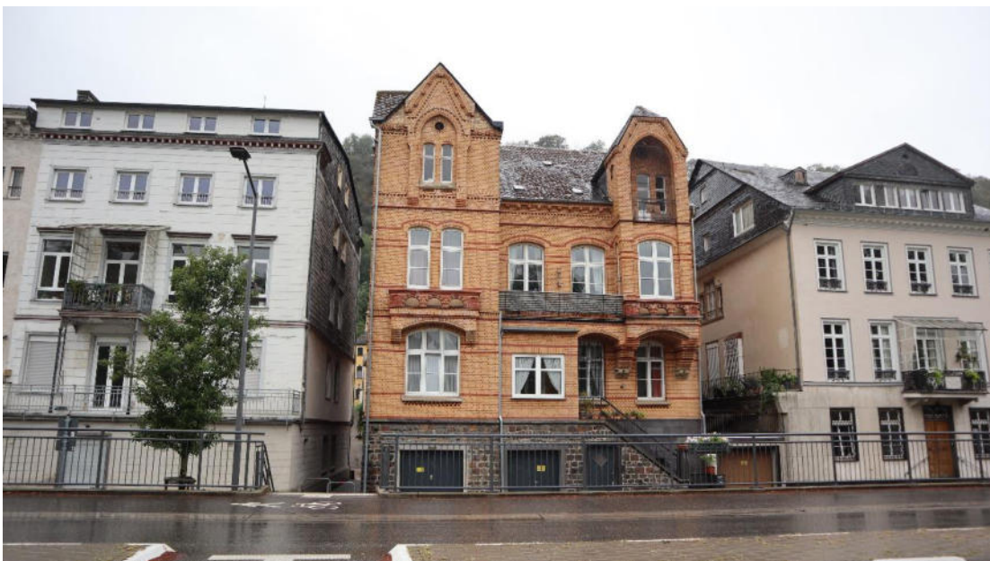
Abb. 52 : Heerstraße 104, Rheinseite, Ansicht von Norden.
