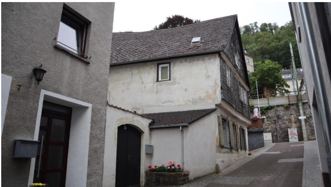
Abb. 160 : Schleiergasse 9, Ansicht von Nordwesten.
