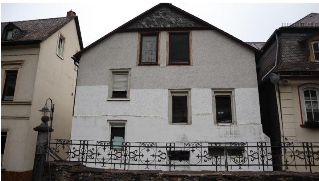
Abb. 106 : Oberstraße 11, Ansicht von Süden.
