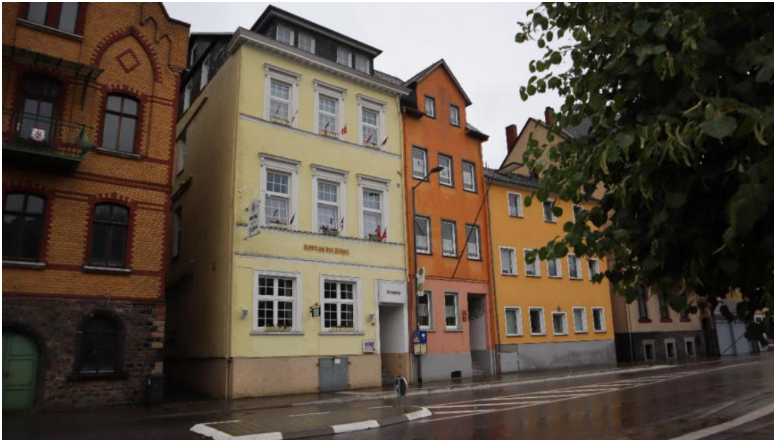
Abb. 23 : Heerstraße 47 und 49, Rheinseite, Ansicht von Nordosten.
