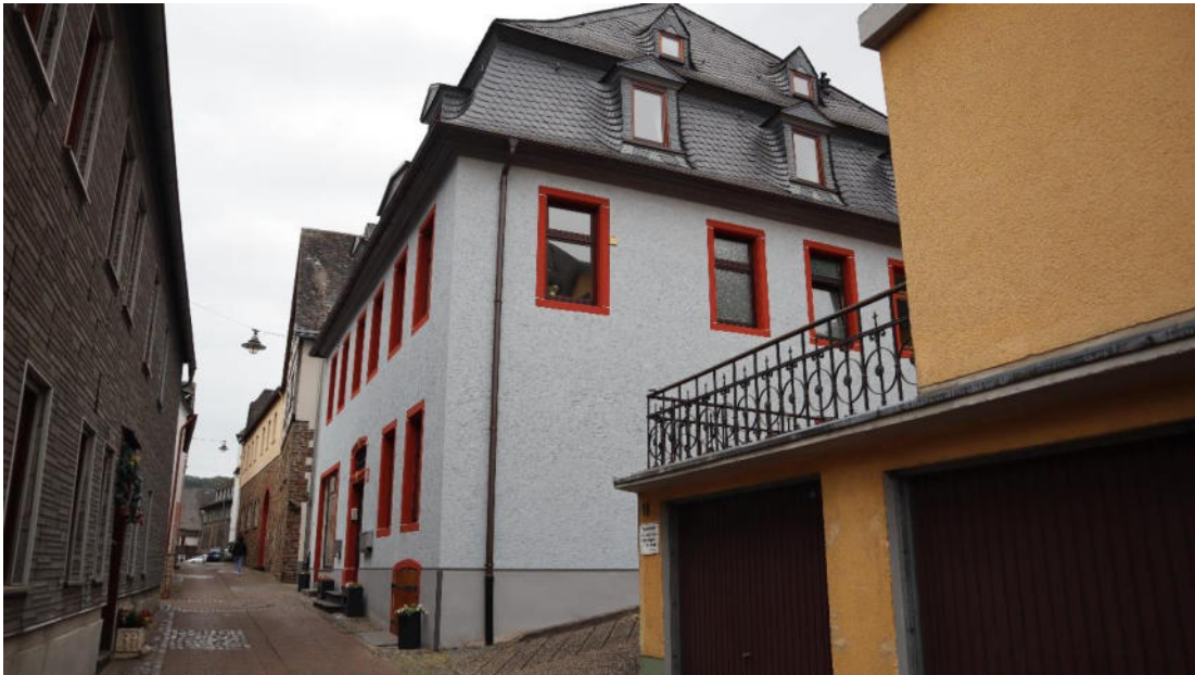
Abb. 113 : Oberstraße 20, Ansicht von Nordwesten.
