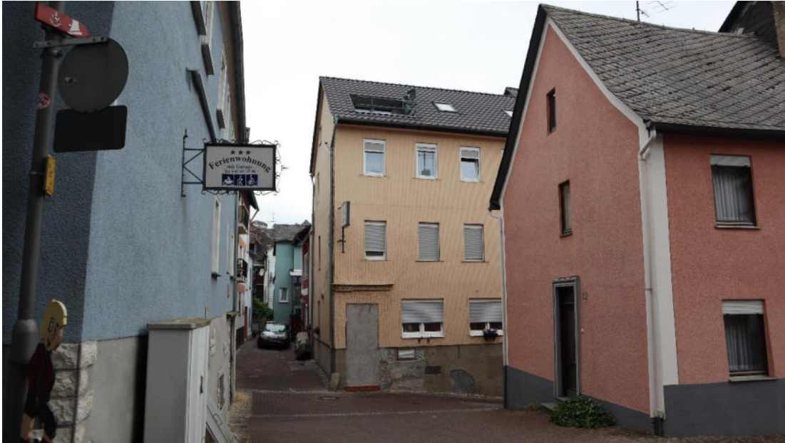
Abb. 177 : Viktor-Napp-Gasse 8, Ansicht von Südosten.
