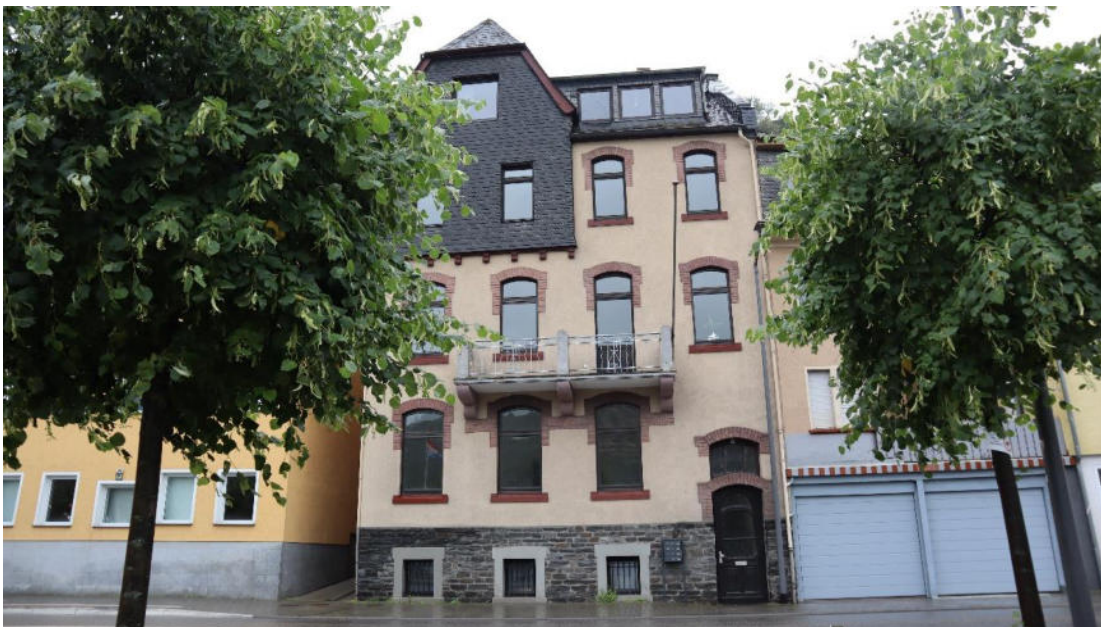
Abb. 24 : Heerstraße 53, Rheinseite, Ansicht von Norden.
