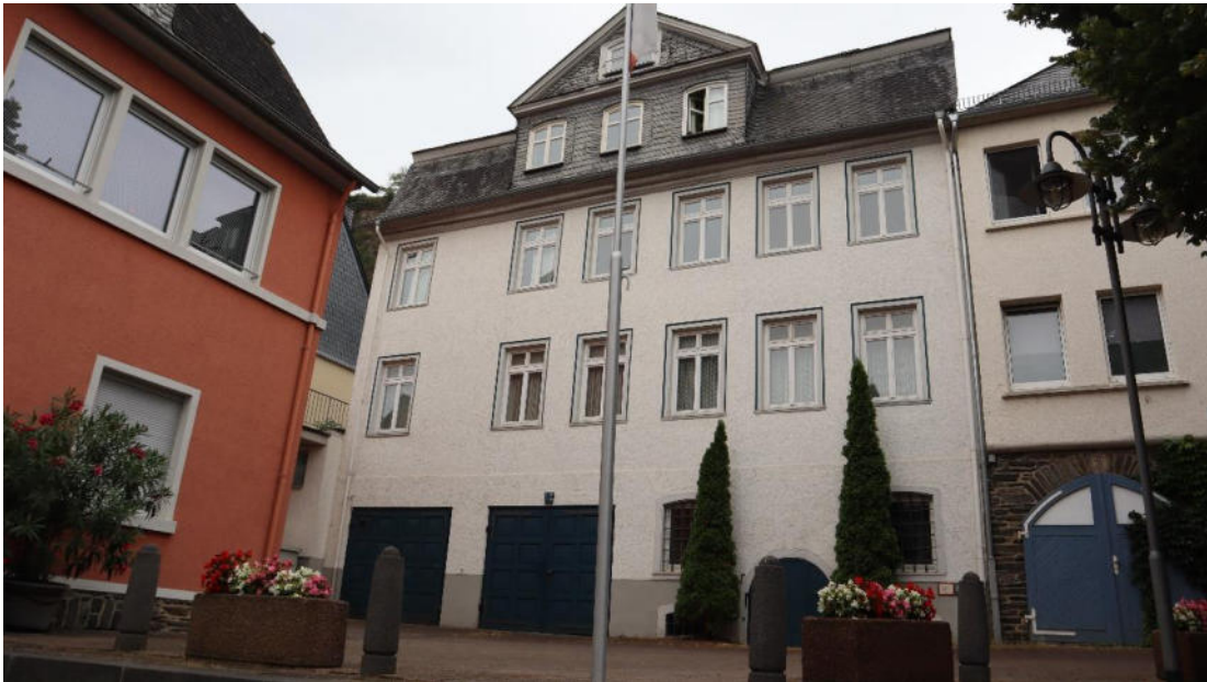
Abb. 119 : Oberstraße 27, Rückansicht vom Kirchplatz aus.
