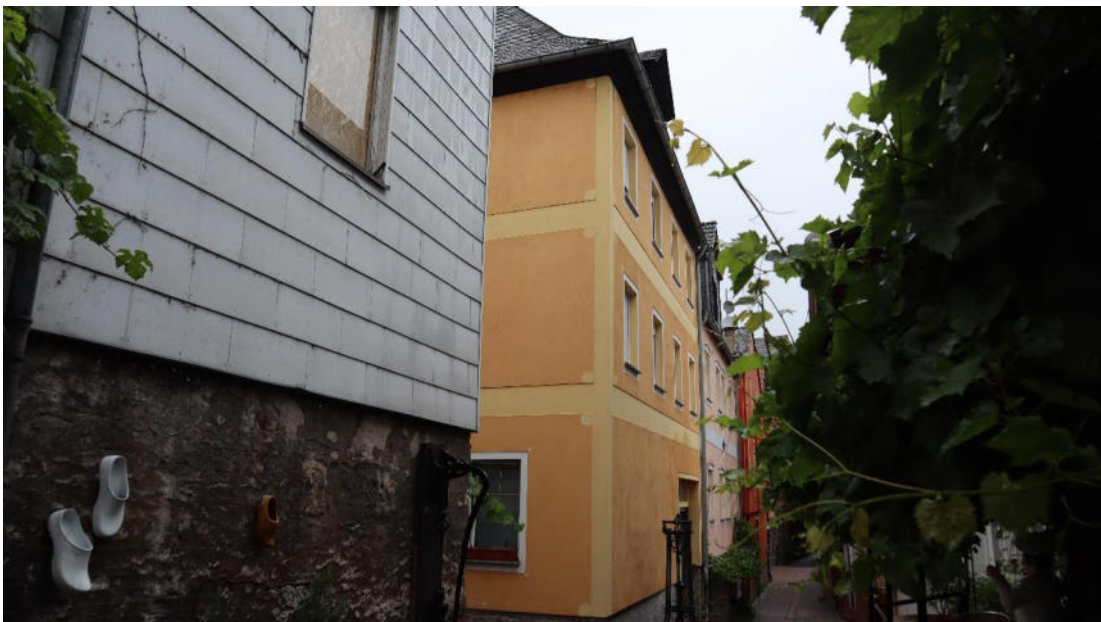
Abb. 78 : Herpellstraße 11, Ansicht von Süden.
