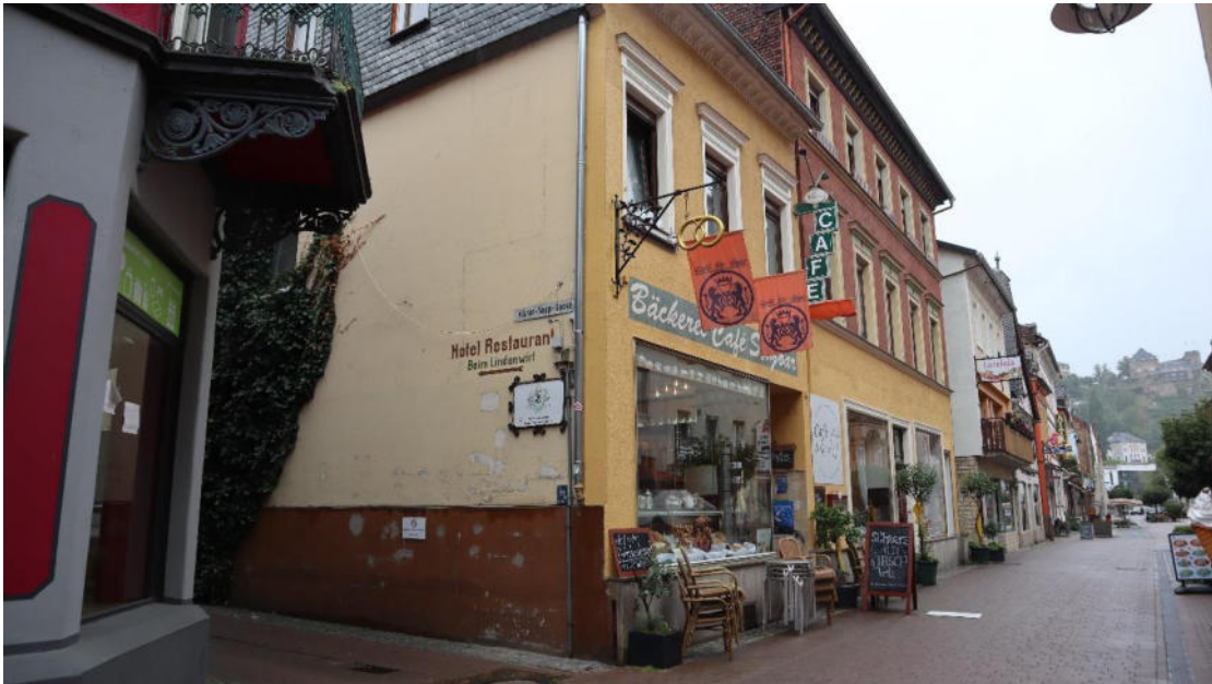
Abb. 43 : Heerstraße 95 und 97 , Ansicht von Nordosten.
