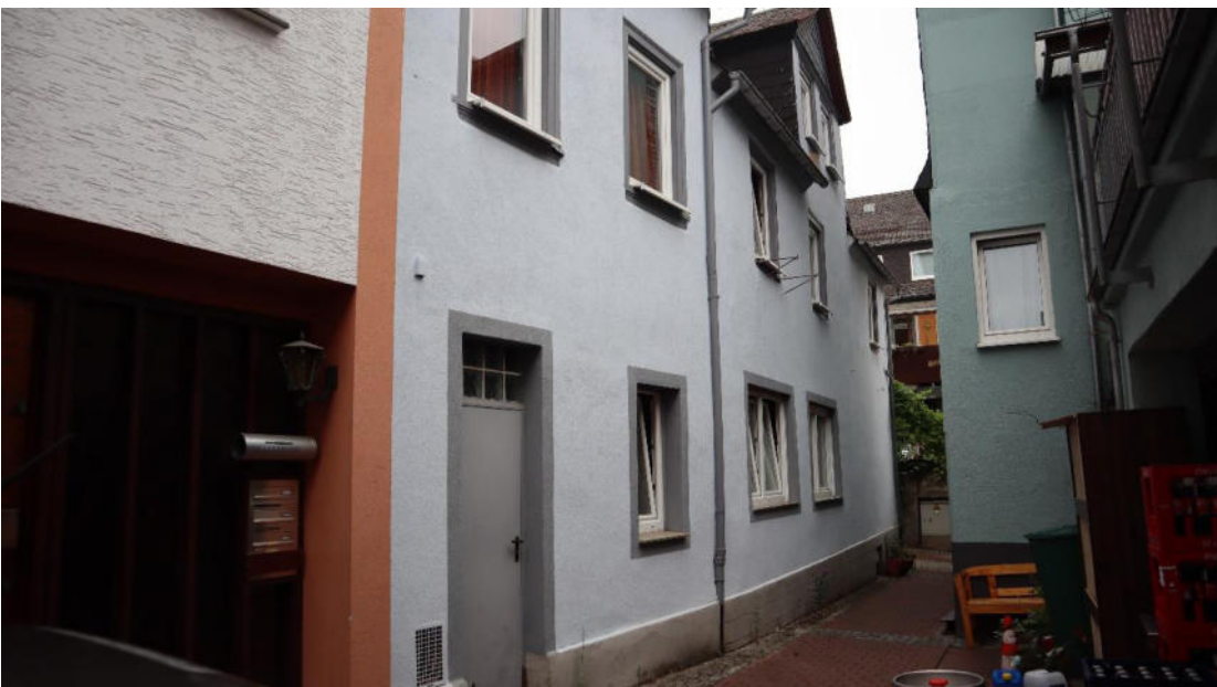
Abb. 154 : Pumpengasse 7, Ansicht von Nordosten, Blick auf Pumpengasse.
