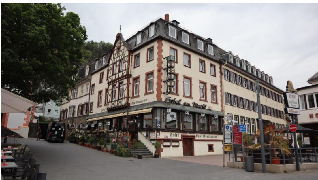
Abb. 96 : Markt 1, Rheinseite, Ansicht von Nordosten.
