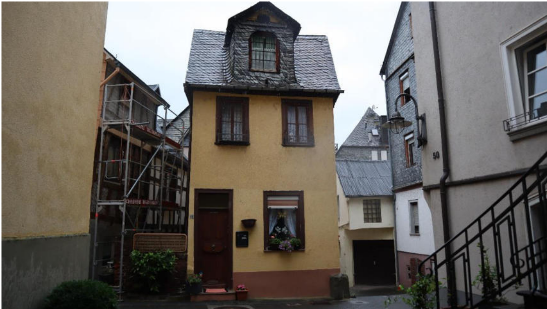
Abb. 137 : Oberstraße 49, Ansicht von Süden.
