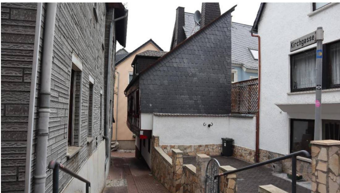
Abb. 82 : Kirchgasse 1, Ansicht von Südwesten.
