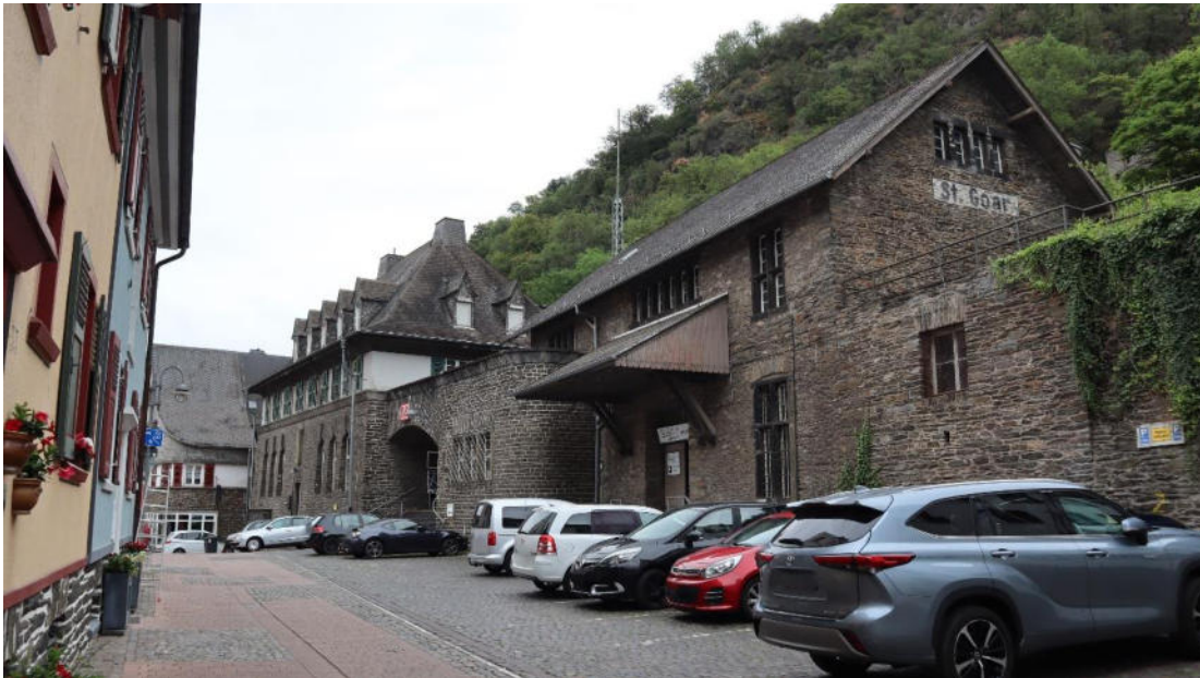
Abb. 123 : Oberstraße 32, Bahnhof, Ansicht von Nordwesten.
