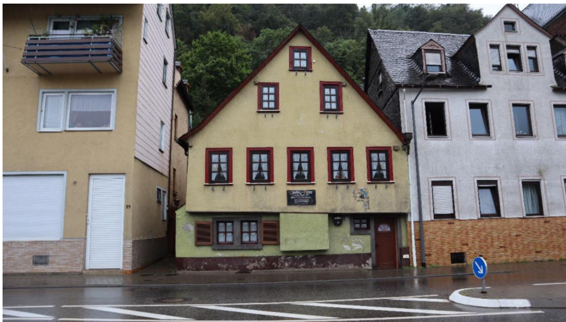
Abb. 22 : Heerstraße 41, Rheinseite, Ansicht von Norden.
