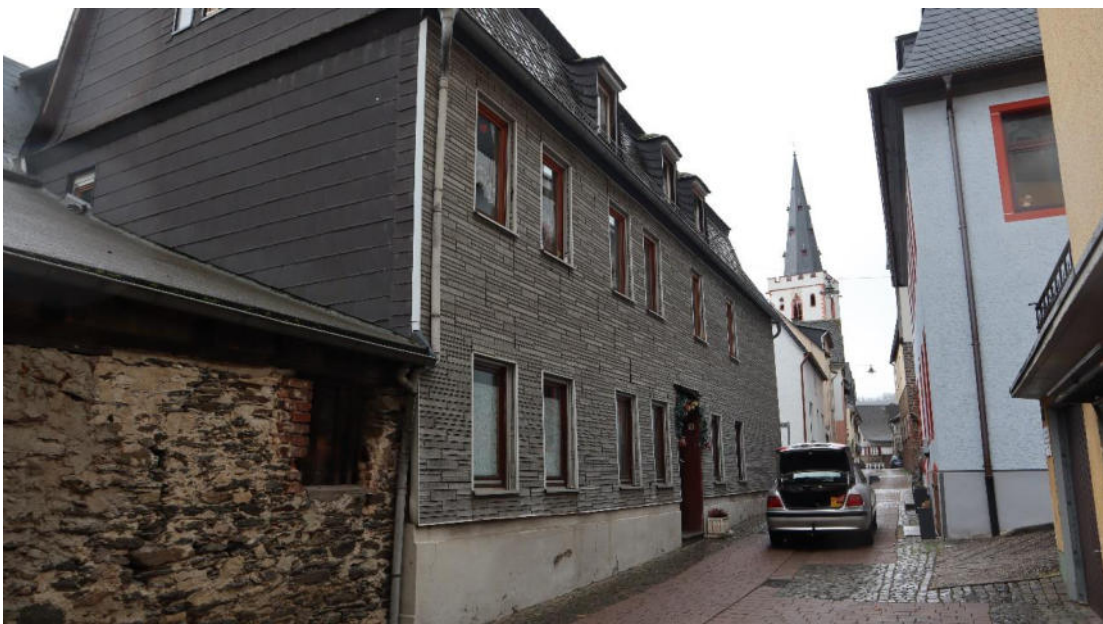
Abb. 112 : Oberstraße 19, Ansicht von Südwesten, im Hintergrund Ev. Stiftskirche.
