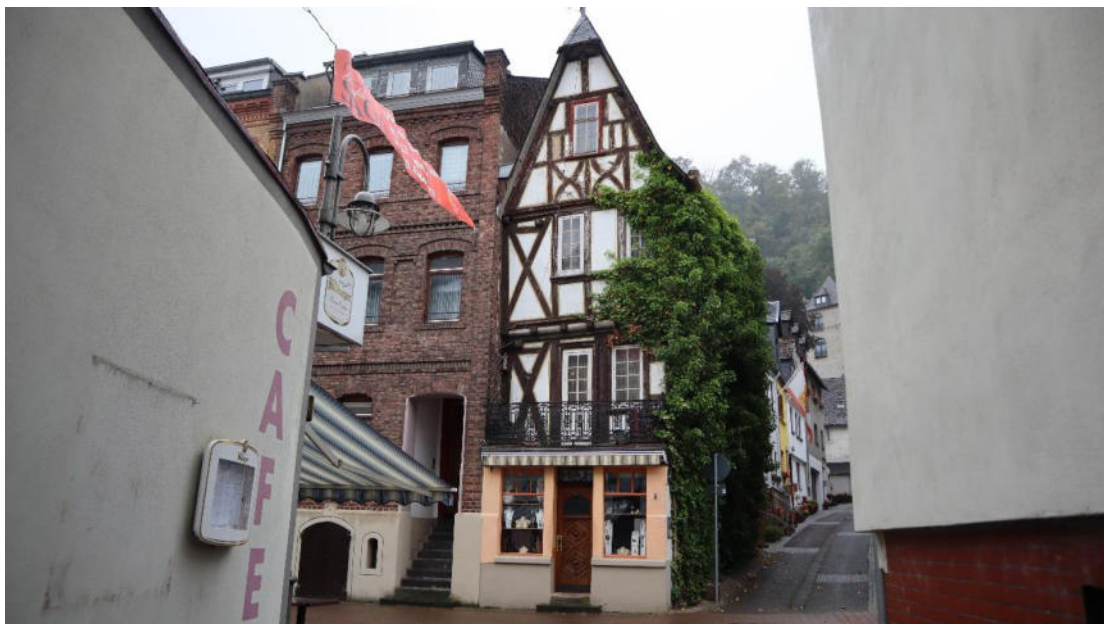
Abb. 66 : Heerstraße 123, Ansicht von Nordwesten.
