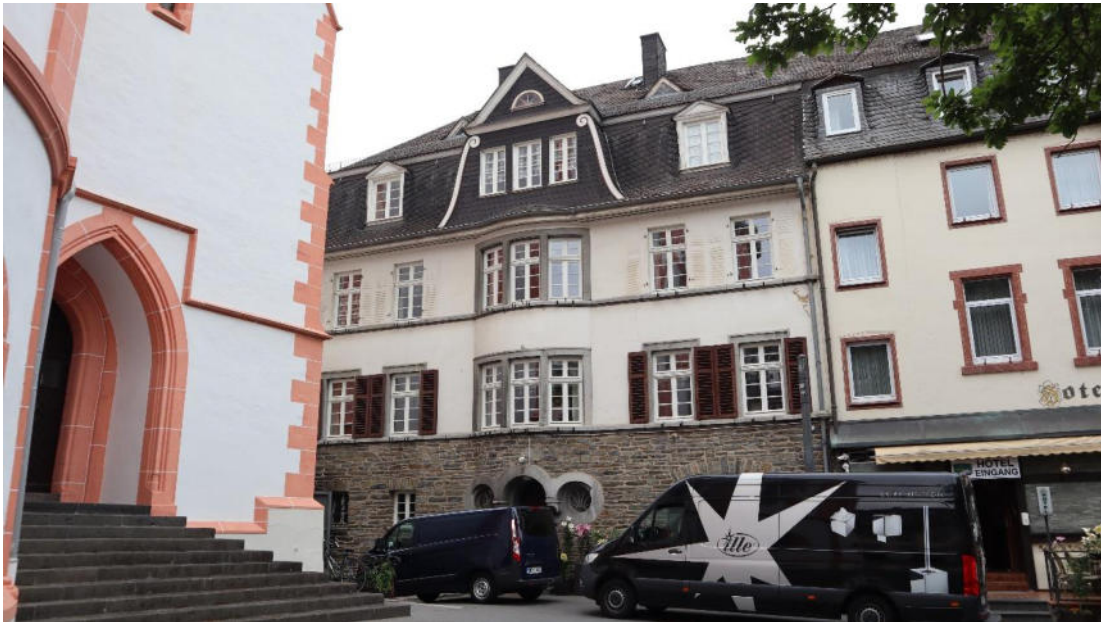
Abb. 97 : Markt 2, Ansicht von Osten.
