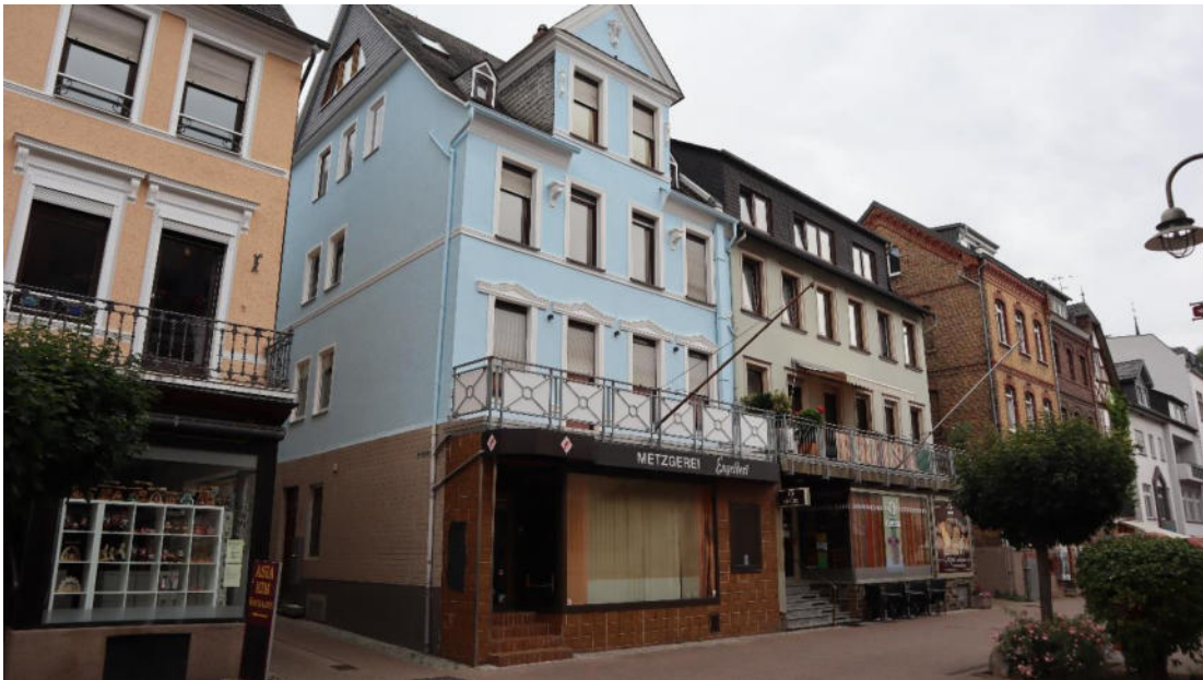
Abb. 57 : Heerstraße 115 und 117 , Ansicht von Nordosten.
