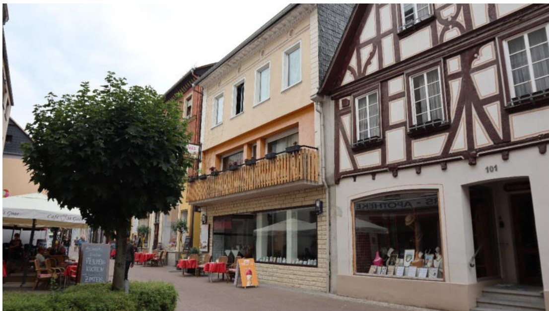
Abb. 44 : Heerstraße 99, Ansicht von Nordwesten.
