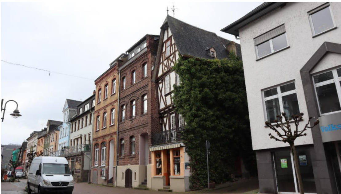
Abb. 64 : Heerstraße 119, 121 und 123 , Ansicht von Nordwesten.
