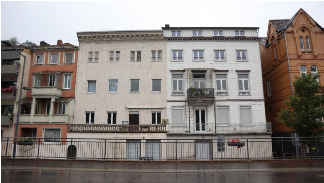
Abb. 47 : Heerstraße 100 und 102 , Rheinseite, Ansicht von Norden.
