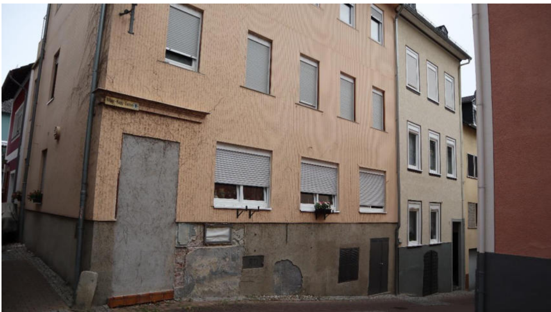
Abb. 176 : Viktor-Napp-Gasse 6, Ansicht von Südosten.
