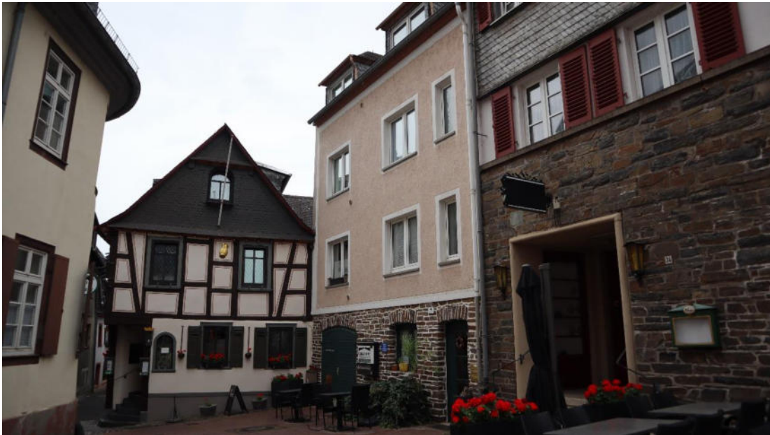
Abb. 127 : Oberstraße 36, Ansicht von Nordwesten.
