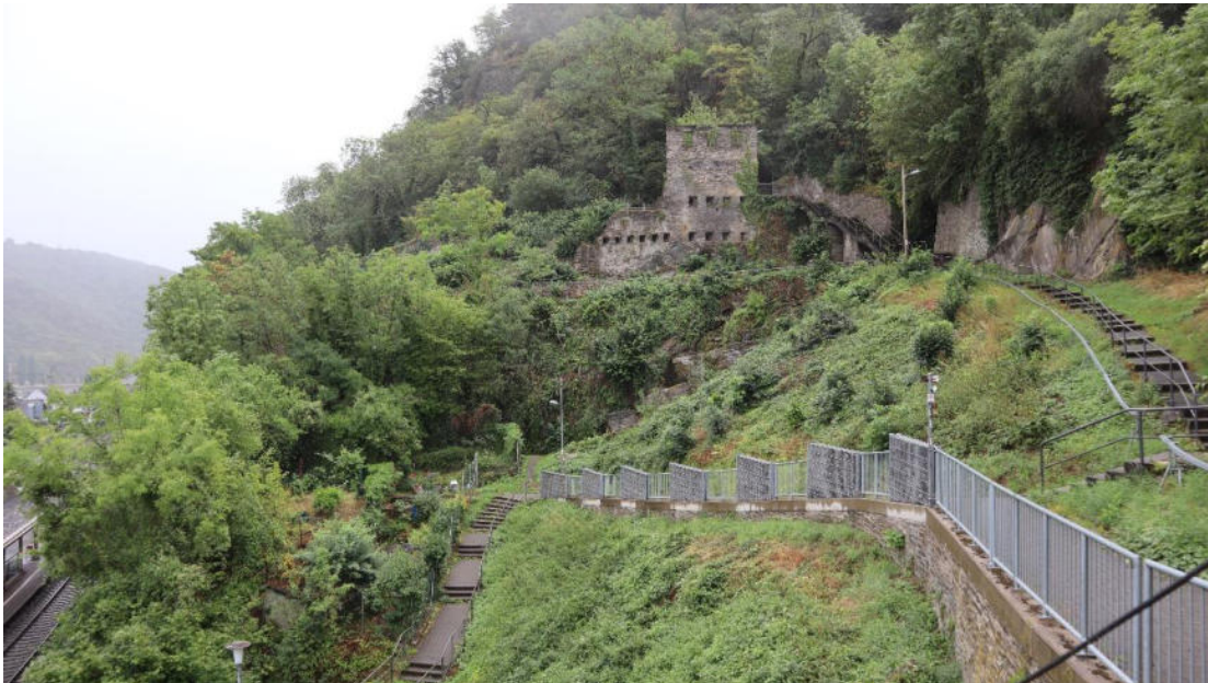
Abb. 5 : Reste der Stadtbefestigung, Ansicht von Nordwesten, Blick auf das Große Blockhaus oberhalb des Bahnhofs.
