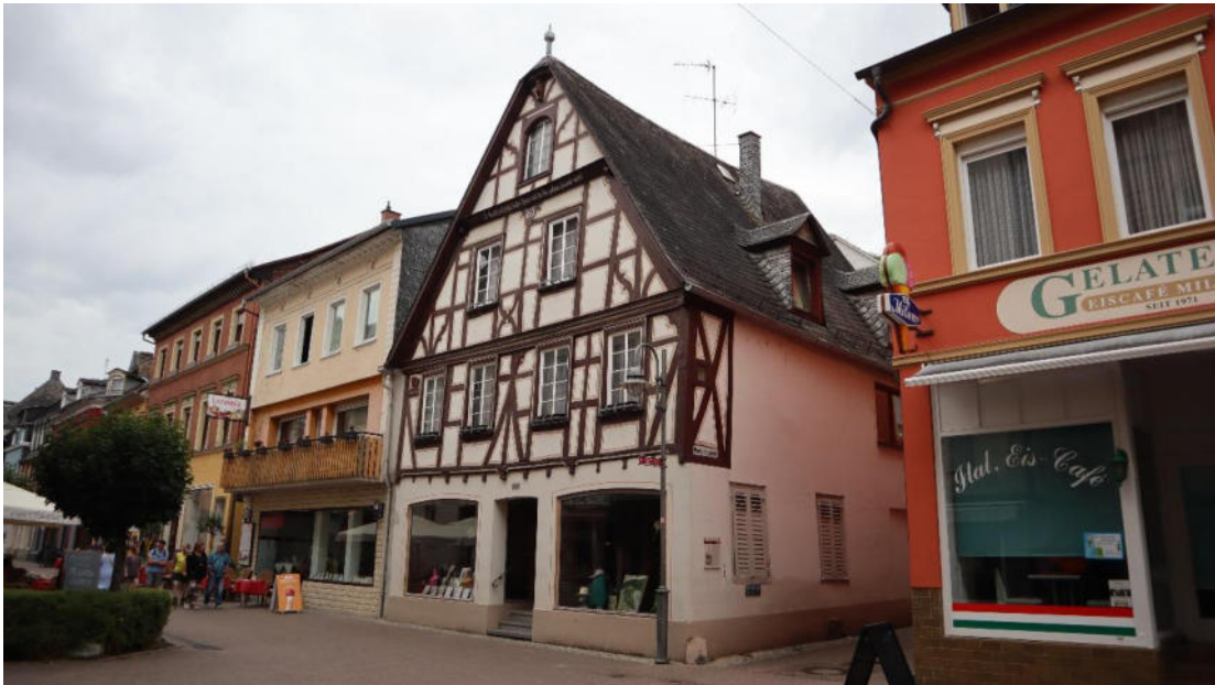
Abb. 45 : Heerstraße 101, Ansicht von Nordwesten.
