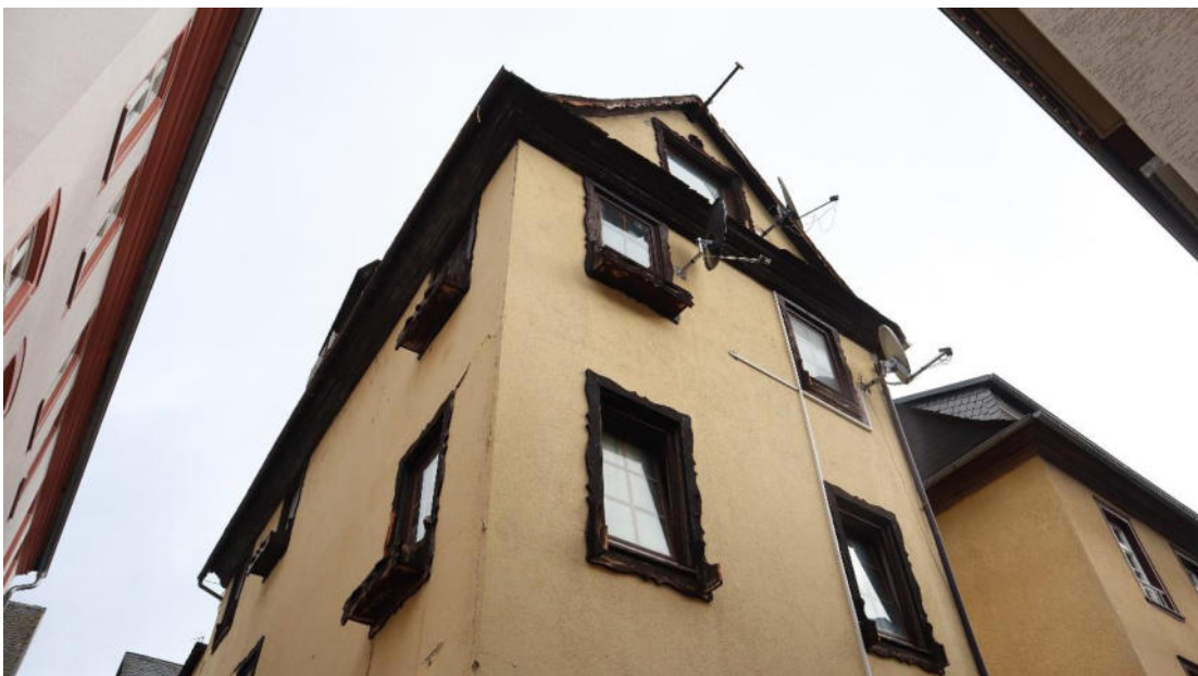
Abb. 76 : Herpellstraße 5, Ansicht von Westen.
