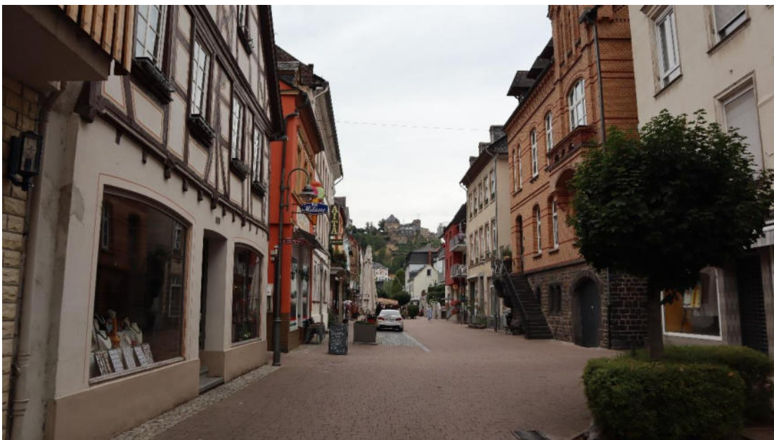
Abb. 18 : Heerstraße, Straßenansicht von Südosten, Blick auf Burg Rheinfels.
