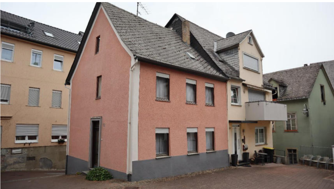
Abb. 94 : Kirchplatz 12, Ansicht von Südosten.
