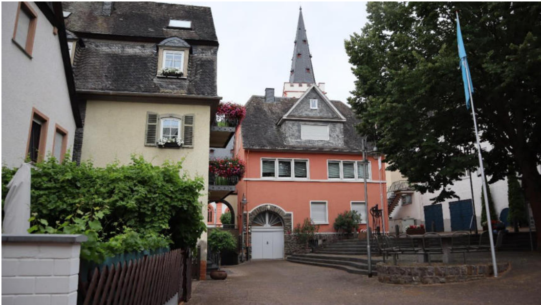
Abb. 87 : Kirchplatz 5, Ansicht von Nordwesten.
