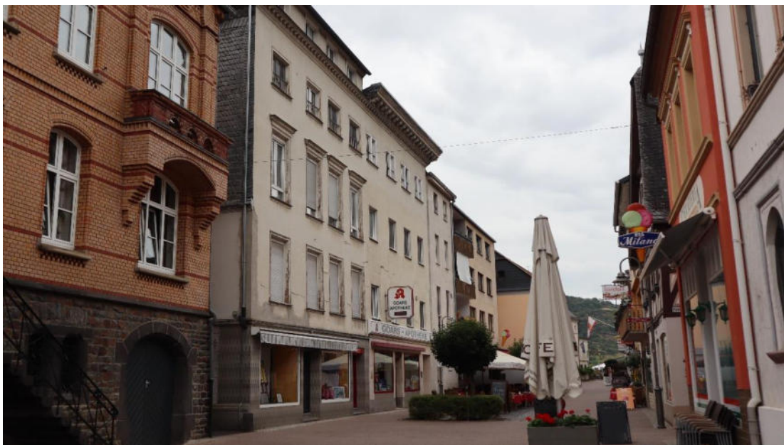
Abb. 46 : Heerstraße 102 und 100 , Ansicht von Nordosten.
