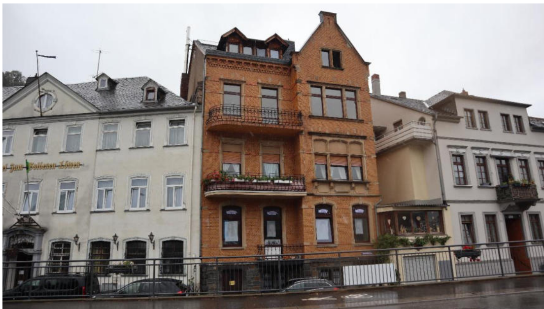
Abb. 36 : Heerstraße 84, Rheinseite, Ansicht von Norden.
