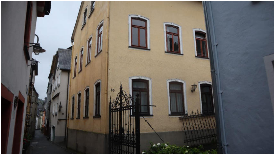
Abb. 133 : Oberstraße 46, Ansicht von Nordwesten.
