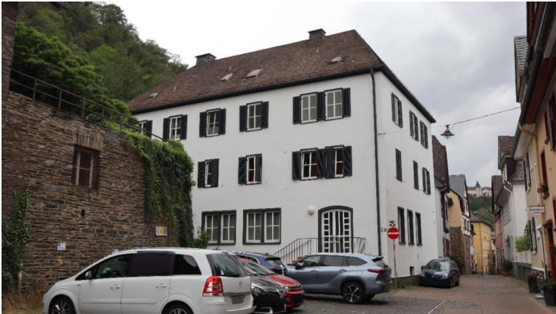
Abb. 121 : Oberstraße 28, Ansicht von Nordosten.
