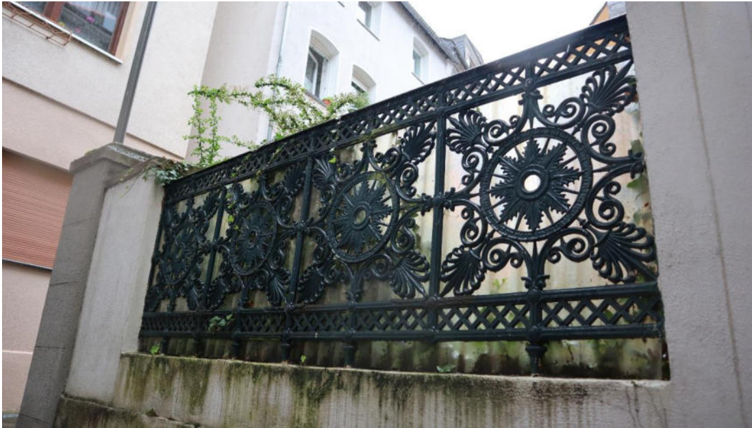
Abb. 25 : an Heerstraße 53, gusseisernes Geländer, Sayner Hütte.
