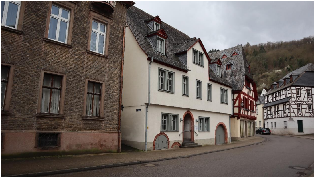
Abb. 9 : Chablisstraße 2, Ansicht von Norden.
