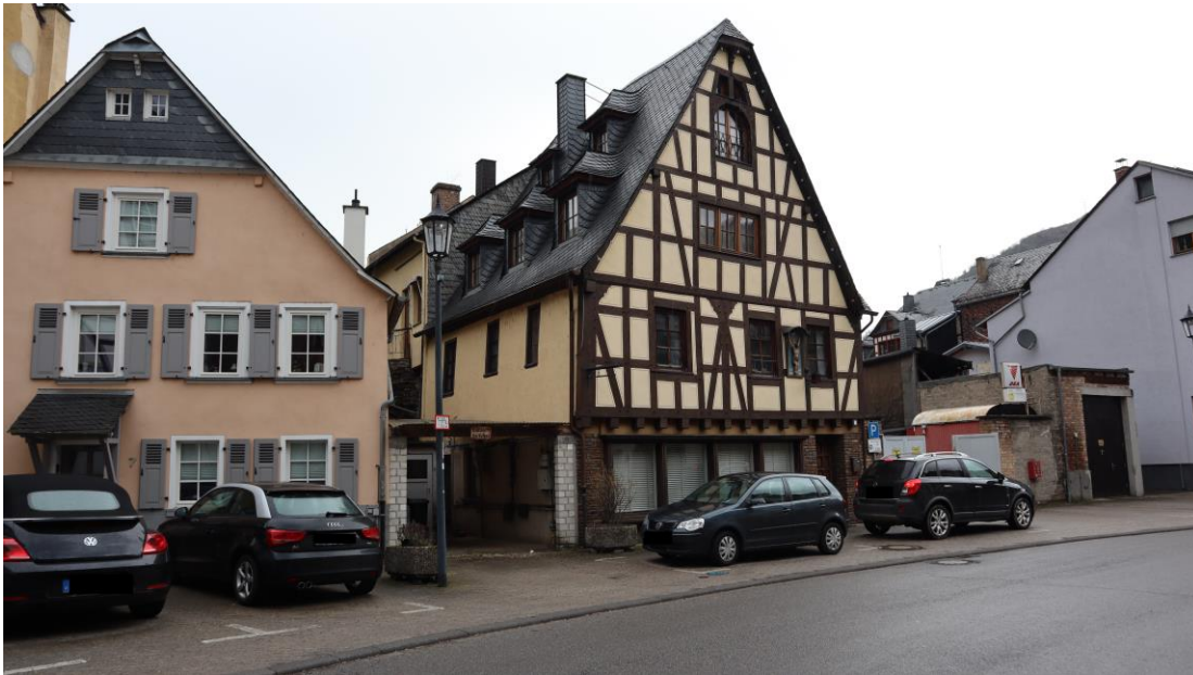
Abb. 11 : Chablisstraße 5, Ansicht von Süden.
