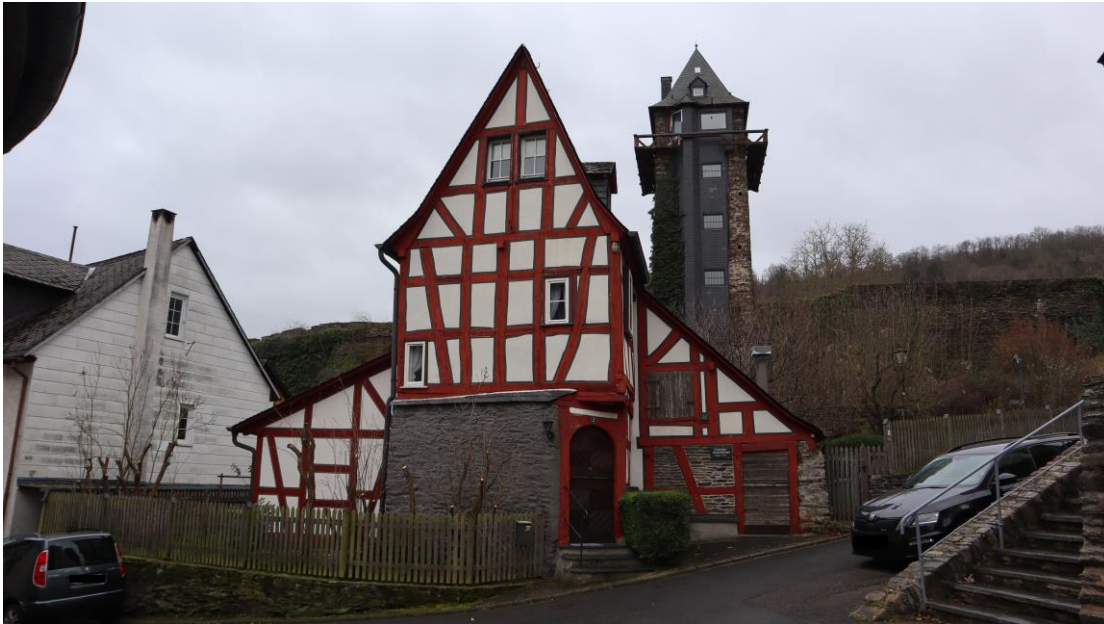
Abb. 47 : Martinsberg 3, ehem. Küsterhäuschen mit Michelfeldturm I im Hintergrund, Ansicht von Nordosten.
