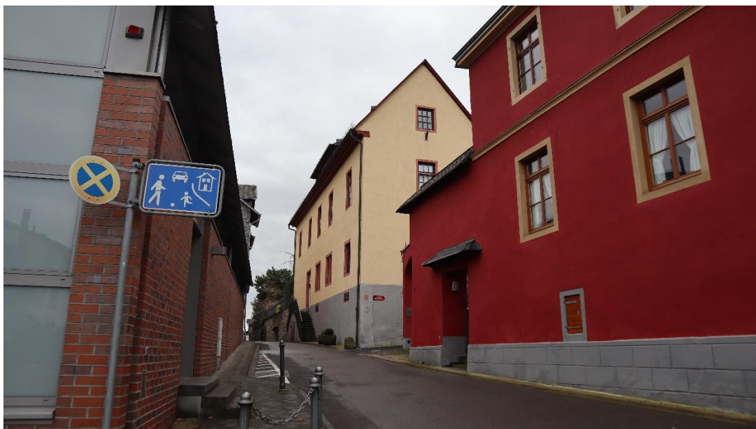
Abb. 54 : Oberstraße 11, ehem. Lateinschule, Ansicht von Nordwesten.
