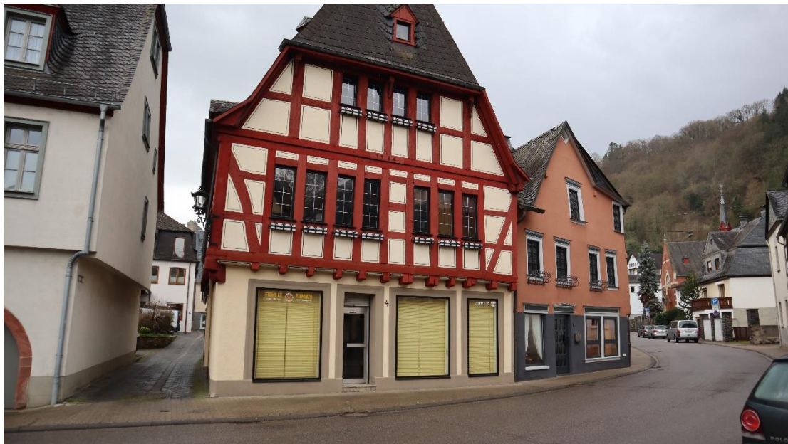
Abb. 10 : Chablisstraße 4, Ansicht von Norden.
