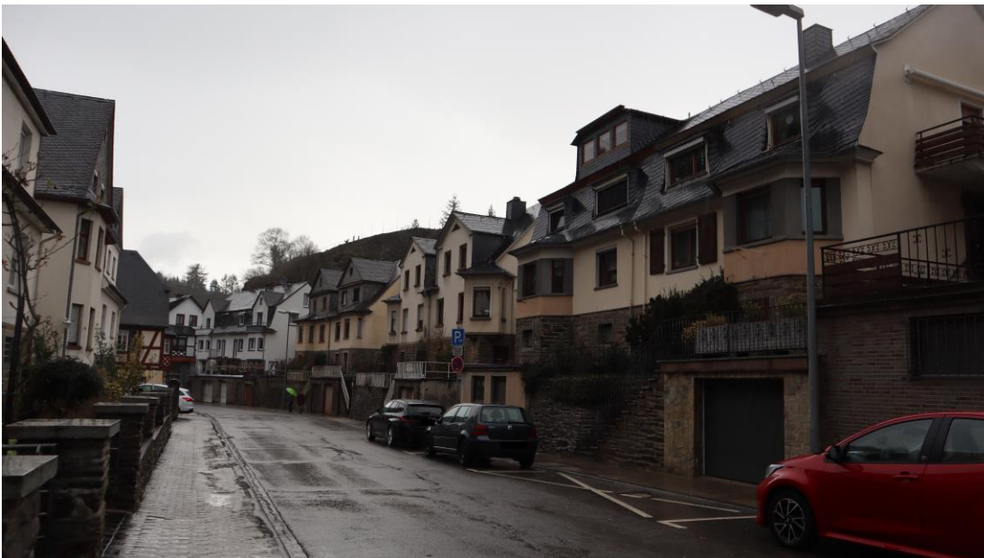
Abb. 16 : Chablisstraße 54-68, Ansicht von Süden.
