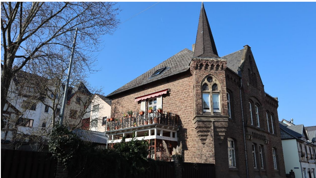
Abb. 34 : Liebfrauenstraße 17, Ansicht von Osten.
