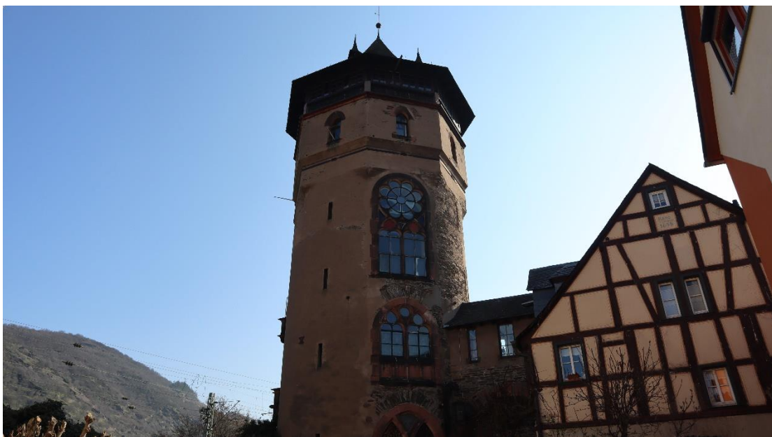
Abb. 68 : Unterstraße, Haagsturm/Roter Turm, Ansicht von Nordwesten.
