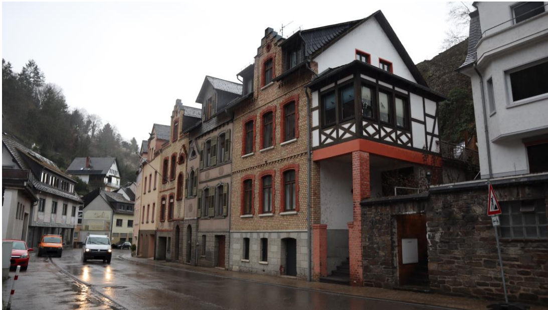
Abb. 15 : Chablisstraße 44, 46, 48, 50 und 52, Ansicht von Süden.
