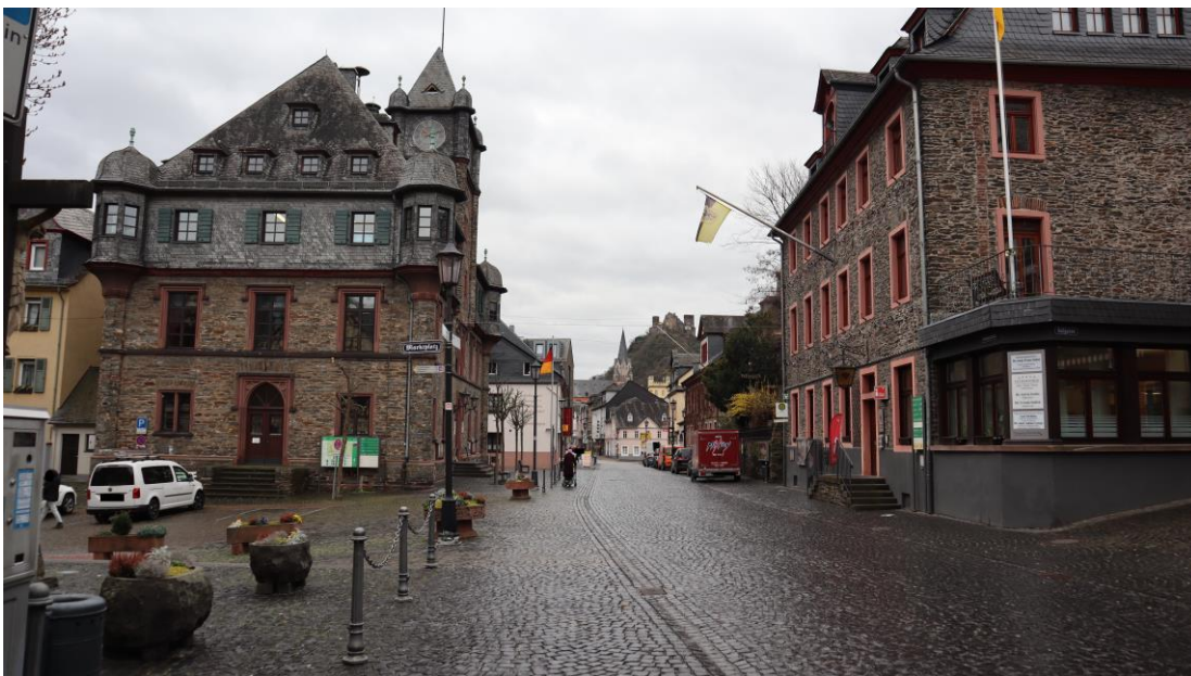
Abb. 56 : Rathausstraße 6 (Rathaus) und 3, Richtung Südosten.
