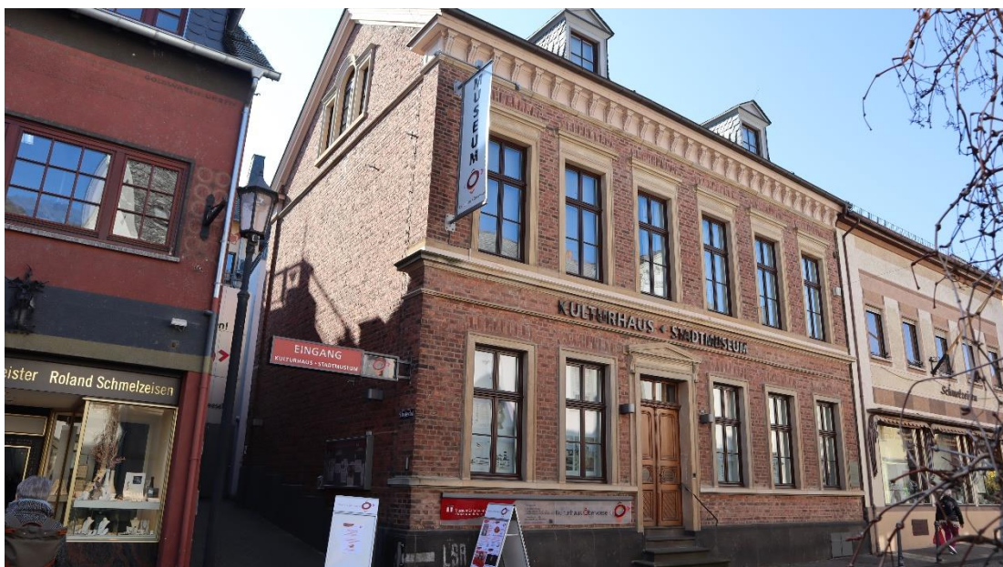
Abb. 62 : Rathausstraße 23, Ansicht von Osten.
