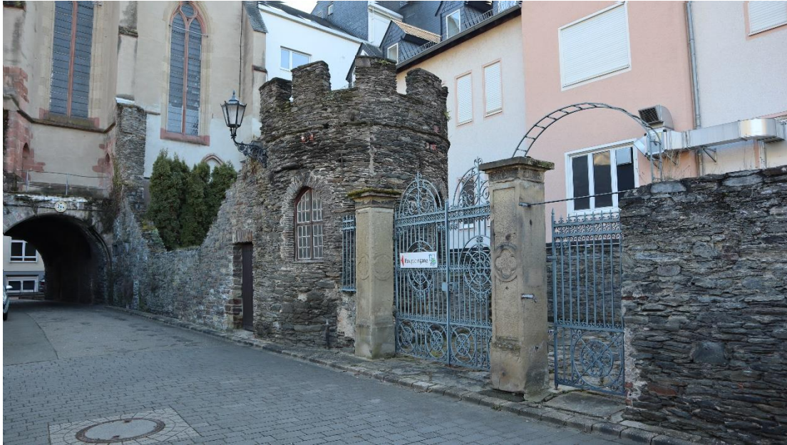
Abb. 73: Wernerstraße, Stadtmauerreste, Ansicht von Norden.
