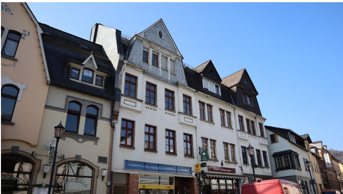
Abb. 60 : Rathausstraße 9, 11, 13 und 15, Ansicht von Südosten.
