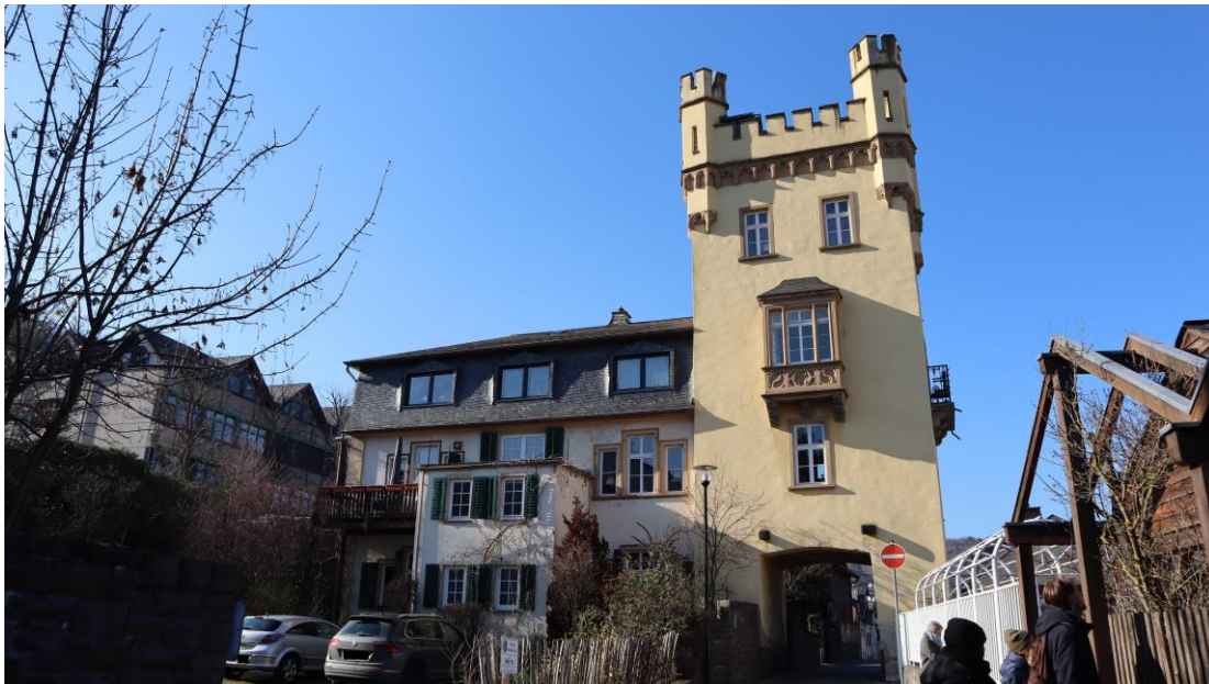
Abb. 21: Bei Kirchstraße 55, weißer Turm der Stadtbefestigung, Ansicht von Südosten.
