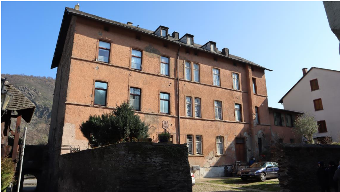
Abb. 69 : Unterstraße 8, Ansicht von Westen.
