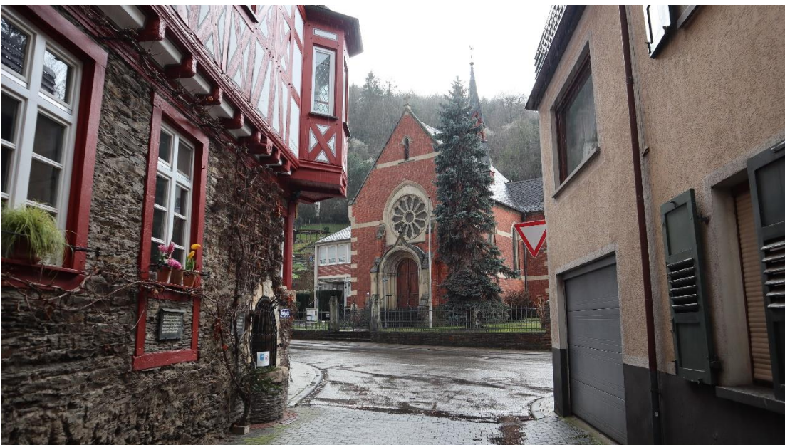
Abb. 14 : Chablisstraße 21, Ev. Kirche, Ansicht von Osten.
