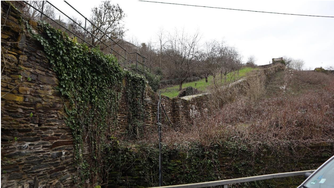
Abb. 51 : Niederbachstraße, Stadtmauer und Niederburger Turm, Ansicht von Südwesten.
