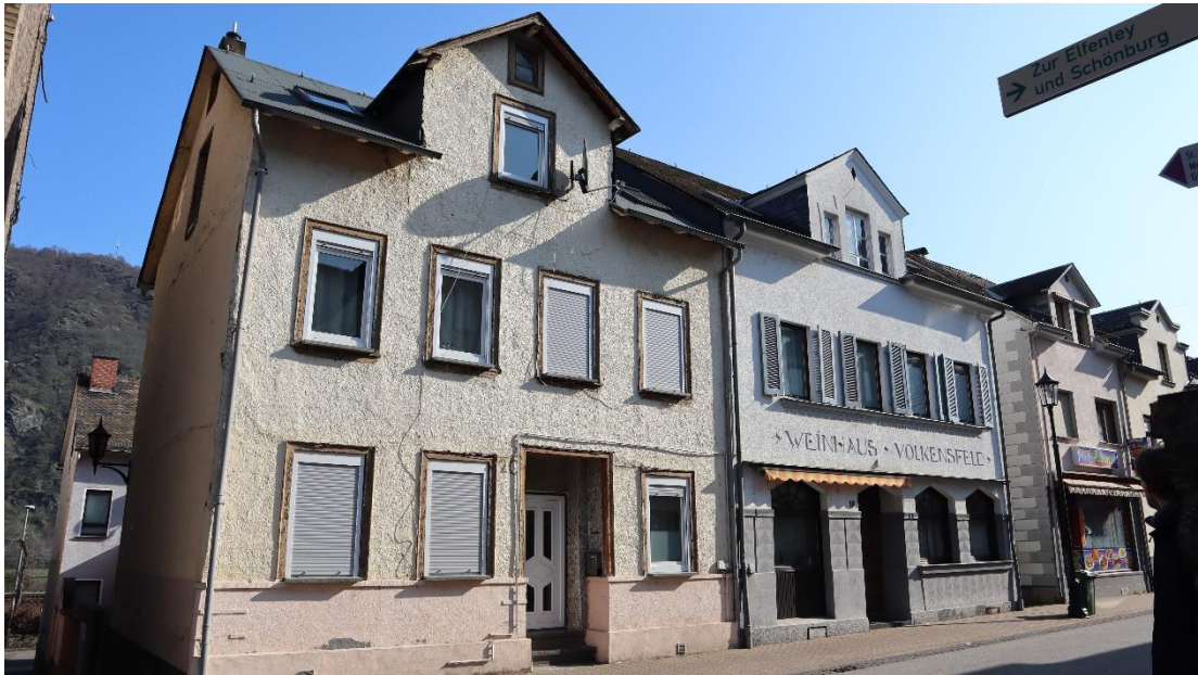
Abb. 35 : Liebfrauenstraße 18 und 20, Ansicht von Westen.
