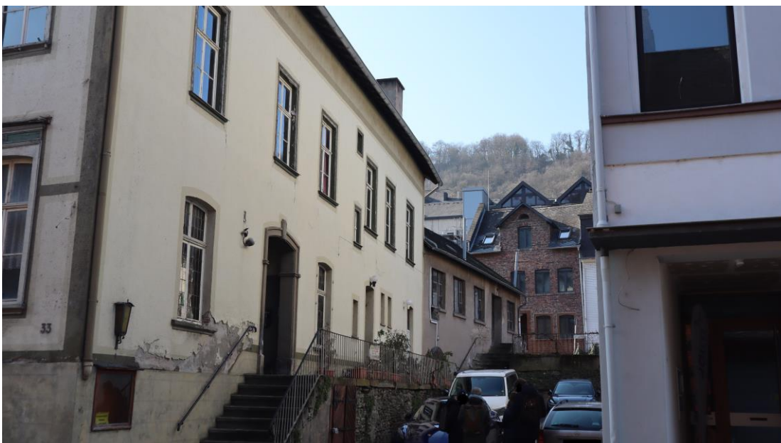
Abb. 38 : Liebfrauenstraße 33, Ansicht von Norden.
