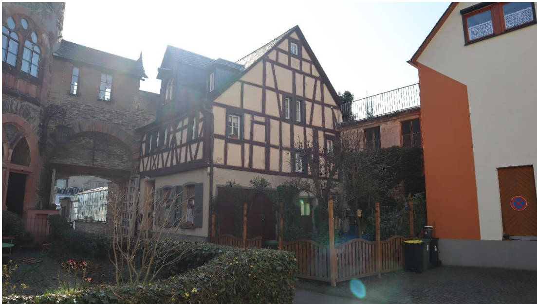
Abb. 67 : Unterstraße 1, Stadtmauerpforte mit Haagsturm/Rotem Turm, Richtung Südosten.
