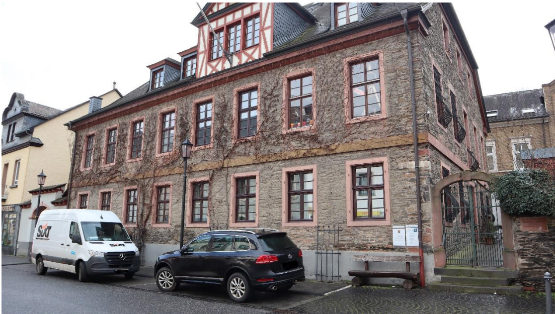
Abb. 57 : Rathausstraße 1A, Ansicht von Norden.
