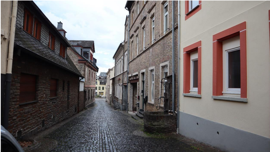
Abb. 53 : Oberstraße 1, 2, 3 und 5, Brunnenanlage mit Schwengelpumpe, Ansicht von Nordwesten.
