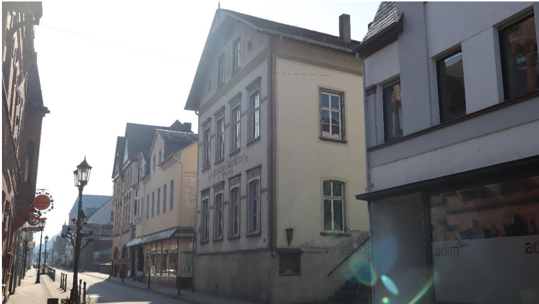
Abb. 37 : Liebfrauenstraße 33, Ansicht von Norden.
