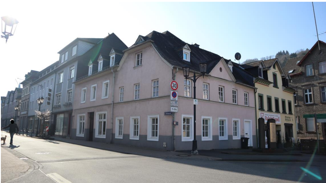
Abb. 40 : Liebfrauenstraße 49, Ansicht von Norden.
