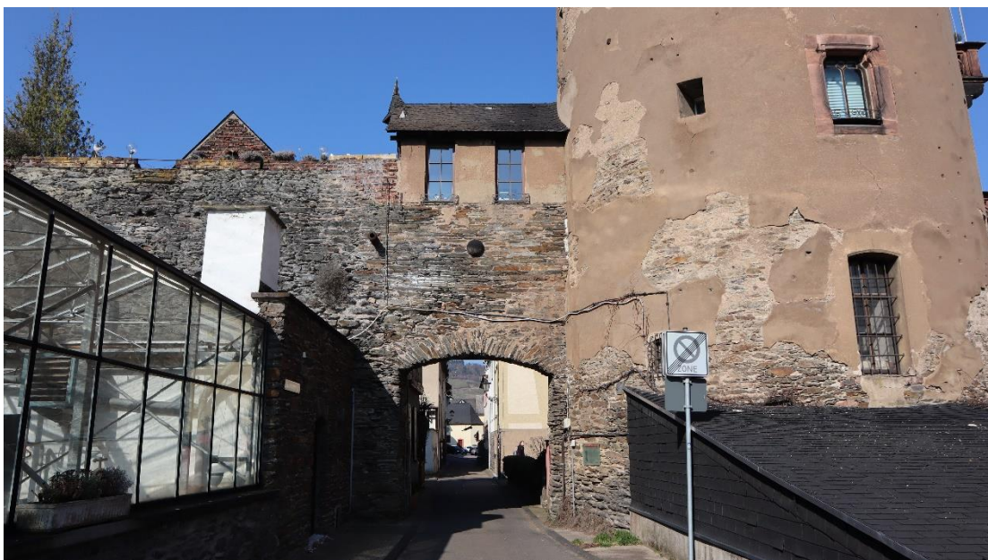
Abb. 66: Unterstraße, Stadtmauerforte mit Haagsturm/Rotem Turm, Richtung Nordwesten.
