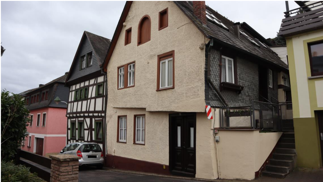
Abb. 17 : Heumarkt 15 und 17, Ansicht von Norden.
