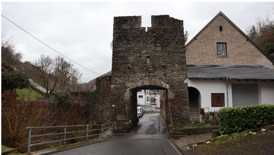
Abb. 50 : Niederbachstraße 29 mit Mühlentorturm, Ansicht von Westen.
