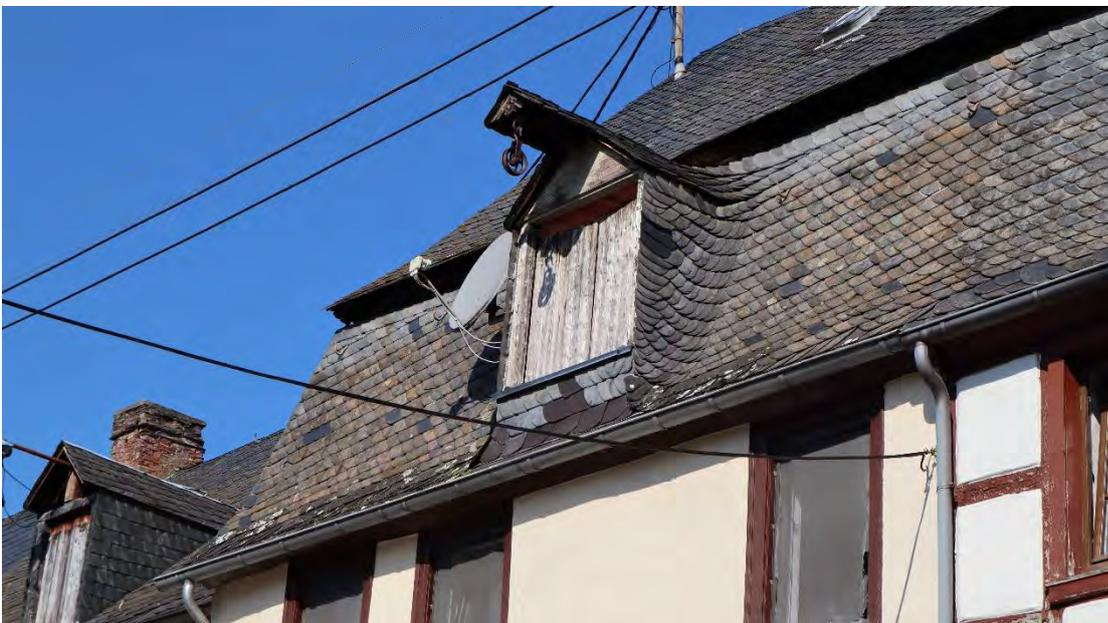
Abb. 64: Pützstraße 13, Detailansicht der Ladeluke mit Flaschenzug am Mansarddach
