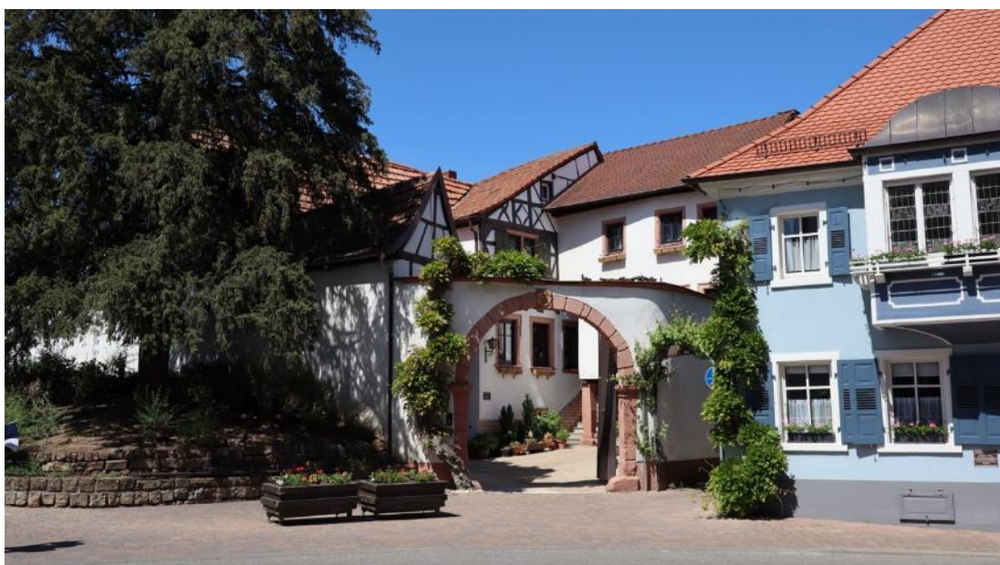
Abb. 86: Weinstraße Nord 25 & 27, Ansicht von Südosten, Blick auf Einfahrtssituation zum gemeinsamen Hof, rechts im Bild Nr. 33.
