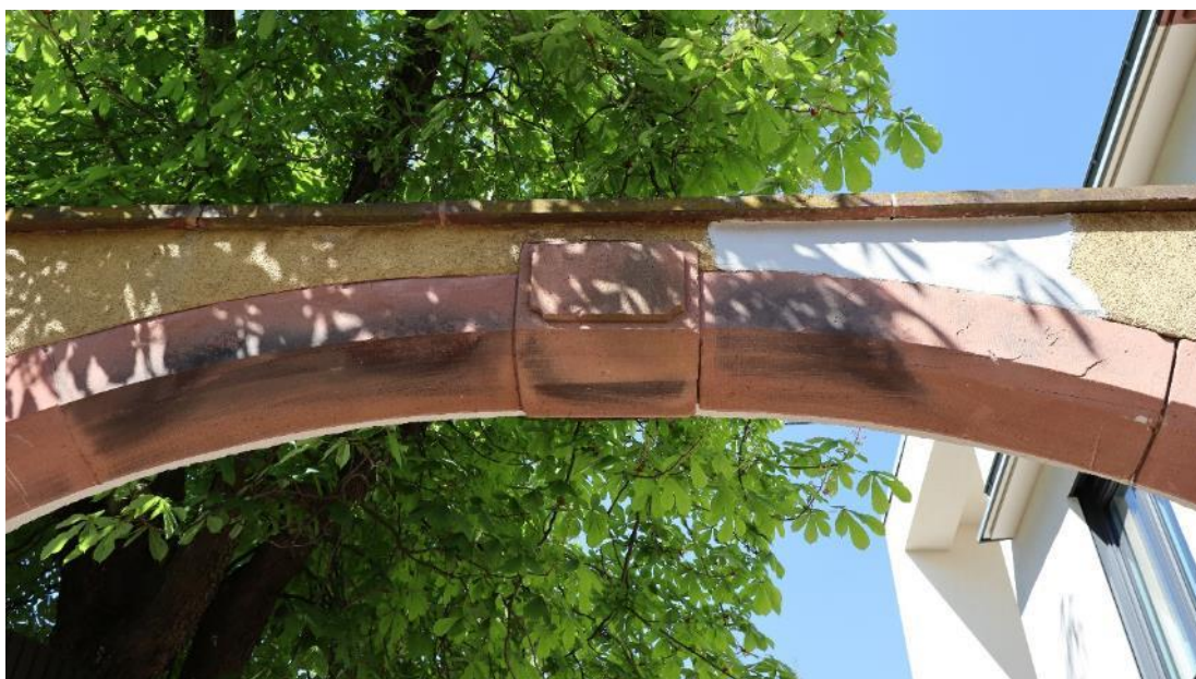
Abb. 102: An Weinstraße Süd 6, Detailaufnahme Renaissance-Torbogen (erneuert).
