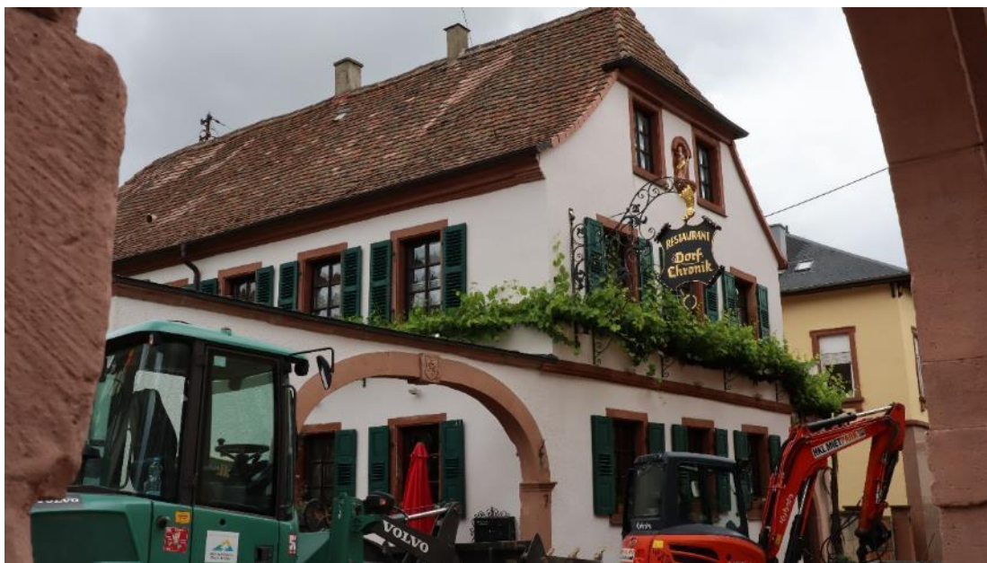
Abb. 45: Marktstr. 7, Ansicht von Südwesten, Wohnhaus mit angrenzendem Korbbogen.
