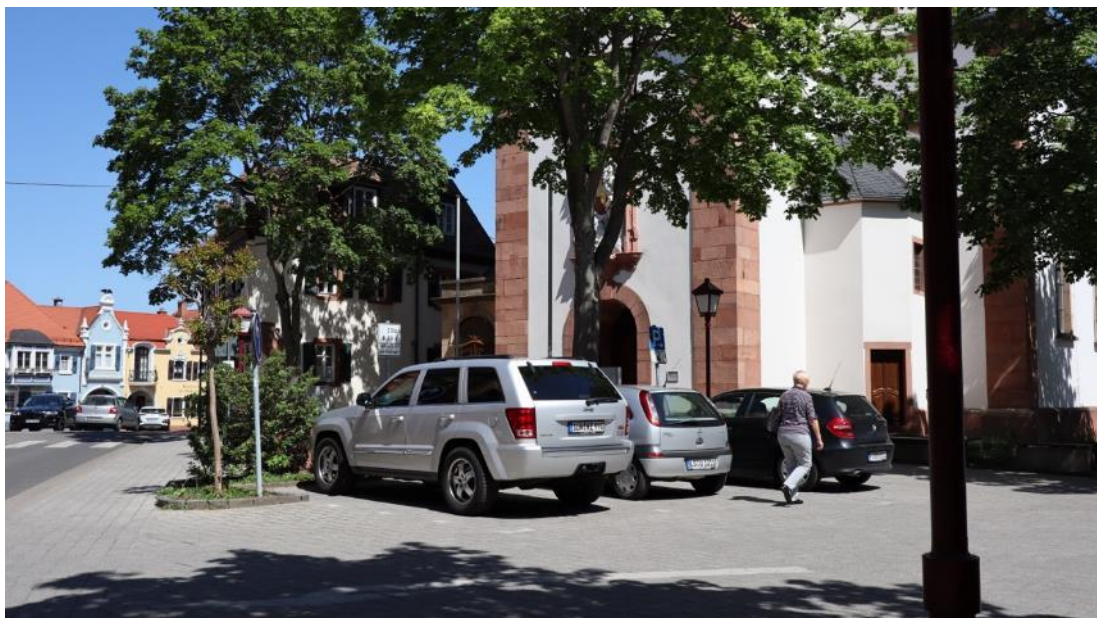
Abb. 80: Weinstraße Nord 18, Pfarrkirche Sankt Kosmas und Damian, Ansicht von Südwesten mit Blick auf Kirchenvorplatz und Westportal.
