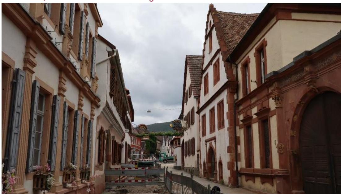
Abb. 32: Marktstraße, Straßenansicht von Osten in Richtung Marktplatz, rechts Nr. 5 mit Torfahrt, gegenüber Nr. 8 (sogenanntes. Haus Rassiga)..
