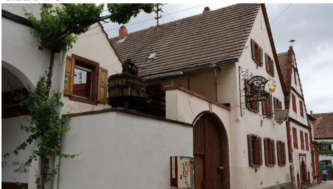
Abb. 38: Marktstr. 3, Ansicht von Südwesten, Wohnhaus mit angrenzender Torfahrt, Um-mauerung und Nebengebäude, linker Bildrand Arkade von Nr. 1, im Hintergrund Nr. 5
