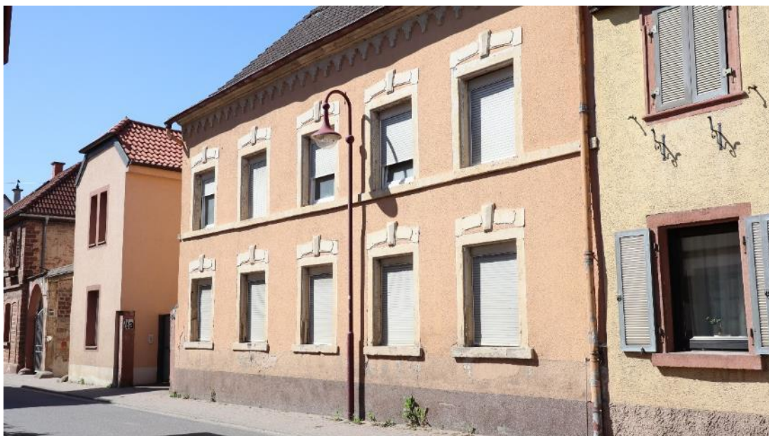
Abb. 117: Weinstraße Süd 26, Ansicht von Nordosten.
