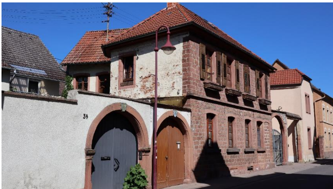
Abb. 119: Weinstraße Süd 32, Ansicht von Südosten, links angrenzend Torfahrt (Doppeltoranlage mit Nr. 34 bildend).
