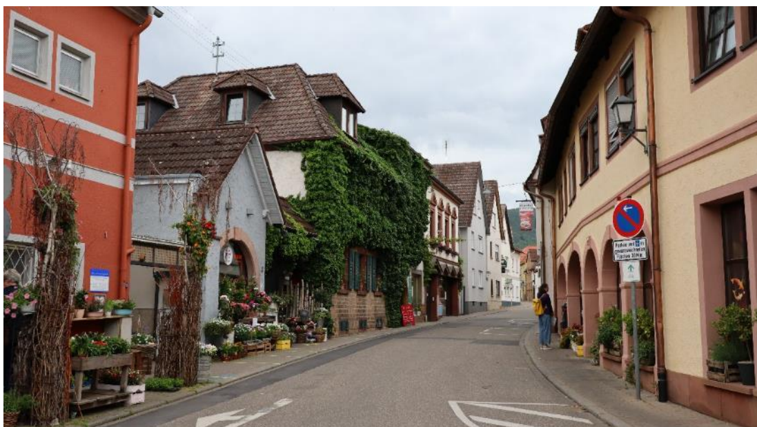
Abb. 52: Sankt-Martiner-Straße, Straßenansicht vom Marktplatz nach Westen in Richtung Kalmit.
