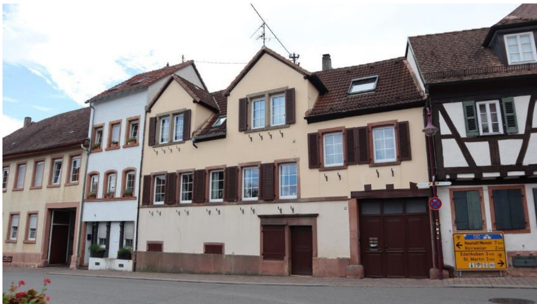
Abb. 85: Weinstraße Nord 22 & 24, Ansicht von Westen, rechts angrenzend Nr. 20.
