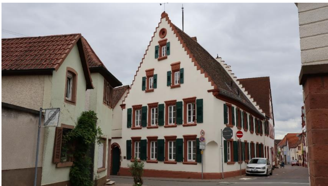
Abb. 18: Hartmannstr. 7, Ansicht von Nordwesten mit Blick in die Friedhofstraße, Wohnhaus mit Portal links daneben.
