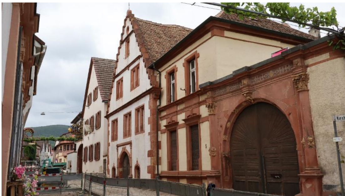
Abb. 41: Marktstr. 5, Ansicht von Südosten mit Blick Richtung Marktplatz. Von links nach rechts: Renaissance-Wohnhaus, Gründerzeit-Gebäude, Toranlage.
