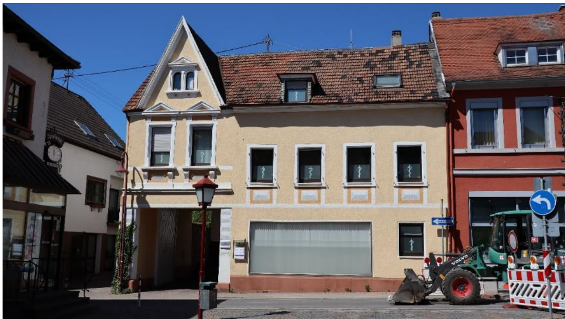
Abb. 97: Weinstraße Süd 2, Ansicht von Osten vom Marktplatz aus, rechts angrenzend Hartmannstr. 1.
