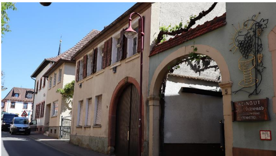
Abb. 98: Weinstraße Süd 3, Ansicht von Südwesten, rechts angrenzend Torfahrt Nr. 5.
