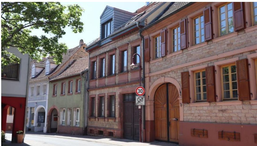
Abb. 77: Weinstraße Nord 13 & 15, Ansicht von Nordosten, rechts im Bild Nr. 17.
