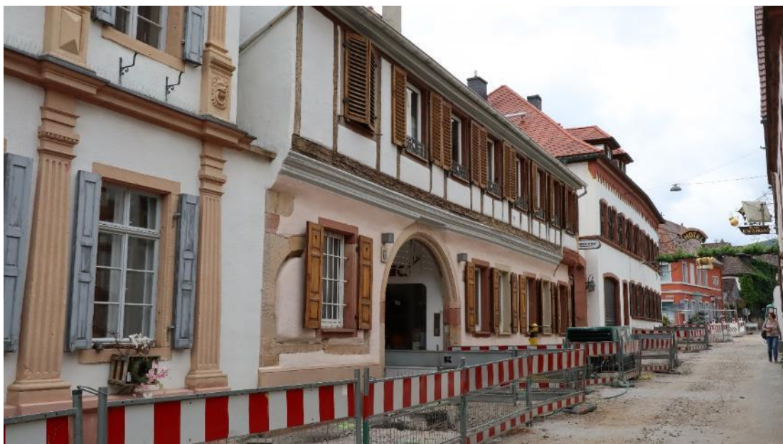
Abb. 43: Marktstr. 6, Ansicht von Nordosten mit Blick Richtung Markplatz, links Nr. 8 (Haus Rassiga).
