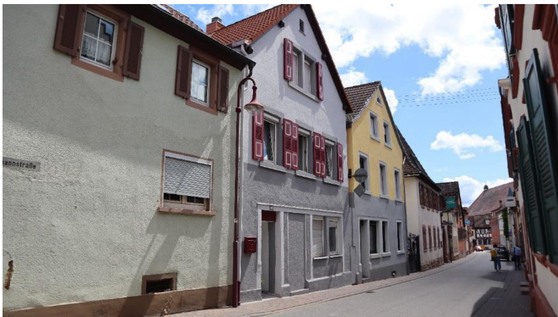
Abb. 25: Hartmannstr. 16 & 18, Ansicht von Südwesten. Im Vordergrund Friedhofstr. 24.
