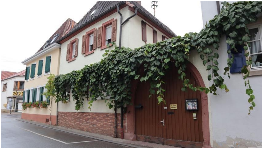
Abb. 59: Sankt-Martiner-Str. 8, Ansicht von Südosten, im Vordergrund Torfahrt mit Renaissance-Rundbogen.
