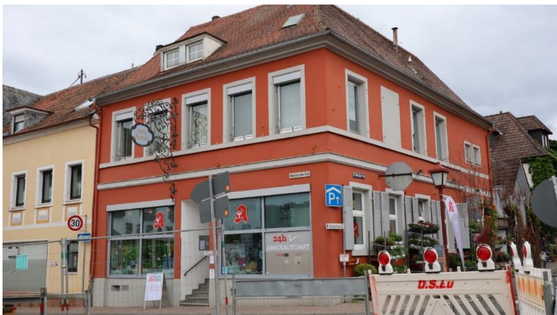
Abb. 54: Sankt-Martiner-Str. 1, Ansicht auf die Ecksituation von Nordosten vom Marktplatz aus.
