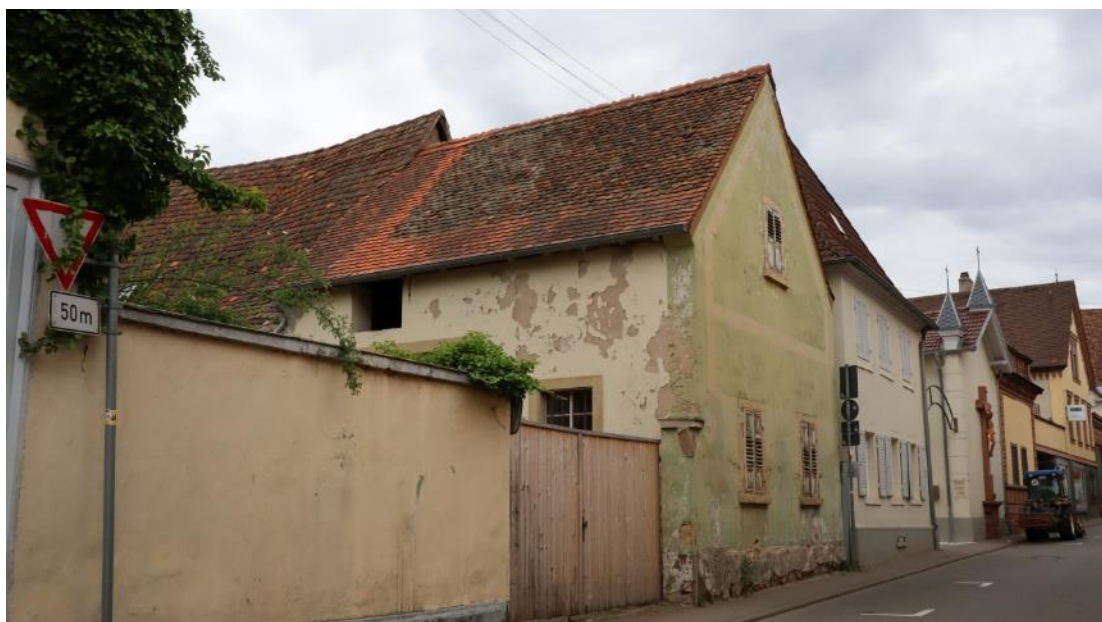
Abb. 12: Hartmannstr. 1, Ansicht von Nordosten, Nebengebäude.
