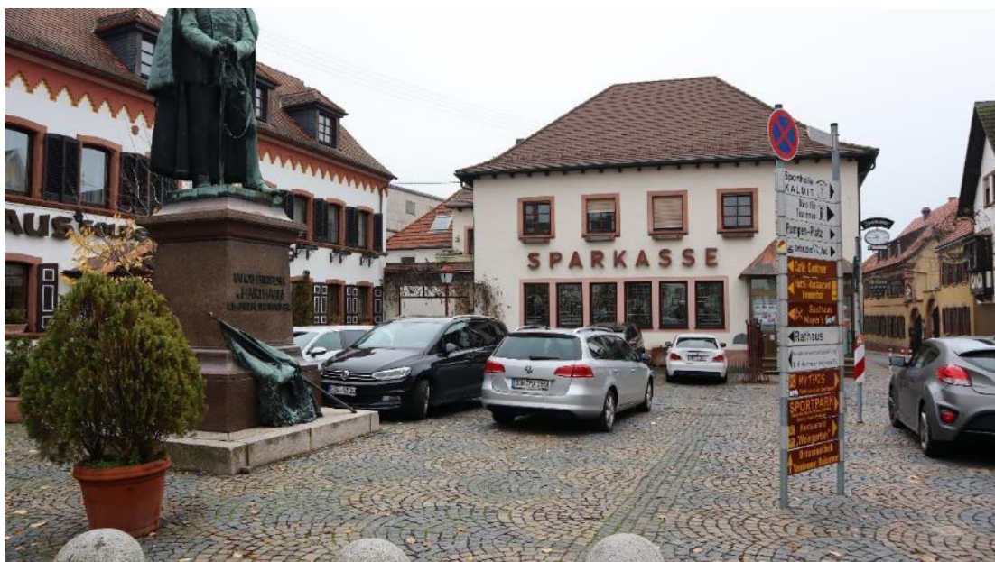
Abb. 5: Marktplatz mit Blick auf das bauzeitliche Sparkassengebäude. Links das historische Gasthaus zum goldenen Ochsen (Marktstr. 4) mit Hartmann-Denkmal.
