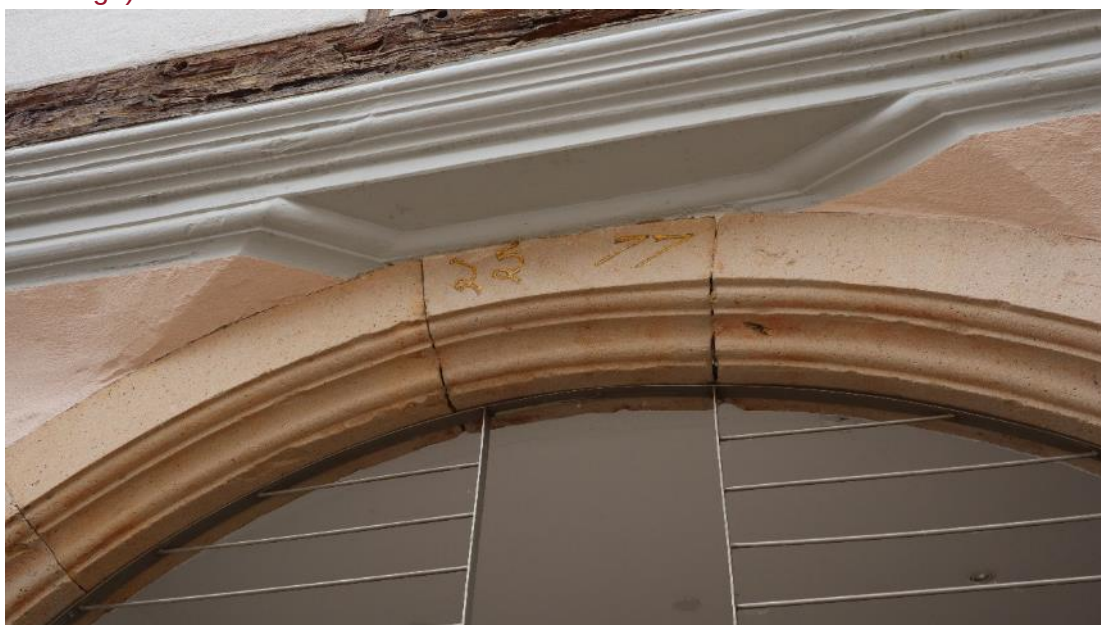
Abb. 44: An Marktstr. 6, Renaissance-Rundbogen in Torfahrt, Schlussstein mit Datierung.
