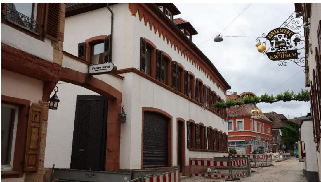
Abb. 40: Marktstr. 4, Ansicht von Westen, Blick aus der Marktstraße in Richtung Marktplatz / Sankt-Martiner-Straße. Daneben Torfahrt sowie Nr. 6. Schmiedeeiserne Hausschilder.
