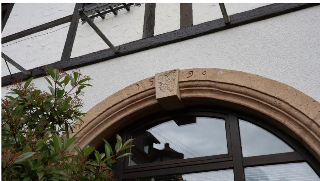
Abb. 36: An Marktstr. 1, eingebauter Rundbogen des 16. Jh. am Erdgeschoss der Westfassade, Inschrift mit nachträglich hinzugefügtem Schlussstein mit Weinrelief.
