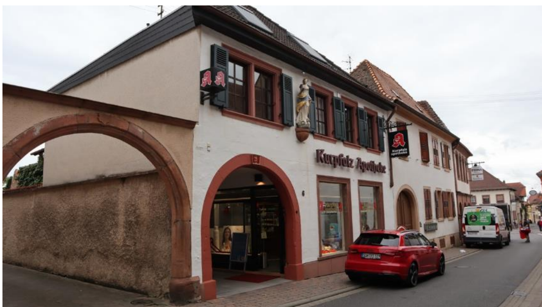
Abb. 72: Weinstraße Nord 6, Ansicht von Nordwesten, links die Torfahrt von Nr. 8.
