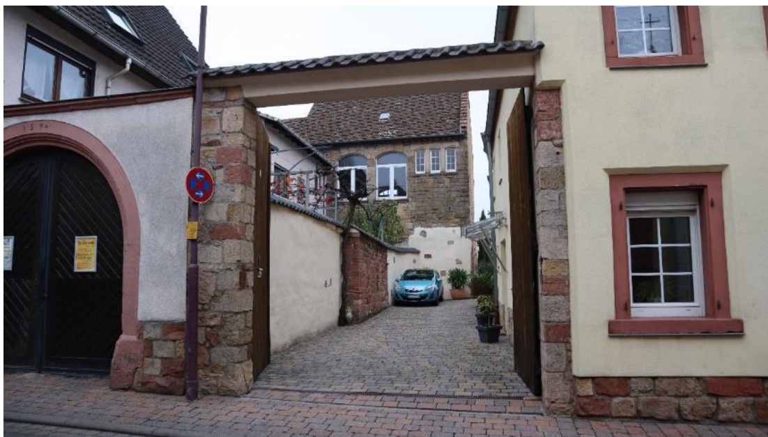
Abb. 23: Hartmannstr. 14, Tanzsaal im Hintergrund, gesehen durch die Zufahrt von Nr. 12.
