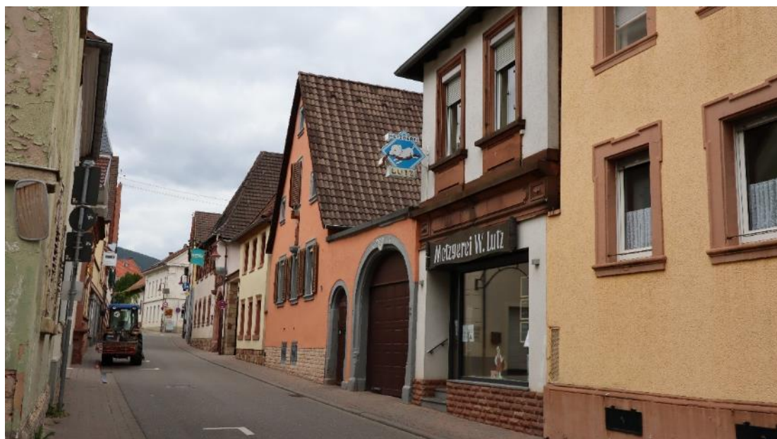
Abb. 20: Hartmannstr. 10, Ansicht von Südosten, Wohnhaus, rechts daneben Nadelöhr und Renaissance-Torbogen sowie angrenzendes Nebengebäude.
