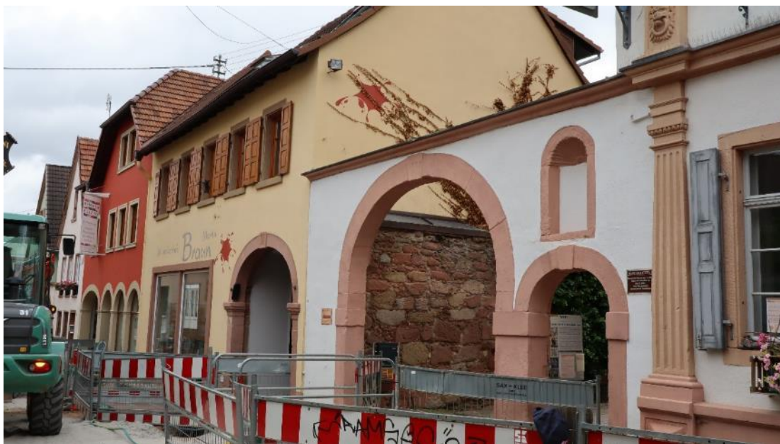
Abb. 47: Marktstr. 10, Ansicht von Nordwesten, rechts Torfahrt von Nr. 8.
