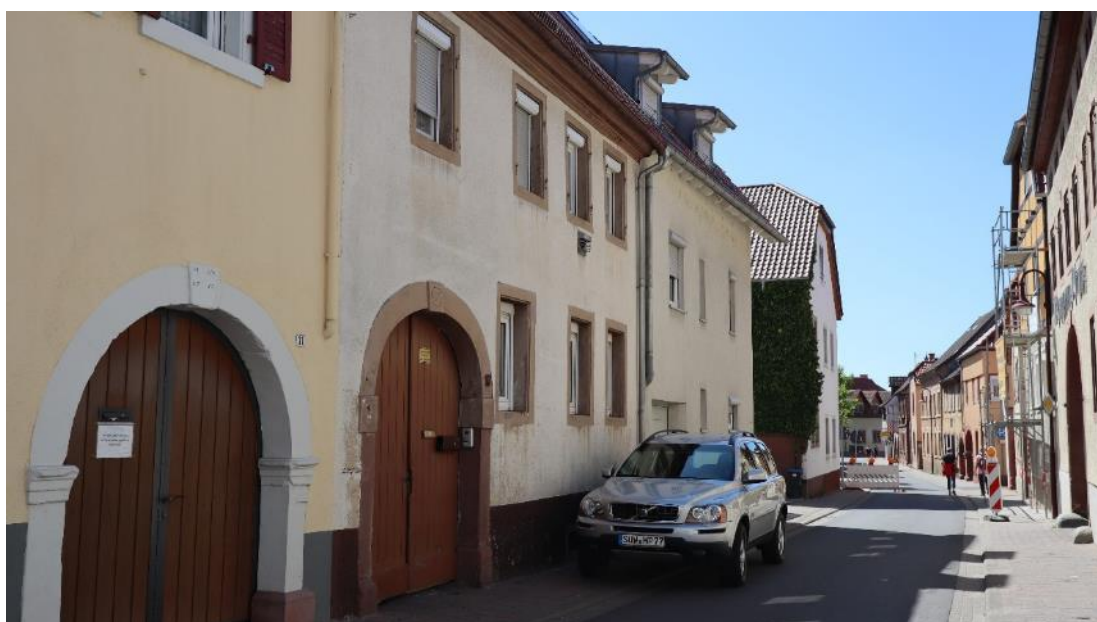
Abb. 110: Weinstraße Süd 13, Ansicht von Nordwesten, links Torfahrt von Nr. 11.
