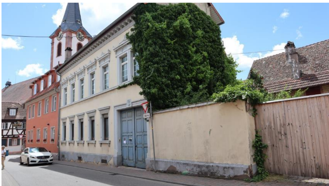
Abb. 11: Hartmannstr. 1, Ansicht von Nordwesten, Wohnhaus.
