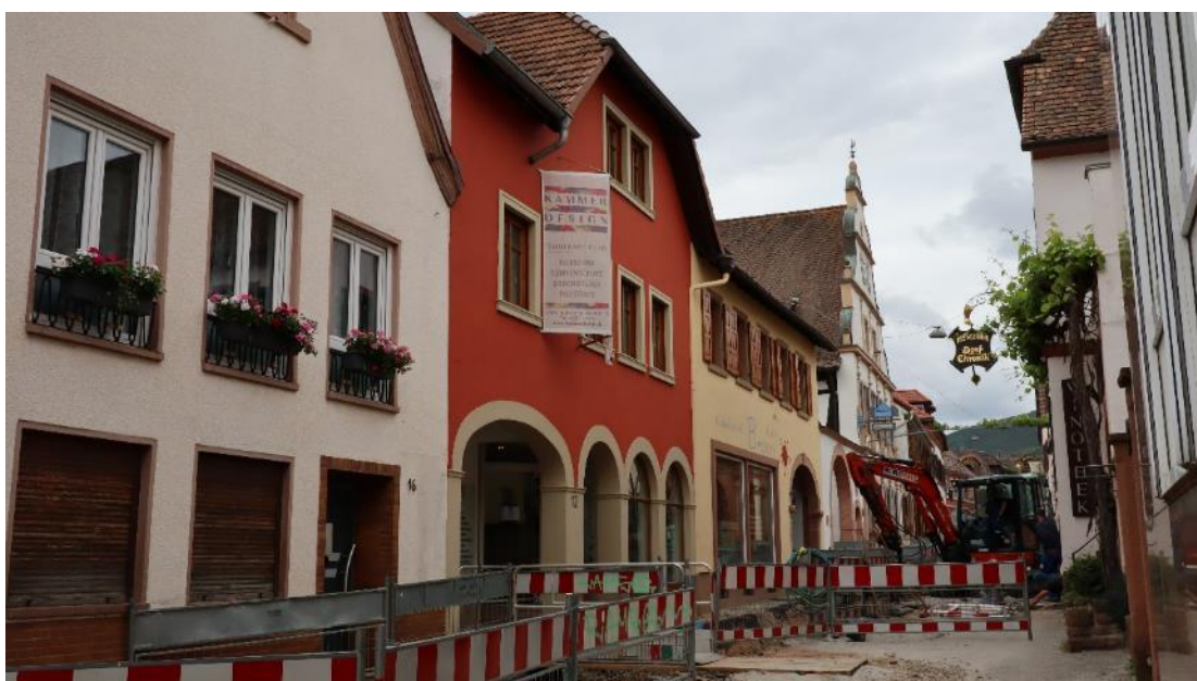
Abb. 48: Marktstr. 12, Ansicht von Nordosten mit Blick Richtung Marktplatz, links Nr. 16.
