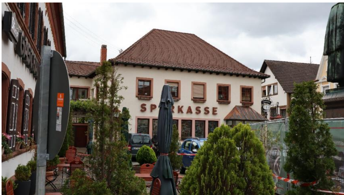
Abb. 37: Marktstr. 2, Sparkassengebäude, Ansicht von Norden, Marktplatzfassade, linker Bildrand Nr. 3.
