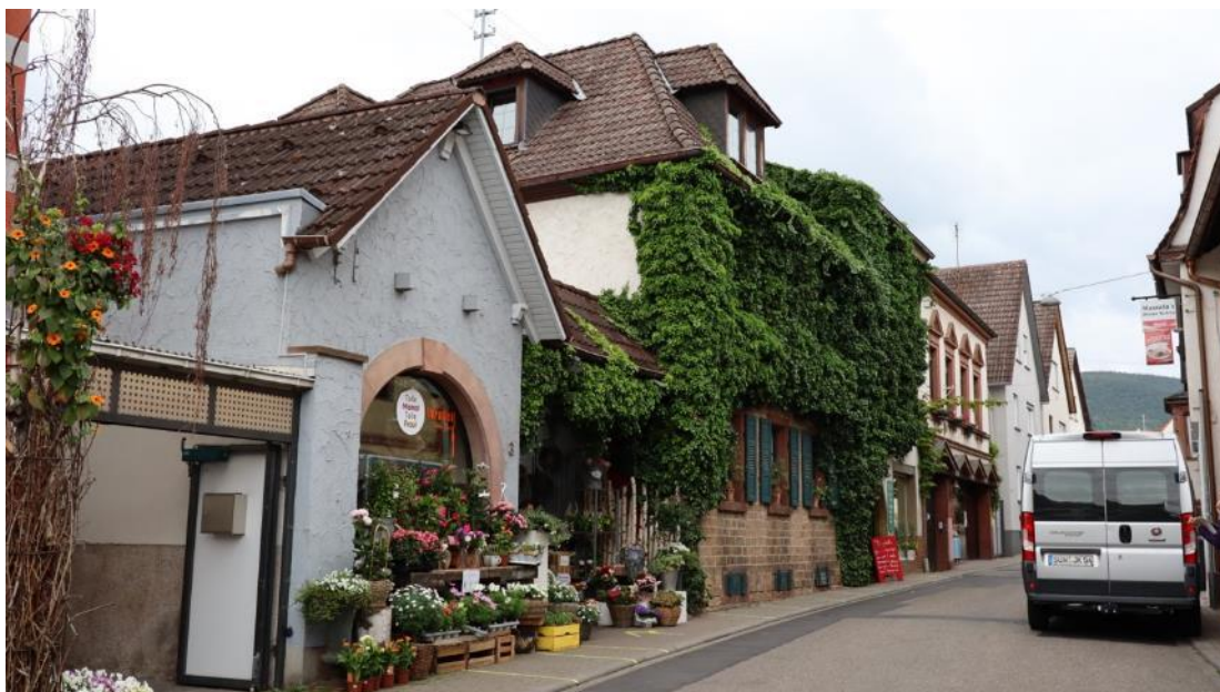
Abb. 55: Sankt-Martiner-Str. 3, Ansicht von Nordosten auf Nebengebäude und Vorderhaus.
