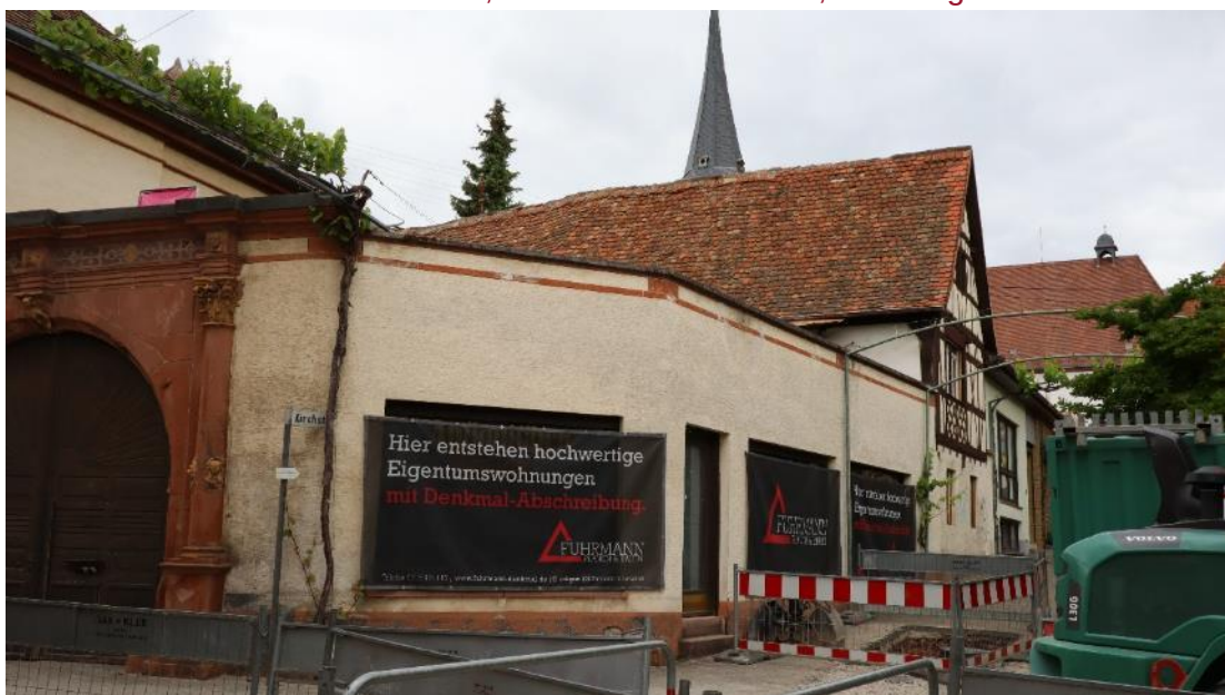
Abb. 42: Marktstr. 5, Ansicht von Südosten, historischer Mauerverlauf sowie im Hintergrund Nebengebäude mit Fachwerk des 17. Jh.
