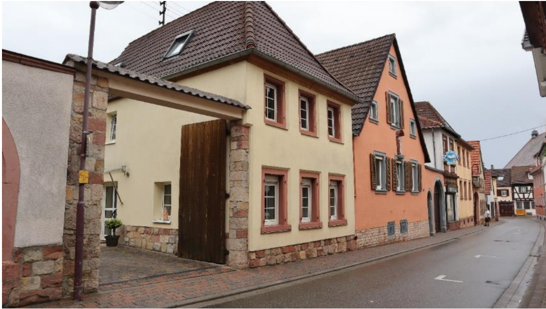
Abb. 21: Hartmannstr. 12, Ansicht von Südwesten, Wohnhaus, links daneben überdachte Einfahrt.
