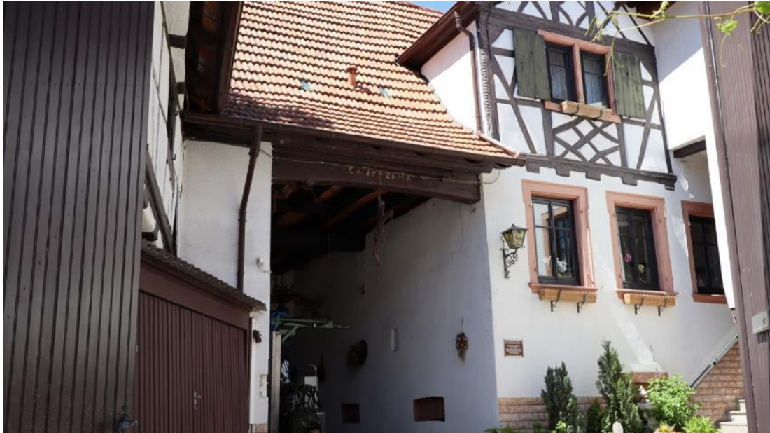
Abb. 87: Weinstraße Nord 27, Ansicht von Südosten, Blick durch Torfahrt auf Wohnhaus und angrenzendes Nebengebäude.
