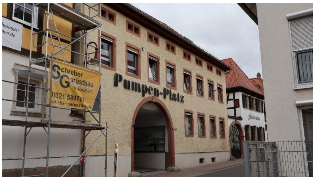
Abb. 112: Weinstraße Süd 16, Ansicht von Südosten, links im Bild Nr. 18.
