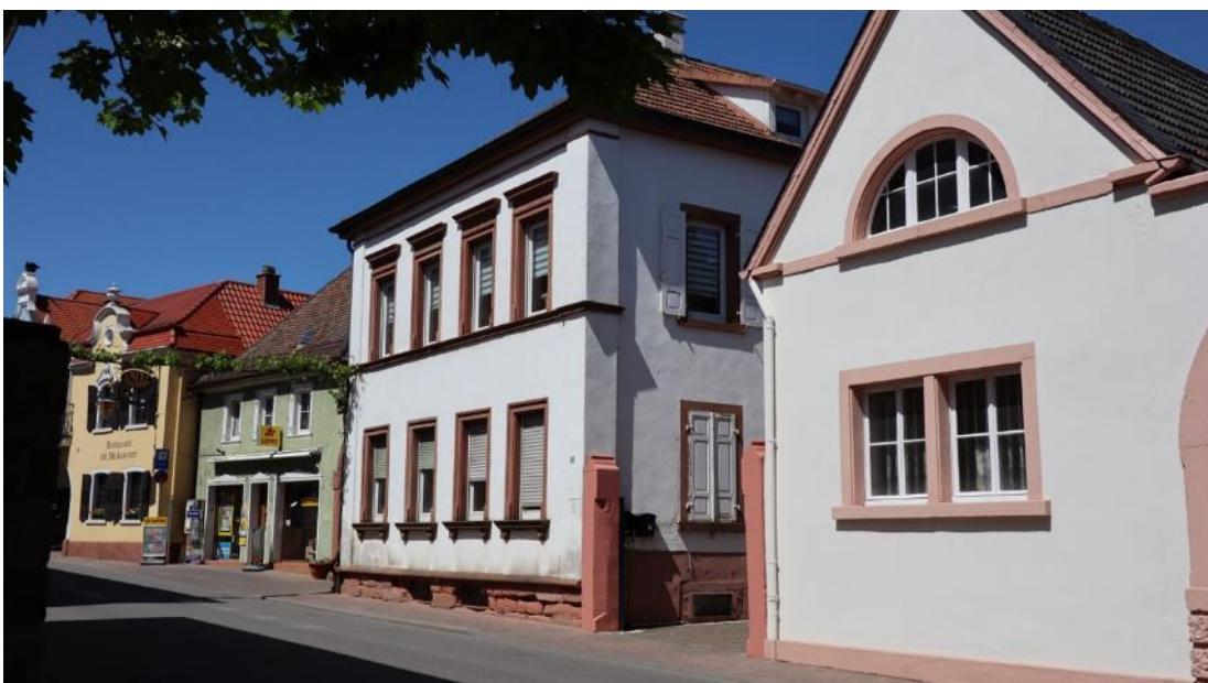
Abb. 94: Weinstraße Nord 39, Ansicht von Südwesten, rechts Nebengebäude Nr. 41 (außerhalb der Denkmalzone).
