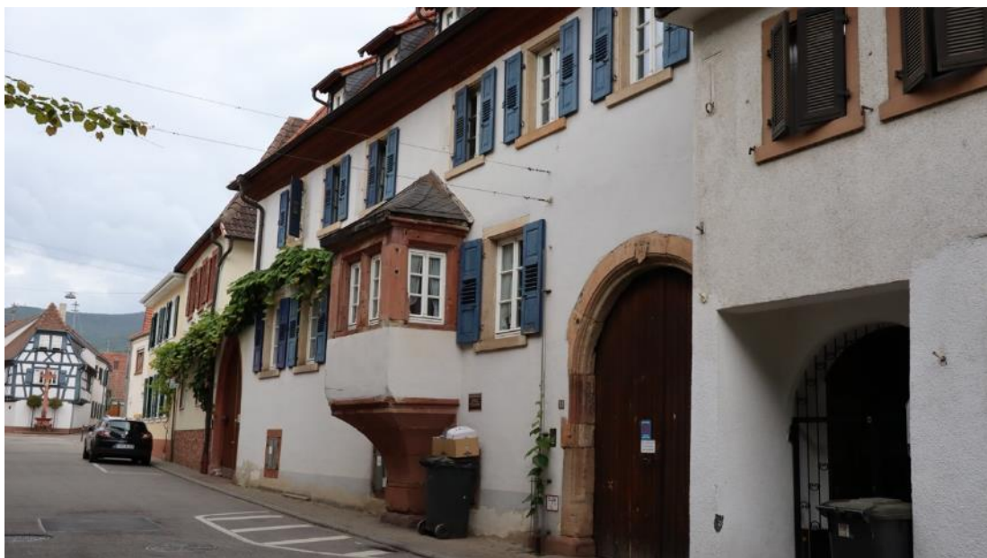
Abb. 57: Sankt-Martiner-Str. 6, Ansicht von Südosten, Blick auf Torfahrt und Erker.
