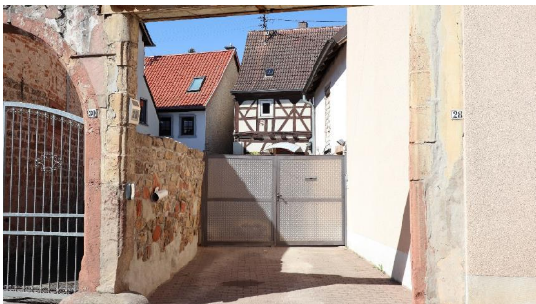
Abb. 118: Weinstraße Süd 28 & 30, Blick von Osten auf rückwärtige Bebauung (Fachwerk-Gebäude Nr. 28, links angrenzend Nr. 30), links daneben Torfahrt Nr. 30.
