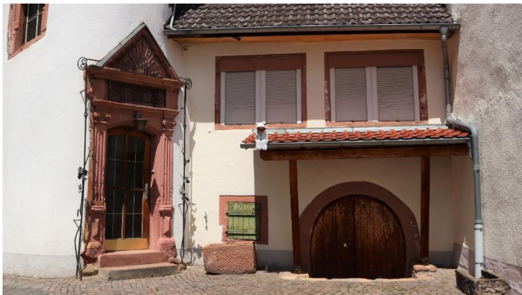
Abb. 103: An Turmstraße 9, Renaissance-Portal und rundbogiger Kellereingang.
