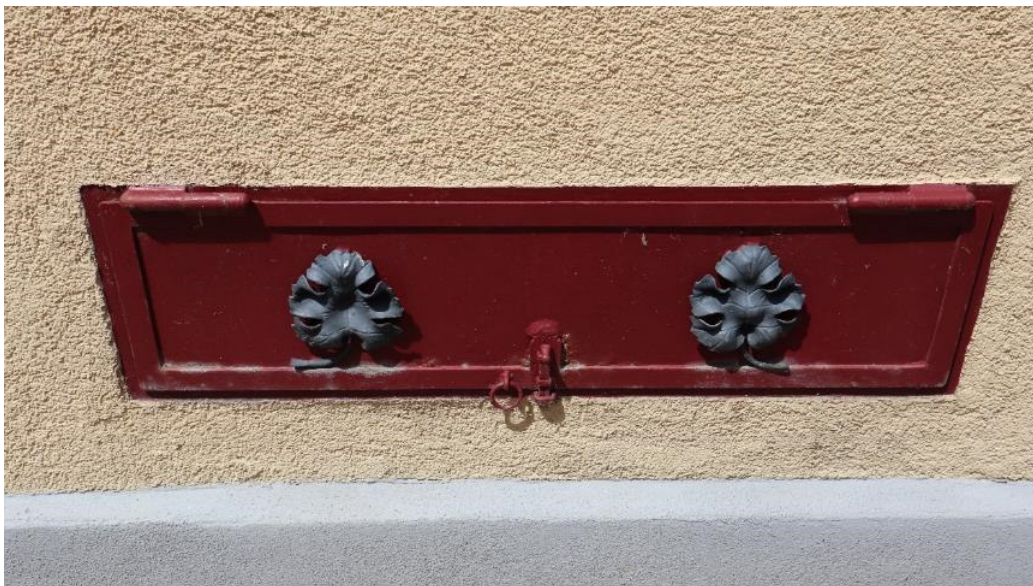
Abb. 40: Alsterweiler Hauptstraße 30, Detailansicht einer Metallklappe am Keller.
