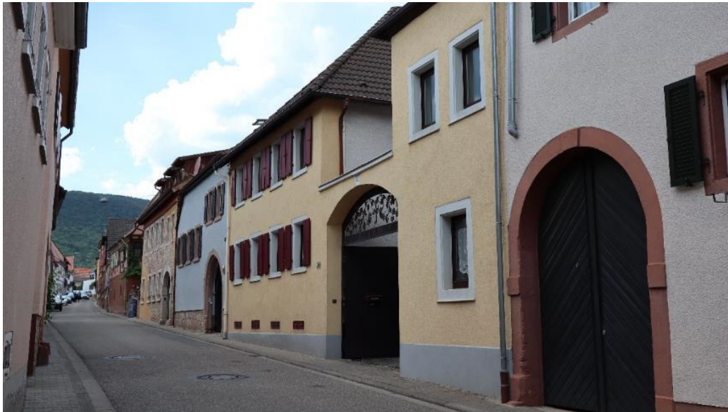
Abb. 39: Alsterweiler Hauptstraße 30, Ansicht von Südosten.
