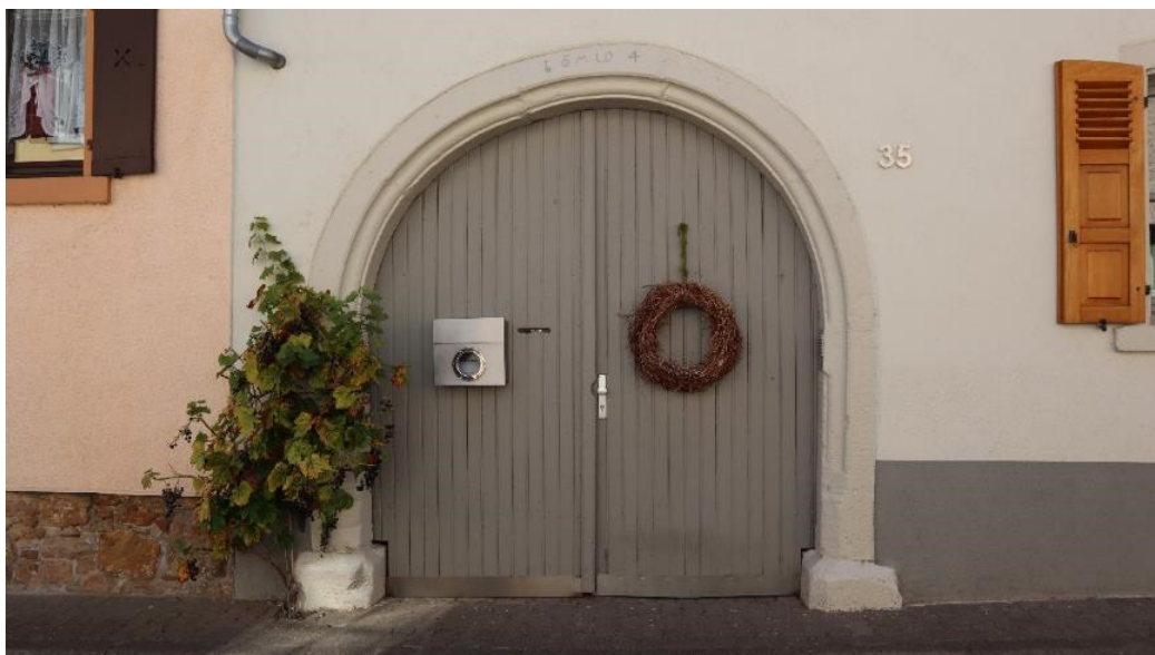
Abb. 48: An Alsterweiler Hauptstraße 35, Renaissance-Torbogen.
