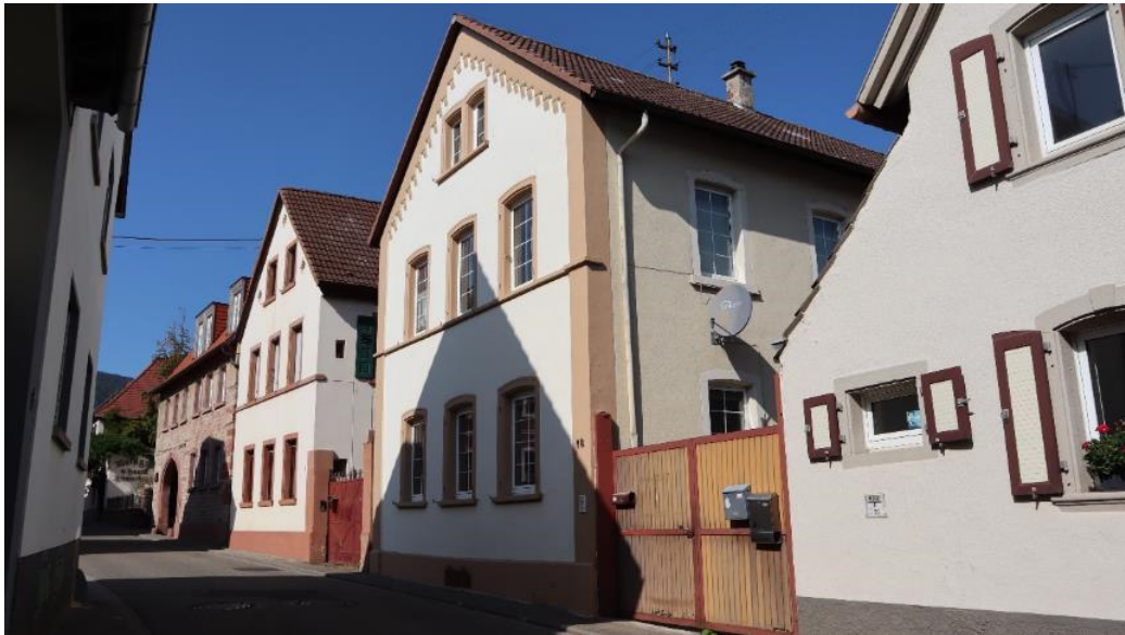
Abb. 25: Alsterweiler Hauptstraße 18, Ansicht von Südosten.
