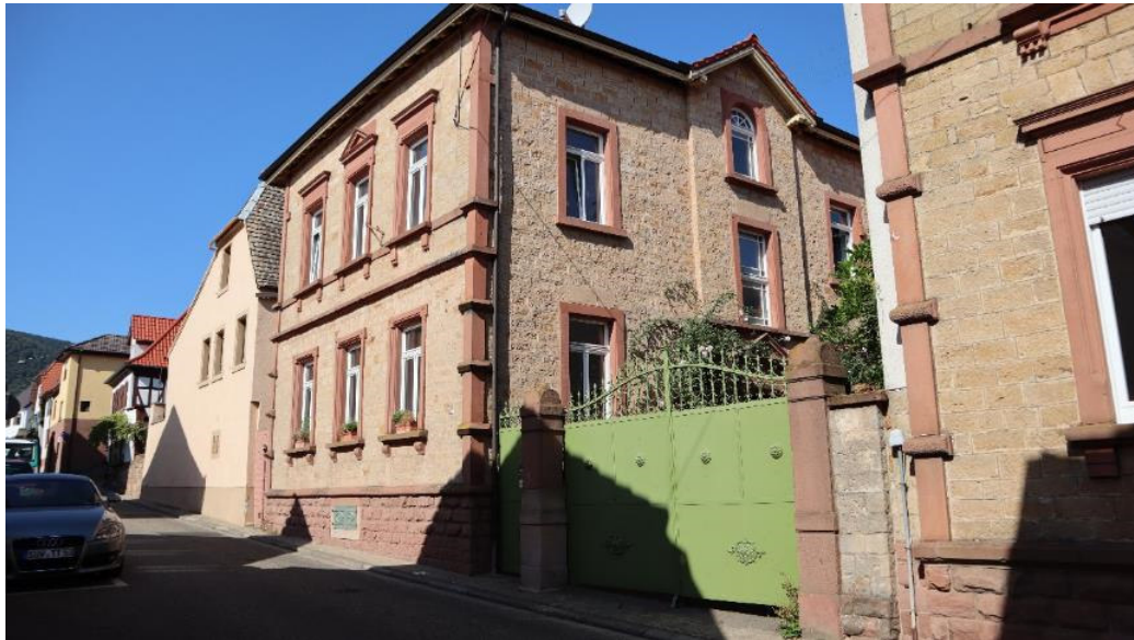
Abb. 57: Alsterweiler Hauptstraße 44, Ansicht von Südosten.
