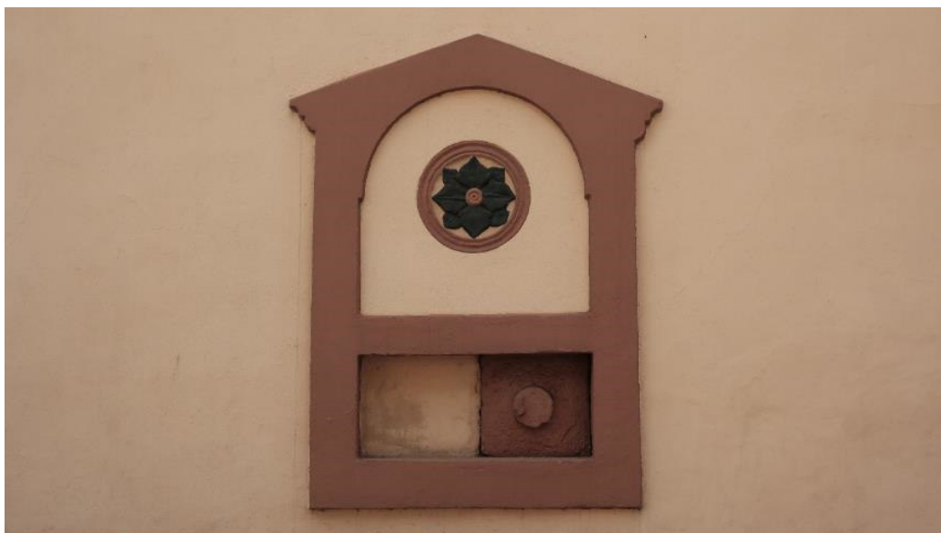
Abb. 34: Alsterweiler Hauptstraße 25, Detailansicht eines Steinriegels an der Fassade.
