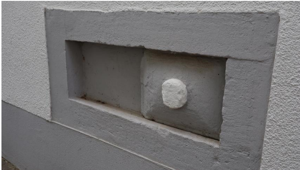
Abb. 63: Alsterweiler Hauptstraße 51, Detailansicht eines Steinriegels an der Fassade.
