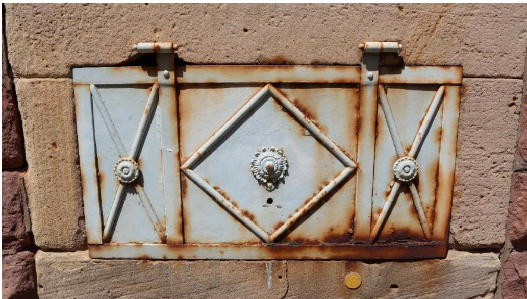
Abb. 52: Alsterweiler Hauptstraße 40, Detailansicht einer Metallklappe am Keller.
