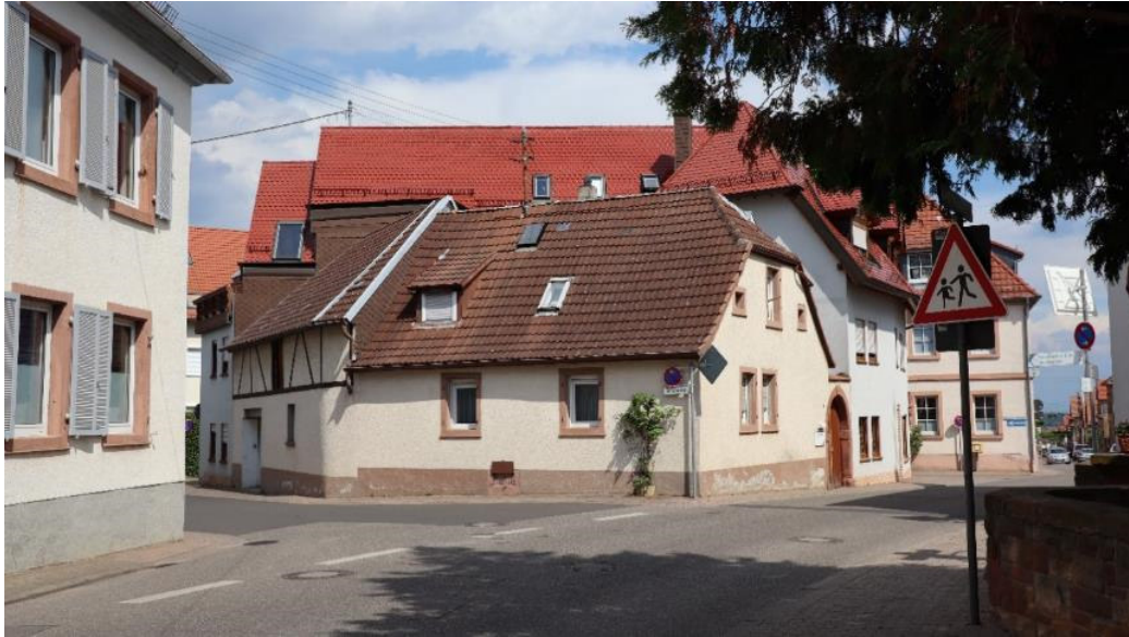
Abb. 7: Alsterweiler Hauptstraße 4, Ansicht von Westen.
