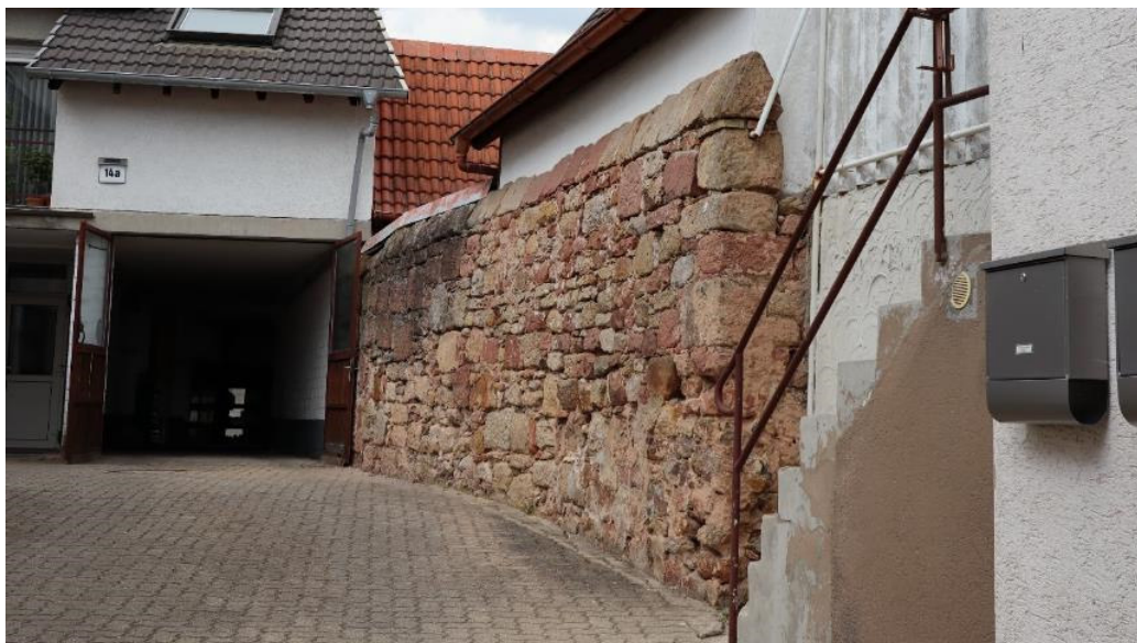
Abb. 20: Alsterweiler Hauptstraße 14, Hofmauer.
