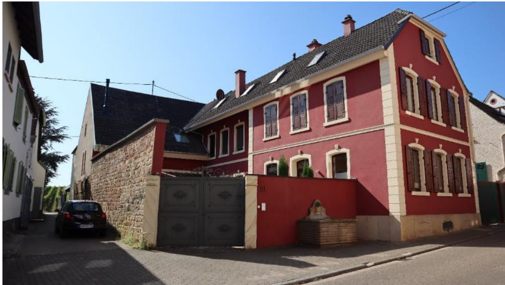
Abb. 27: Alsterweiler Hauptstraße 21, Ansicht von Nordosten.
