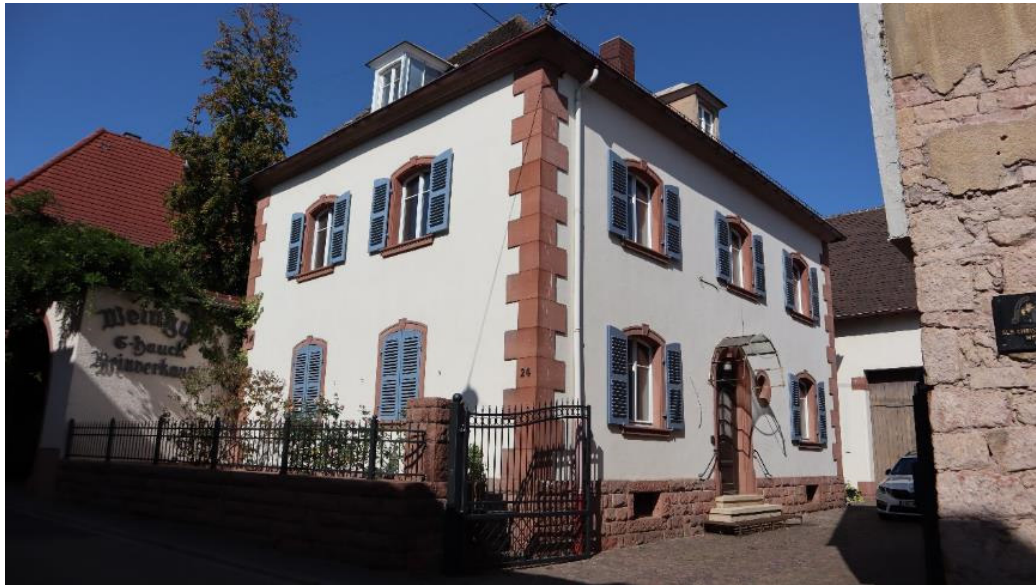
Abb. 31: Alsterweiler Hauptstraße 24, Ansicht von Südosten.
