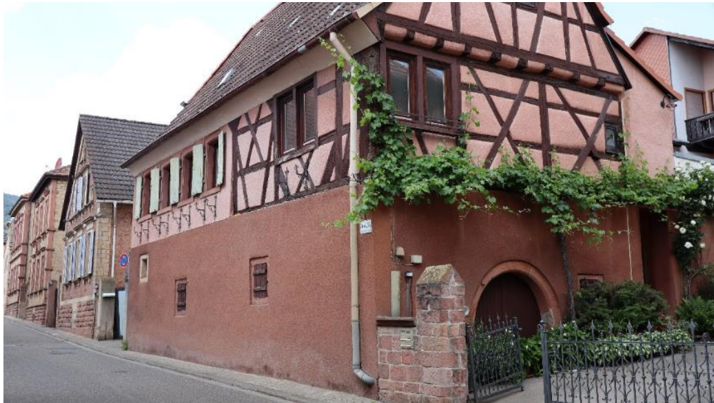
Abb. 49: Alsterweiler Hauptstraße 38, Ansicht von Südosten.
