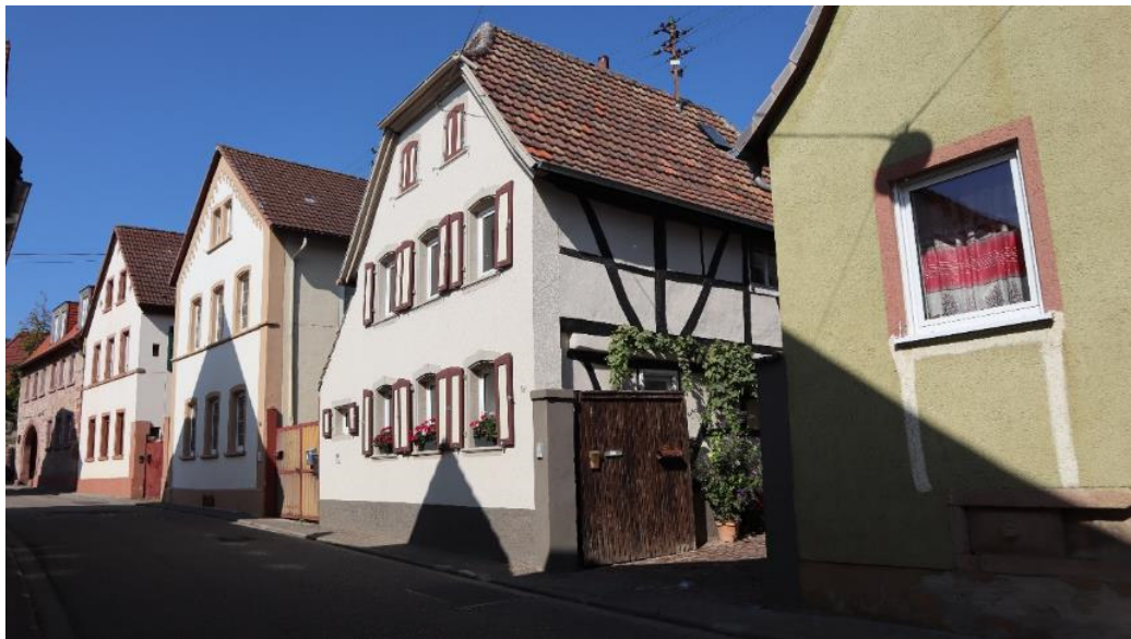
Abb. 22: Alsterweiler Hauptstraße 16, Ansicht von Südosten.
