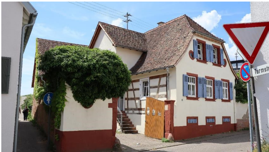
Abb. 72: Alsterweiler Hauptstraße 63, Ansicht von Nordosten.
