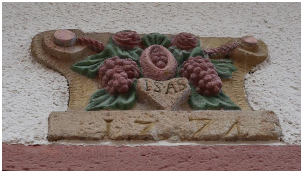
Abb. 36: An Alsterweiler Hauptstraße 28, Spolie eines Ofensteins.
