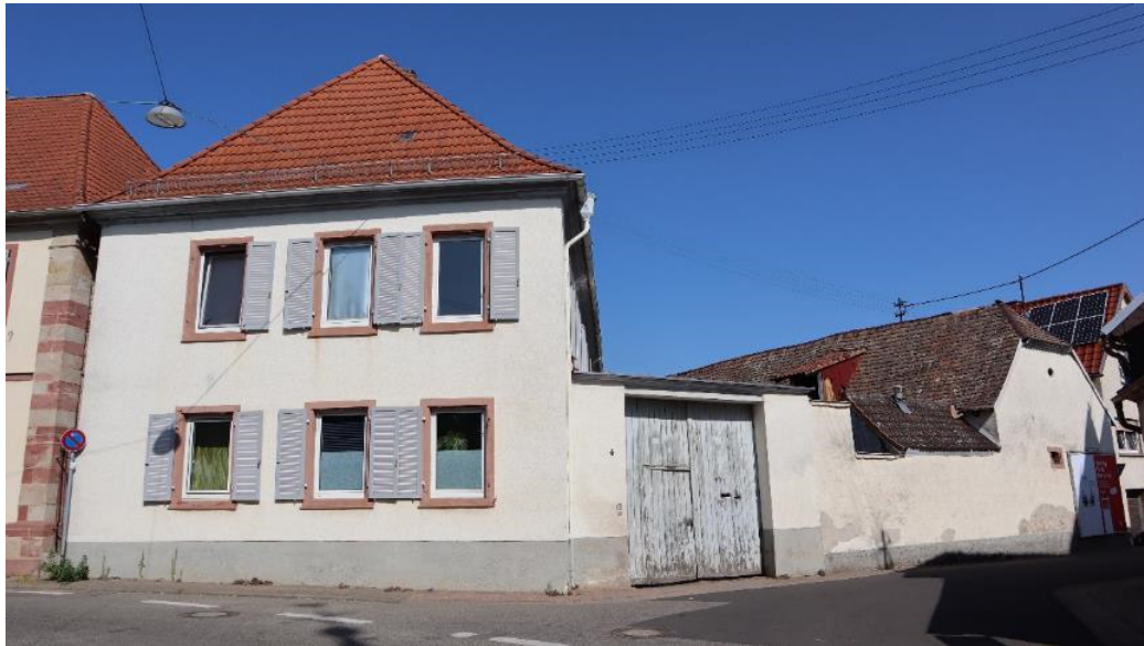
Abb. 9: Alsterweiler Hauptstraße 6, Ansicht von Süden.
