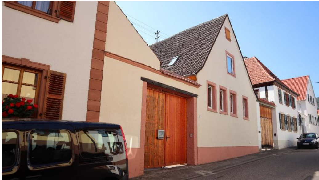
Abb. 67: Alsterweiler Hauptstraße 57, Ansicht von Nordosten.
