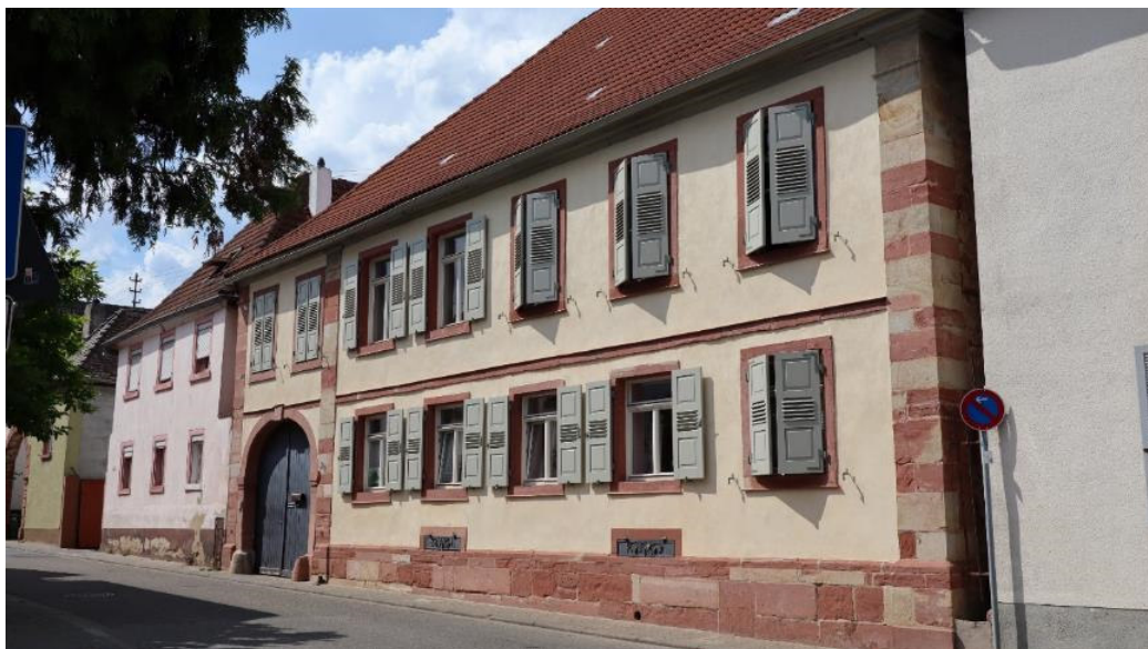
Abb. 10: Alsterweiler Hauptstraße 8, Ansicht von Südosten.
