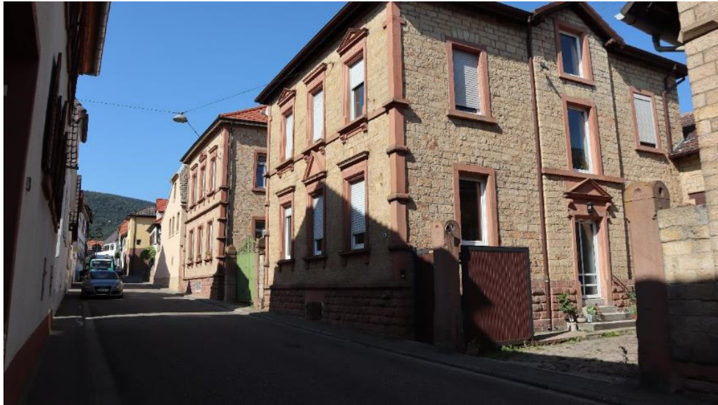
Abb. 55: Alsterweiler Hauptstraße 42, Ansicht von Südosten.
