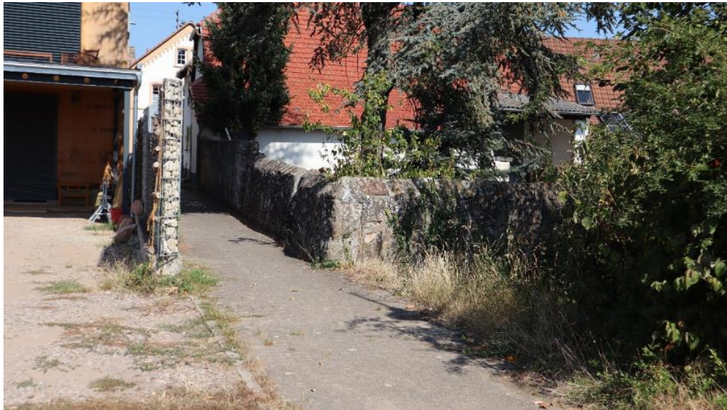
Abb. 78: Südlich Alsterweiler Hauptstraße 19, Umfassungsmauer des Hausgartens.
