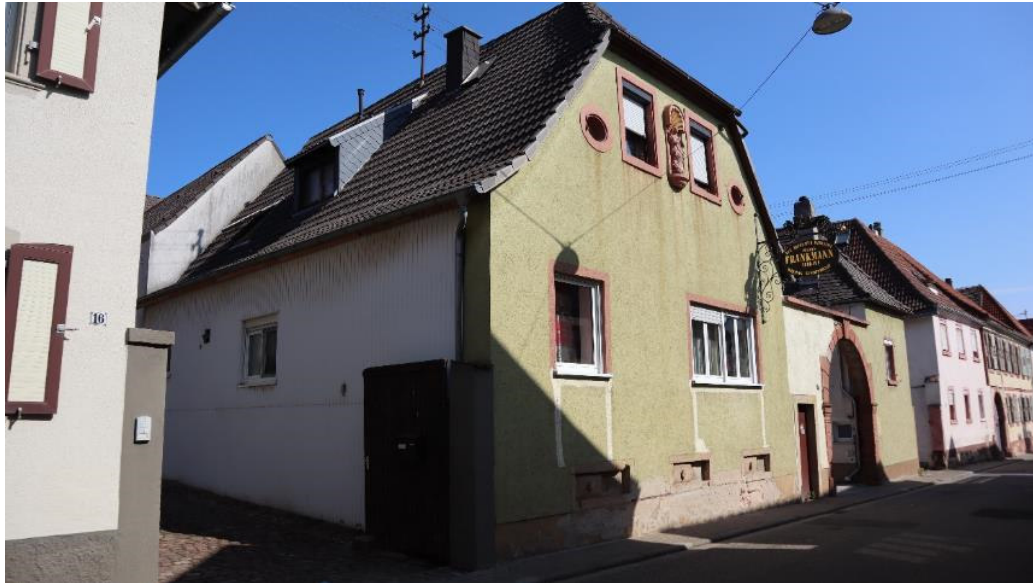
Abb. 17: Alsterweiler Hauptstraße 14, Ansicht von Südenwesten.
