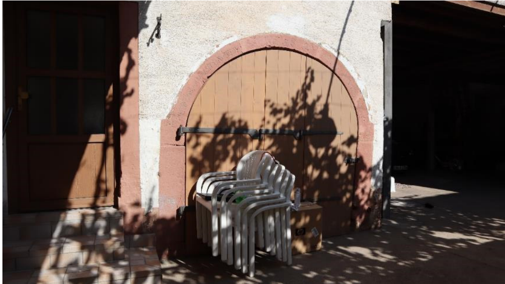
Abb. 100: An Turmstraße 4, Kellerbogen des 16. Jh.
