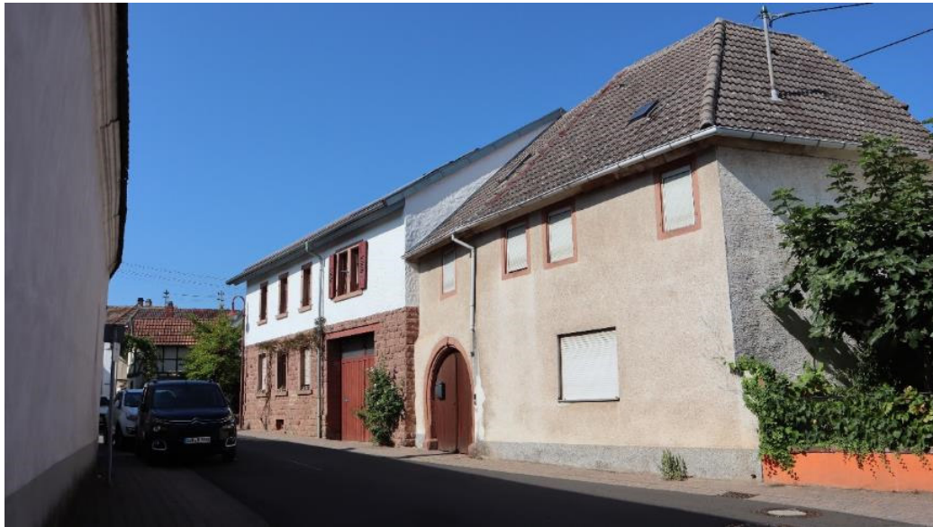
Abb. 88: Friedhofstraße 110 und 112, Ansicht von Südosten.
