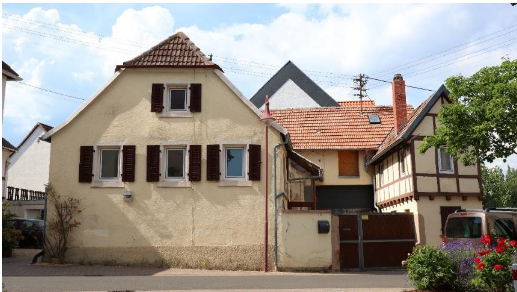
Abb. 91: Friedhofstraße 118, Ansicht von Süden.
