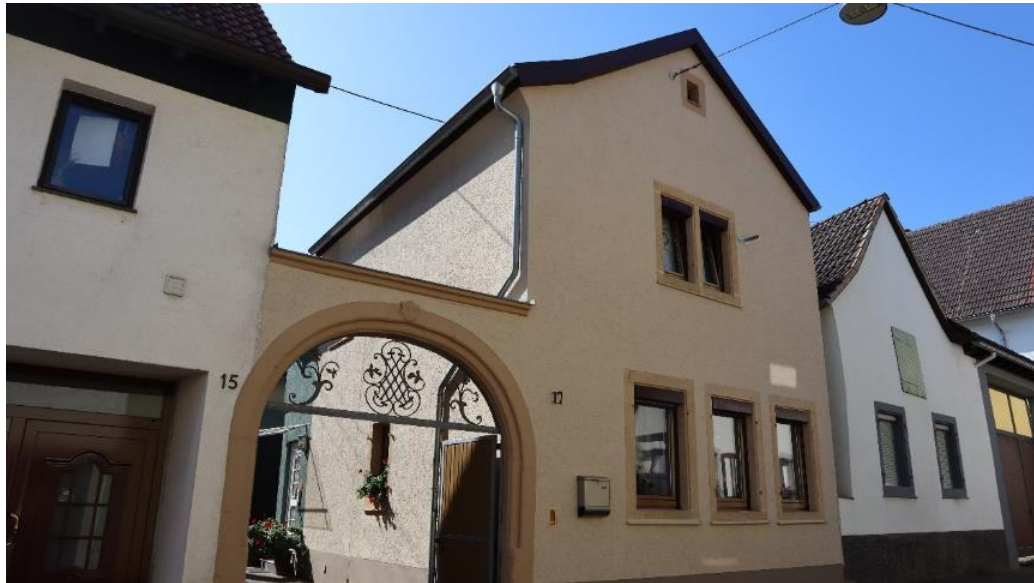
Abb. 23: Alsterweiler Hauptstraße 17, Ansicht von Nordosten.
