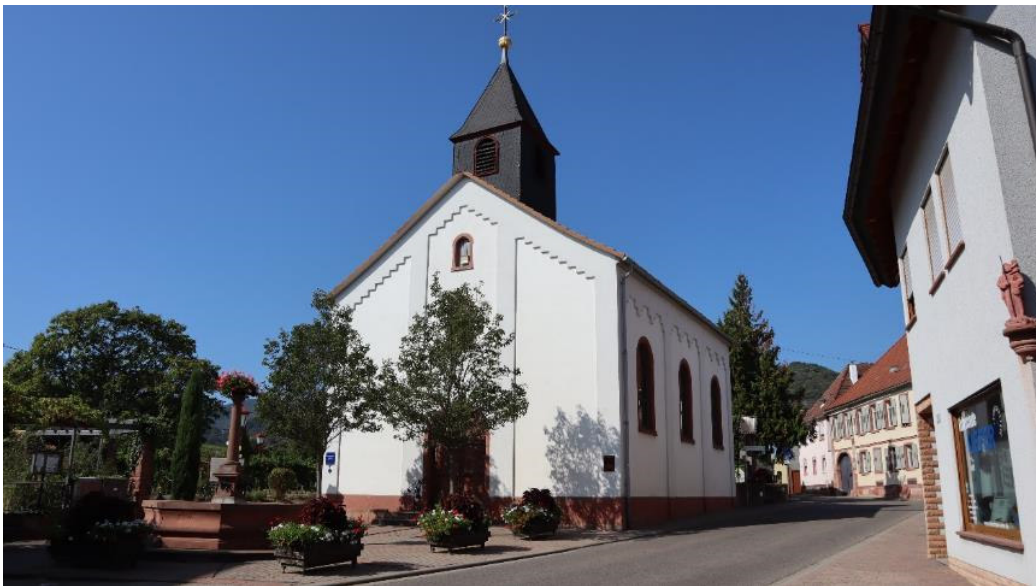
Abb. 8: Alsterweiler Hauptstraße 5, Kapelle mit Vorplatz. Ansicht von Südosten.
