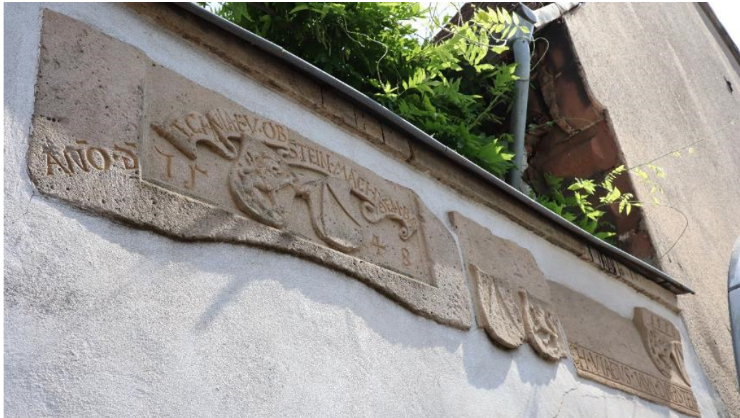
Abb. 84: Friedhofstraße 101, Spolien in der Hofmauer.
