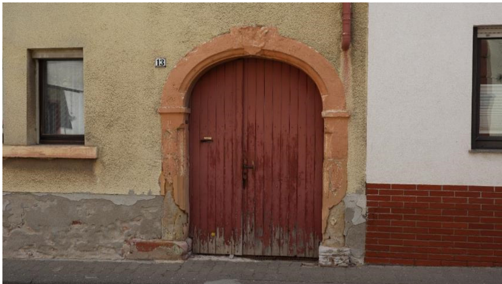
Abb. 16: Alsterweiler Hauptstraße 13, barocker Torbogen (vor der Sanierung).
