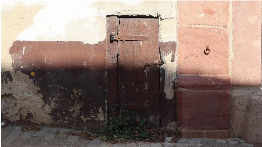
Abb. 13: Alsterweiler Hauptstraße 10, Detailansicht des hölzernen Zugang zum Reil.
