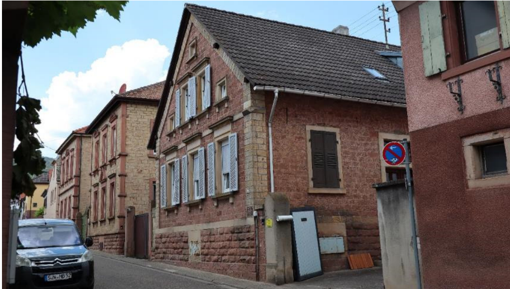
Abb. 51: Alsterweiler Hauptstraße 40, Ansicht von Südosten.
