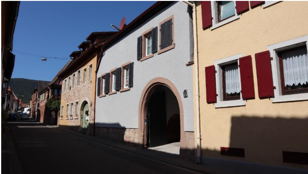
Abb. 43: Alsterweiler Hauptstraße 32, Ansicht von Südosten.
