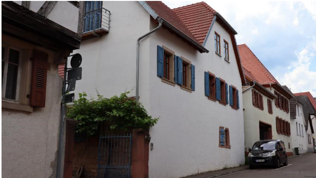
Abb. 53: Alsterweiler Hauptstraße 41, Ansicht von Nordosten.
