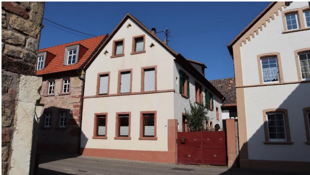
Abb. 26: Alsterweiler Hauptstraße 20, Ansicht von Südosten.
