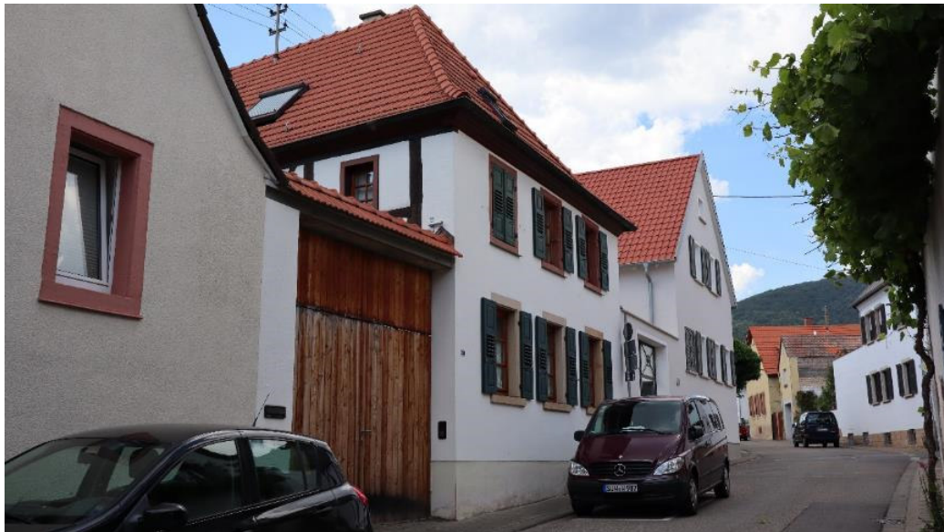
Abb. 70: Alsterweiler Hauptstraße 59, Ansicht von Nordosten.
