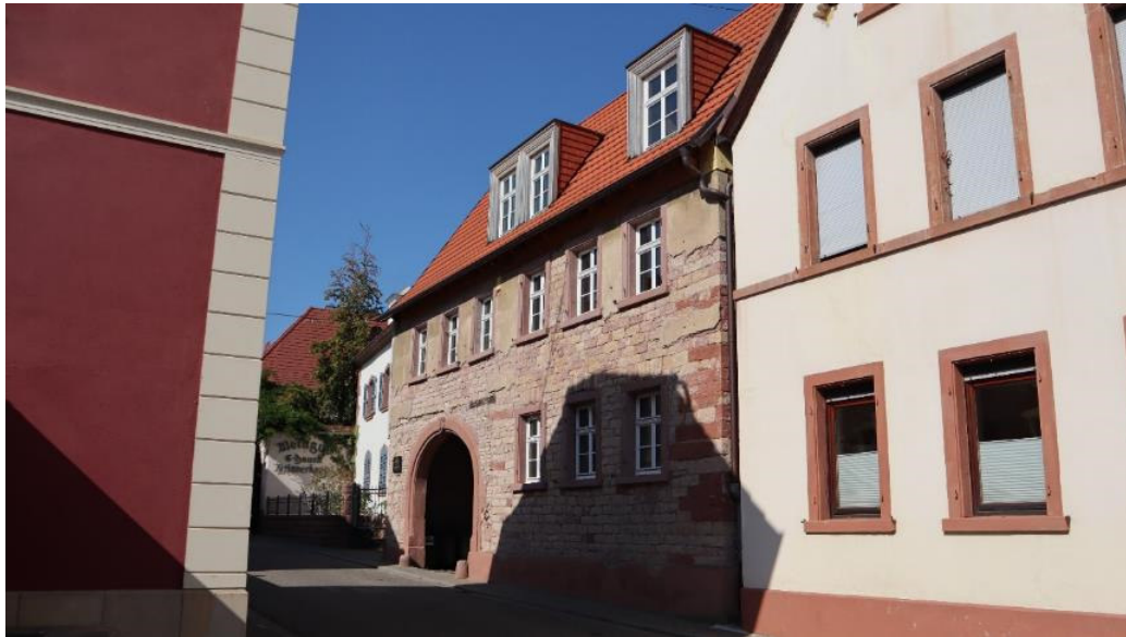
Abb. 29: Alsterweiler Hauptstraße 22, Ansicht von Südosten.
