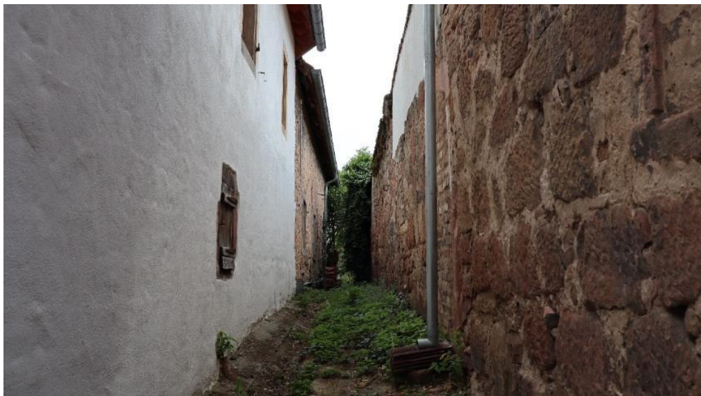
Abb. 54: Zwischen Alsterweiler Hauptstraße 41 und 43, Stichweg in Richtung Süden.
