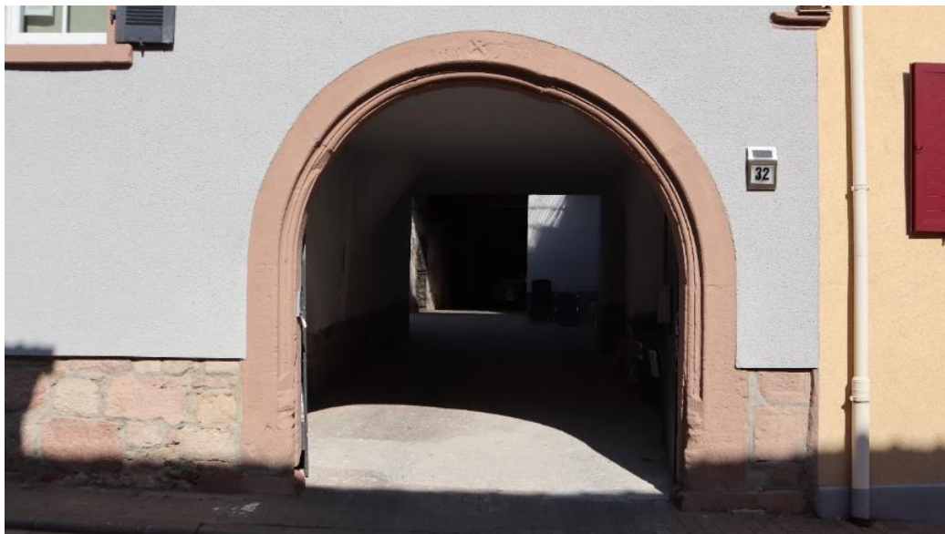
Abb. 44: An Alsterweiler Hauptstraße 32, Renaissance-Torbogen.
