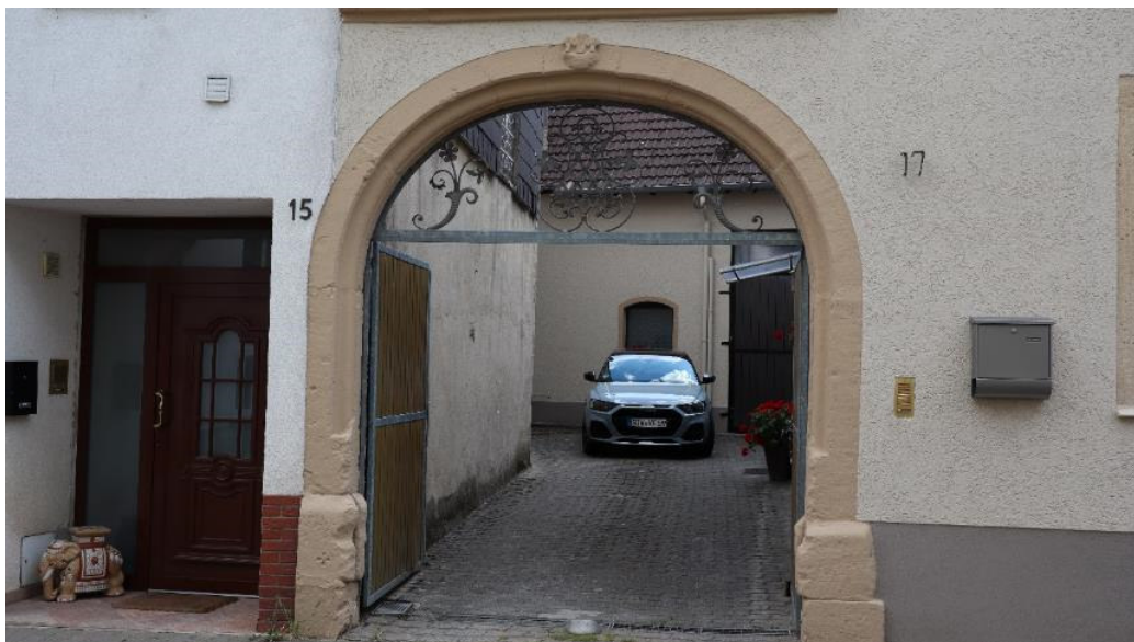
Abb. 24: Alsterweiler Hauptstraße 17, Detailansicht des Renaissance-Torbogens.
