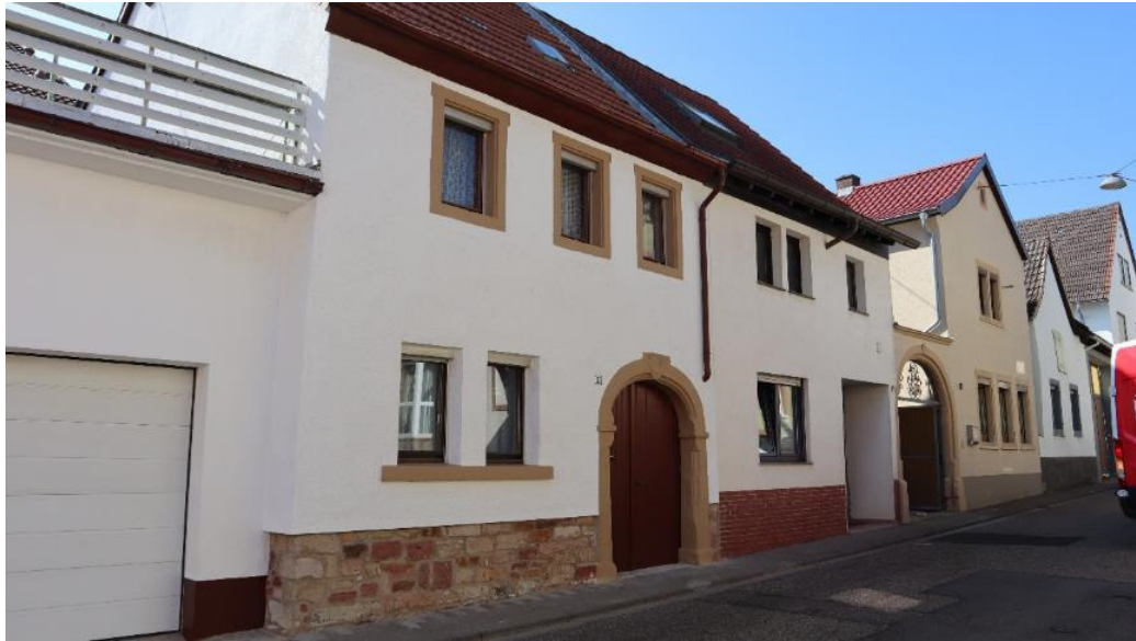
Abb. 15: Alsterweiler Hauptstraße 13, Ansicht von Nordosten.
