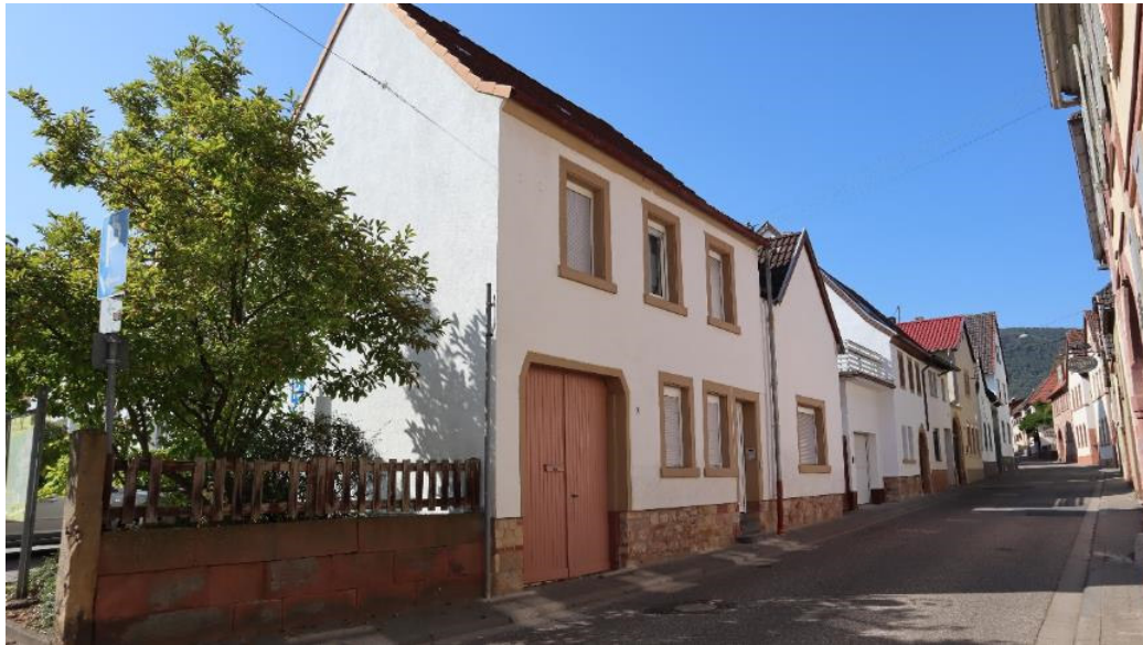
Abb. 11: Alsterweiler Hauptstraße 9, Ansicht von Nordosten.
