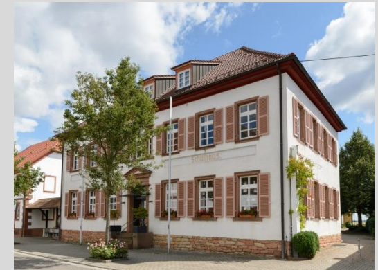
Ehem. Schule, Ansicht von Westen.
