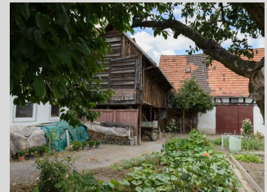
Hofgarten mit Wirtschaftsgebäuden, Ansicht vom Kapellenweg.
