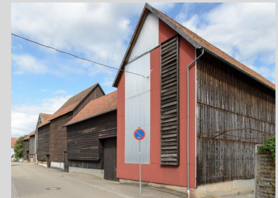
Tabakschuppen, Ansicht von der Friedhofstraße.
