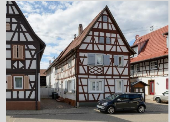
Wohnhaus, Ansicht von Osten.
