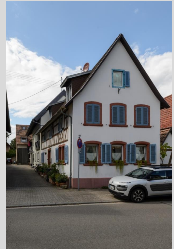
Ansicht von Osten.
