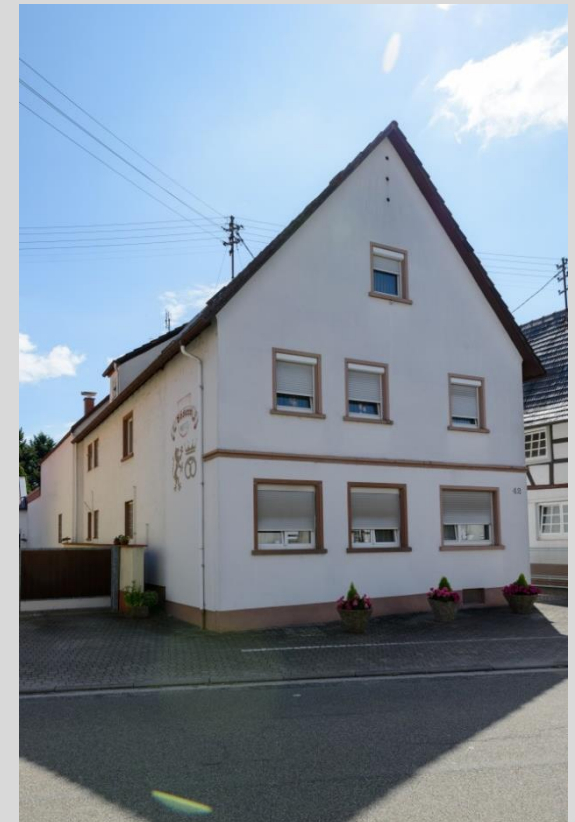
Wohnhaus, Ansicht von Osten.
