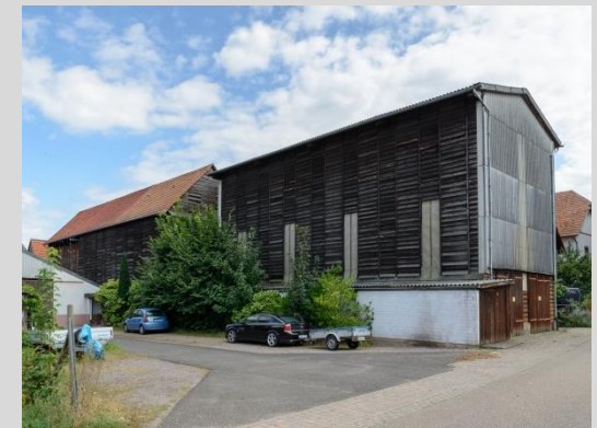
Tabakschuppen, Ansicht von der Friedhofstraße.
