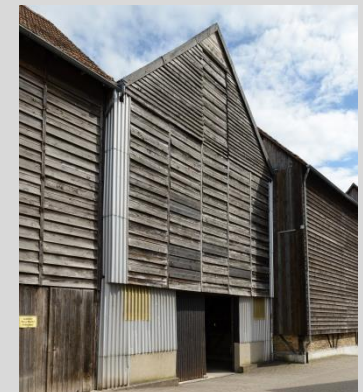
Tabakschuppen, Ansicht von der Friedhofstraße.
