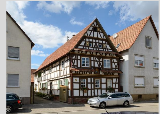
Wohnhaus, Ansicht von Osten.
