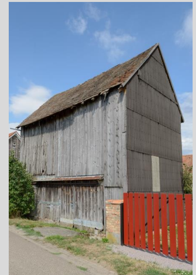
Tabakschuppen, Ansicht von der Friedhofstraße.
