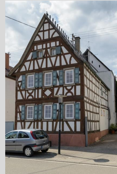
Wohnhaus, Ansicht von Osten.
