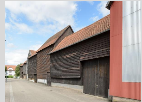
Tabakschuppen, Ansicht von der Friedhofstraße.
