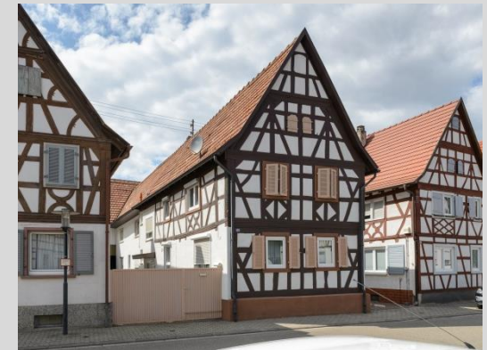
Wohnhaus, Ansicht von Osten.
