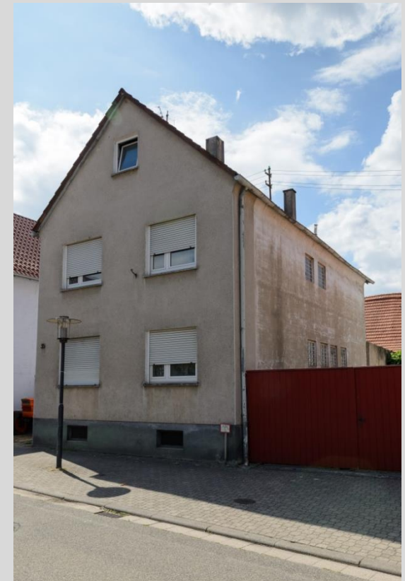
Wohnhaus, Ansicht von Osten.
