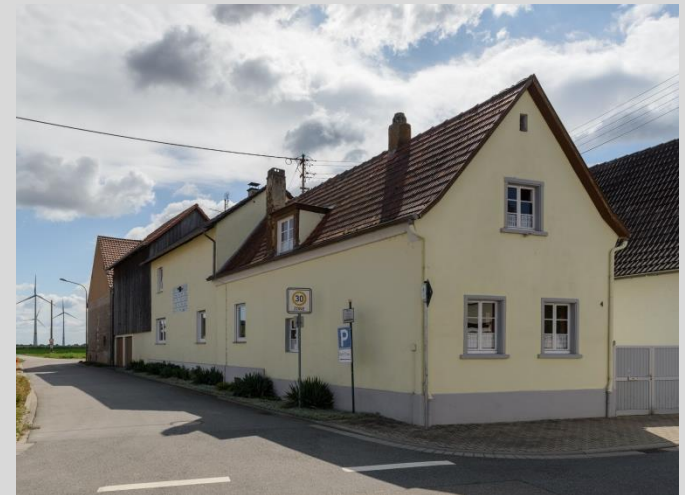
Wohnhaus mit Wirtschafts- u. Nebengebäuden, Ansicht von Nordwesten.
