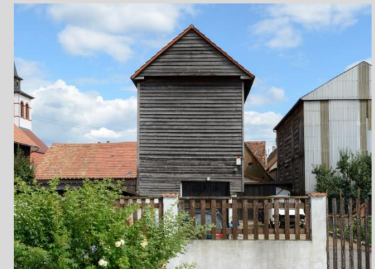
Tabakschuppen, Ansicht von der Friedhofstraße.
