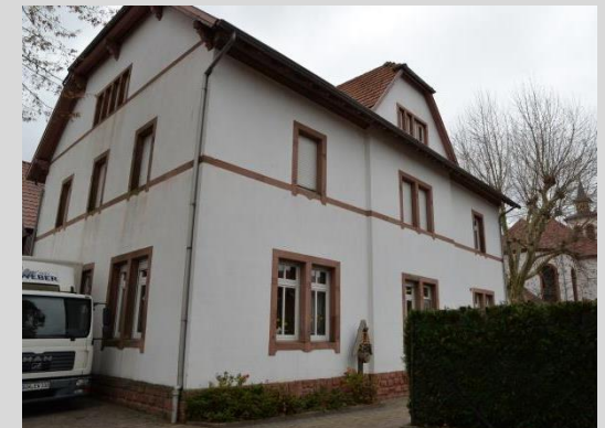
Ansicht von der Friedhofstraße.
