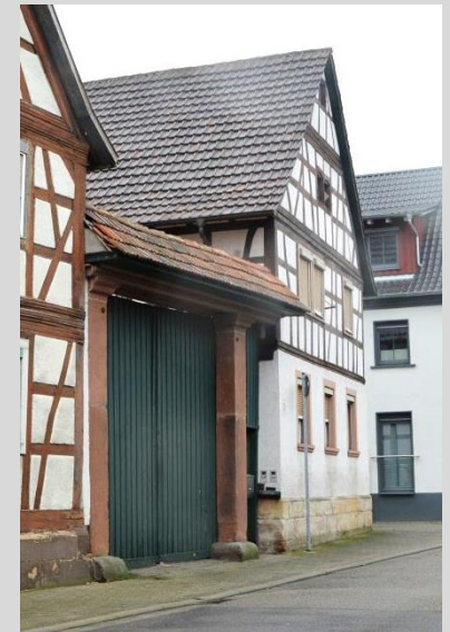
Toranlage, Ansicht von Nordosten.
