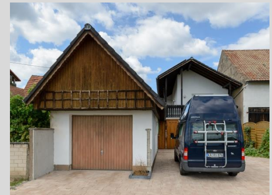
Garage, Ansicht von Osten.
