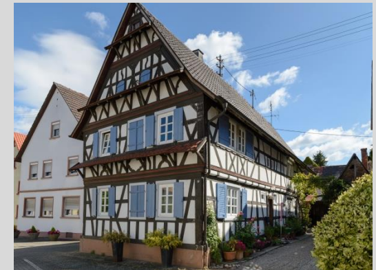
Wohnhaus, Ansicht von Südwesten.
