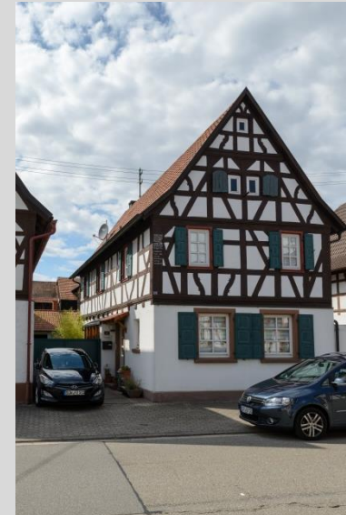
Wohnhaus, Ansicht von Osten.
