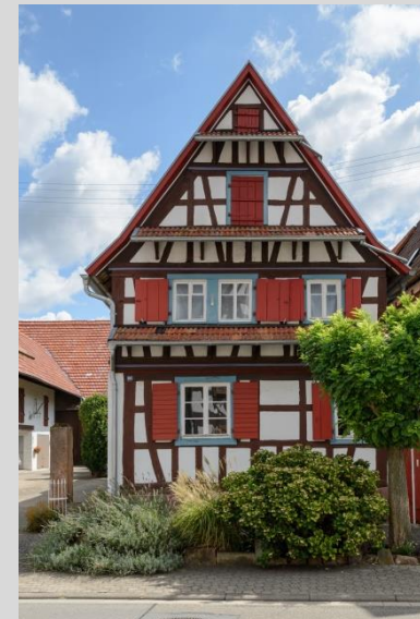
Wohnhaus, Ansicht von Osten.
