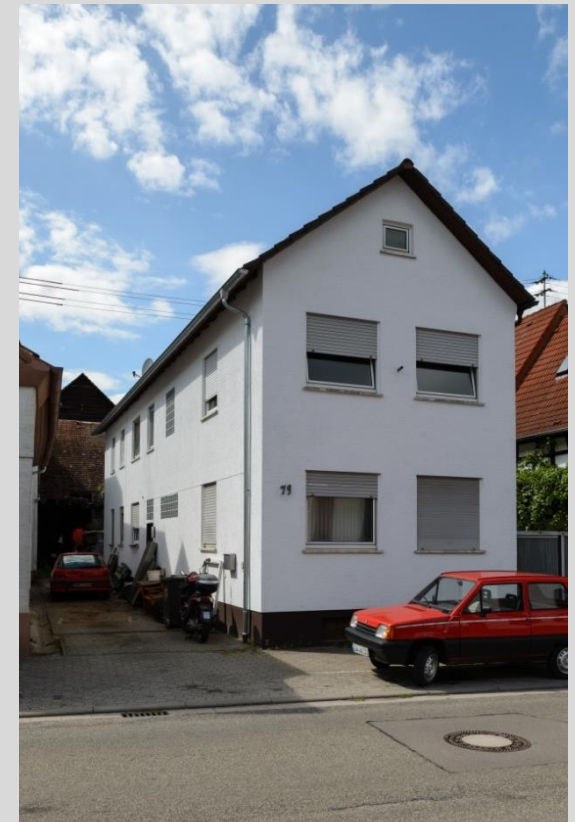
Wohnhaus, Ansicht von Osten.
