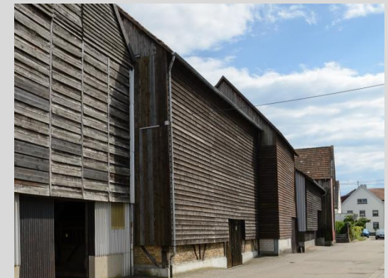
Tabakschuppen, Ansicht von der Friedhofstraße.
