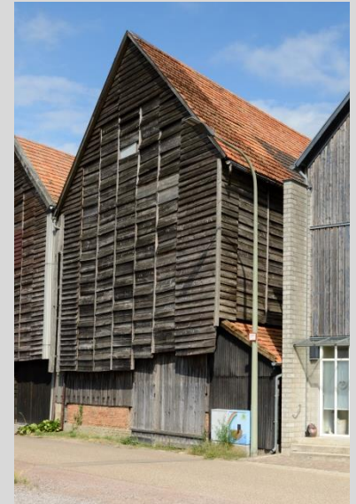
Tabakschuppen, Ansicht von der Friedhofstraße.
