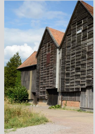
Mittlerer Tabakschuppen, Ansicht von der Friedhofstraße.
