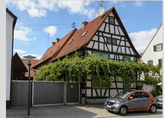
Wohnhaus, Ansicht von Osten.
