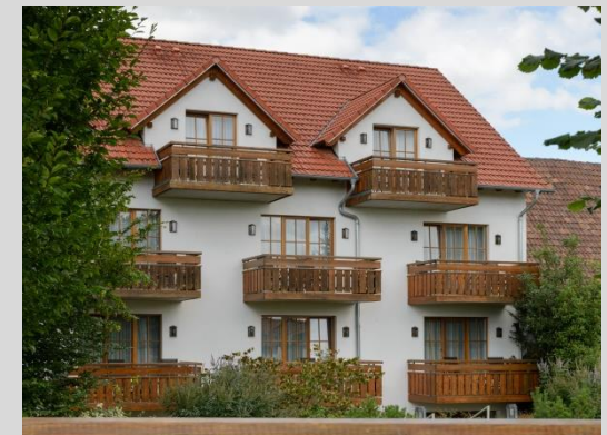
Hotelanbau, Ansicht vom Kapellenweg.
