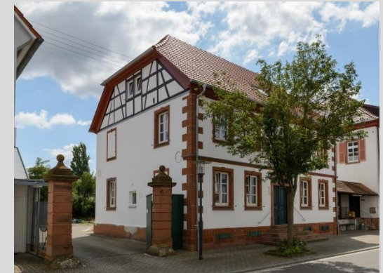
Ansicht von Nordwesten, mit Toreinfriedung.
