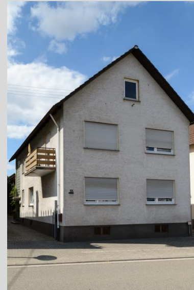
Wohnhaus, Ansicht von Osten.
