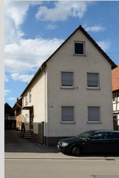
Wohnhaus, Ansicht von Osten.
