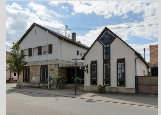
Raiffeisenbank, Ansicht von Osten.
