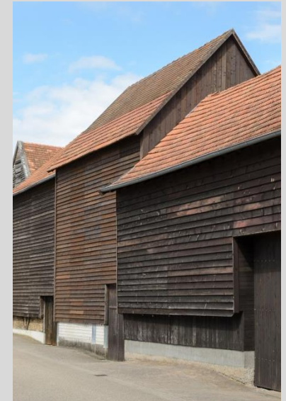
Tabakschuppen, Ansicht von der Friedhofstraße.
