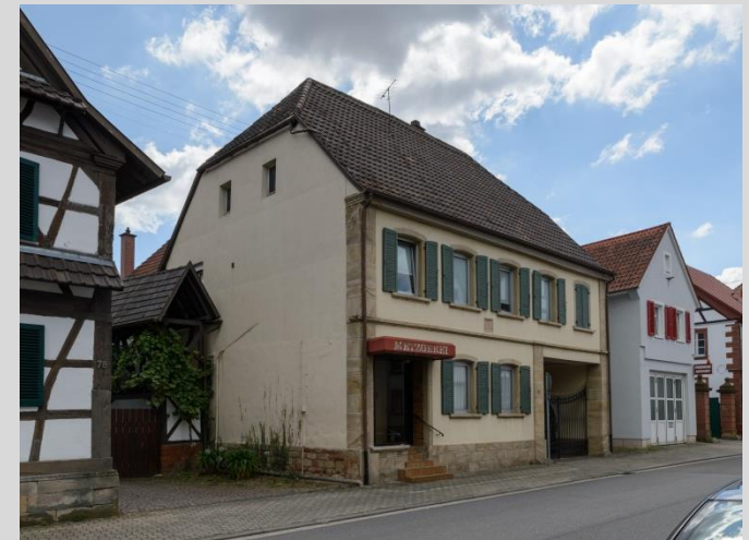
Ansicht von Westen.
