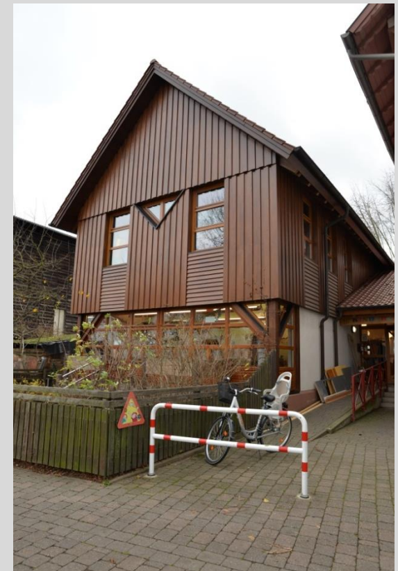
Ansicht von Westen.
