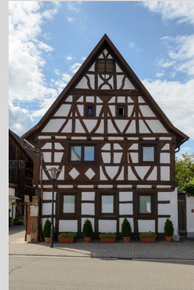
Wohnhaus Nr. 99, Ansicht von Osten.
