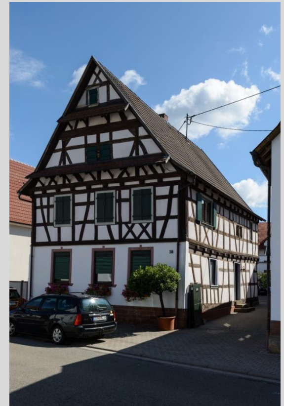
Wohnhaus, Ansicht von Südwesten.
