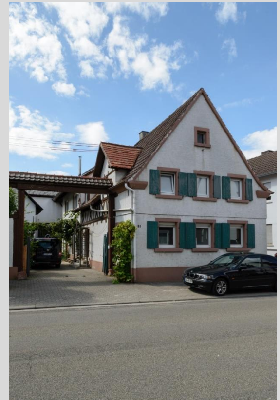
Wohnhaus, Ansicht von Osten.
