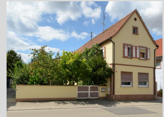
Wohnhaus, Ansicht von Osten.
