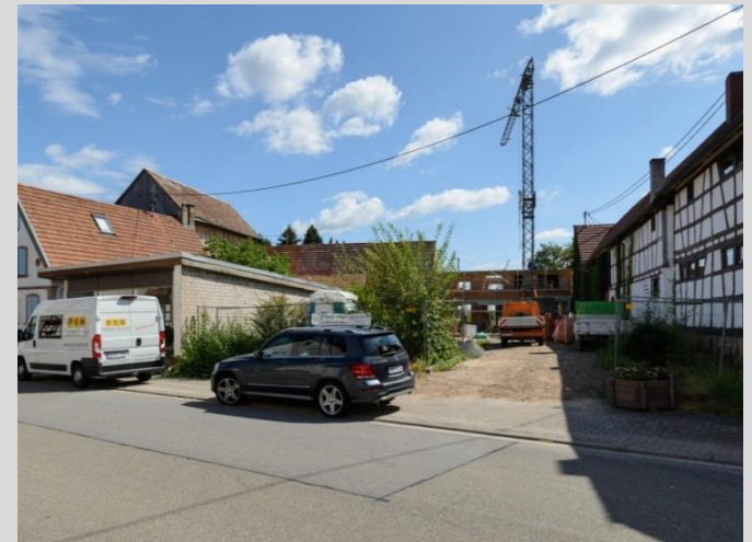
Baustelle, Zustand Sommer 2018.
