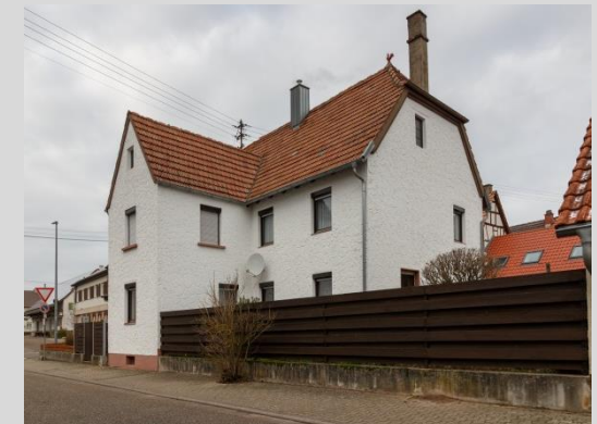
Haus Nr. 116, Ansicht von der Feldstraße.
