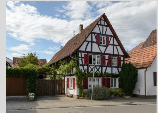
Wohnhaus, Ansicht von Osten.
