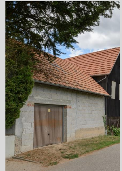
Nebengebäude (Garage), Ansicht vom Kapellenweg.
