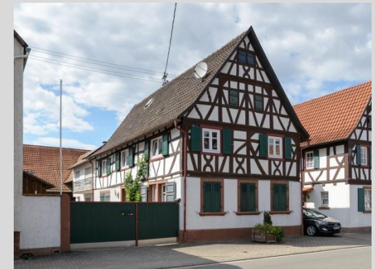
Wohnhaus, Ansicht von Osten.
