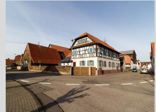
Gesamtanlage am Kurvenverlauf der Hauptstraße.
