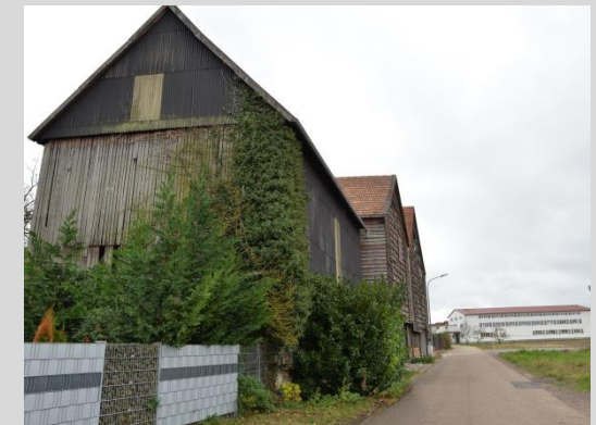
Tabakschuppen, Ansicht von der Friedhofstraße.
