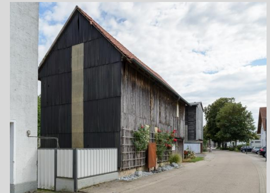
Tabakschuppen, Ansicht von der Friedhofstraße.
