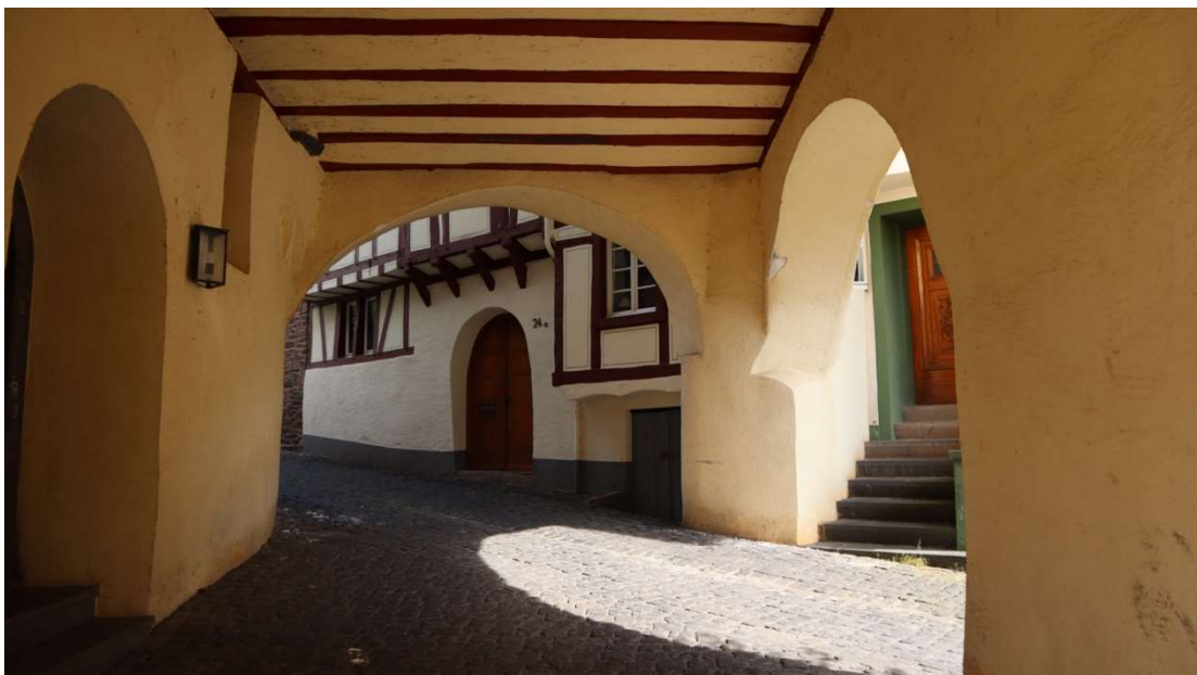
Abb. 18: Spiel- und Rathaus, Blick auf den Durchgang der Brunnenstraße im Bereich der ehemaligen Verkaufslauben unterhalb des Rathauses, im Hintergrund die Fassade von Haus Nr. 24 a, rechts daneben Nr. 24, links der rundbogige Eingang zum Rathaus.
