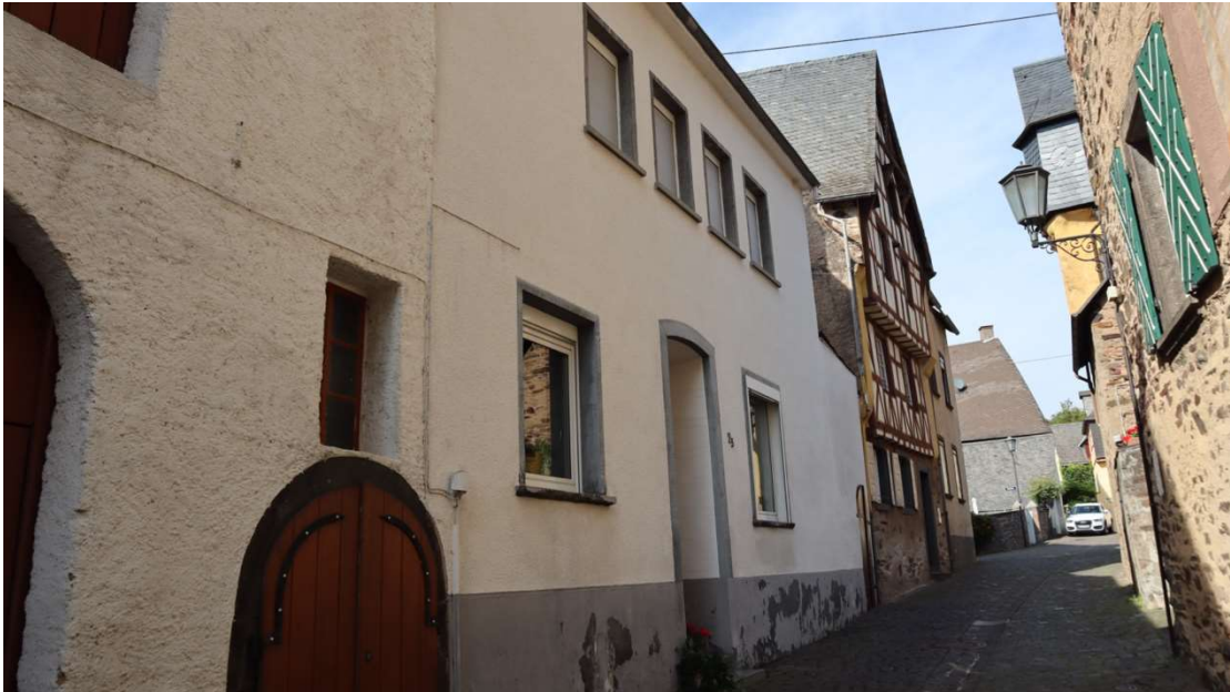
Abb. 43: an Brunnenstraße 23, Blick von Südosten auf die Häuserfassaden 21 & 23, links im Bild eine erhaltene Schrottür mit Gewände aus Basaltlava 4 .
