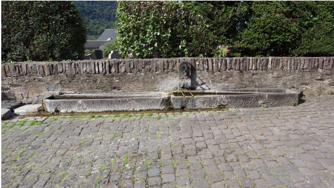
Abb. 57: bei Brunnenstraße 31, Brunnenanlage mit zwei Becken aus Basalt.
