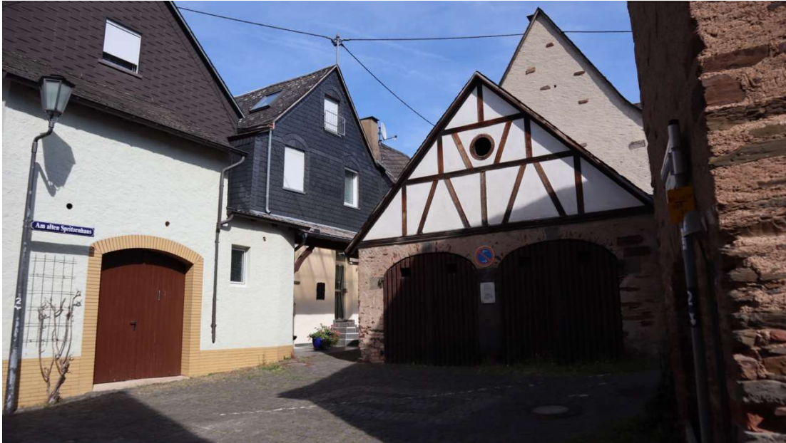
Abb. 7: Blick aus der Brunnenstraße auf das Einzeldenkmal Altes Spritzenhaus mit vorgelagerter, platzartiger Situation durch die Kreuzung Brunnenstraße/Am alten Spritzenhaus.
