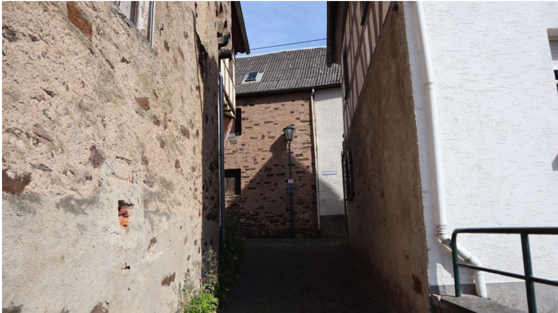
Abb. 79: Nikolausstraße, Blick in Richtung Brunnenstraße, links die Hausmauer mit rundbögigen Konsolsteinen von Brunnenstraße 13.
