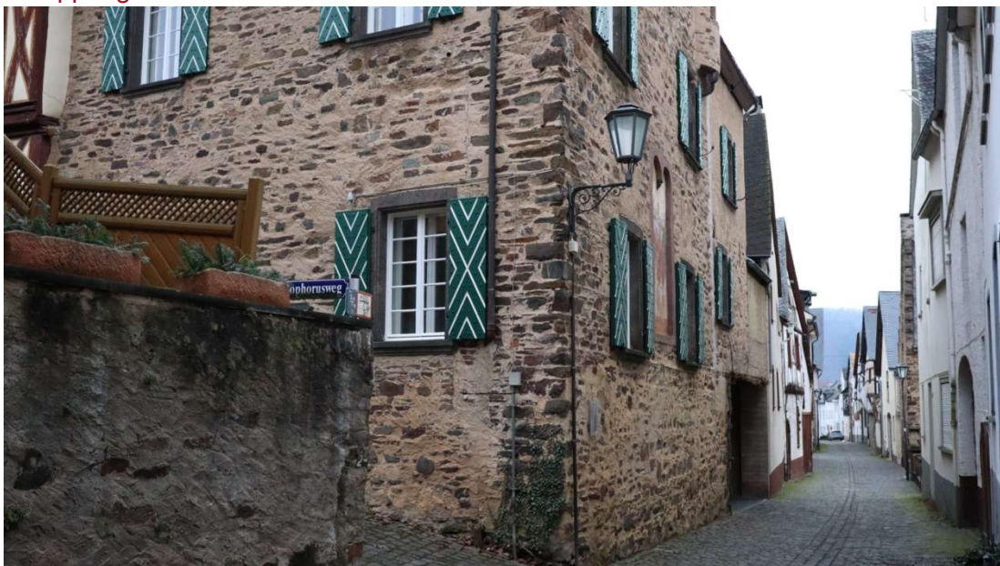
Abb. 62: Christophorusweg 2, Blick auf die nordwestliche Gebäudekante, Erd- und Obergeschoss sowie den südlichen Anbau mit Durchfahrt.
