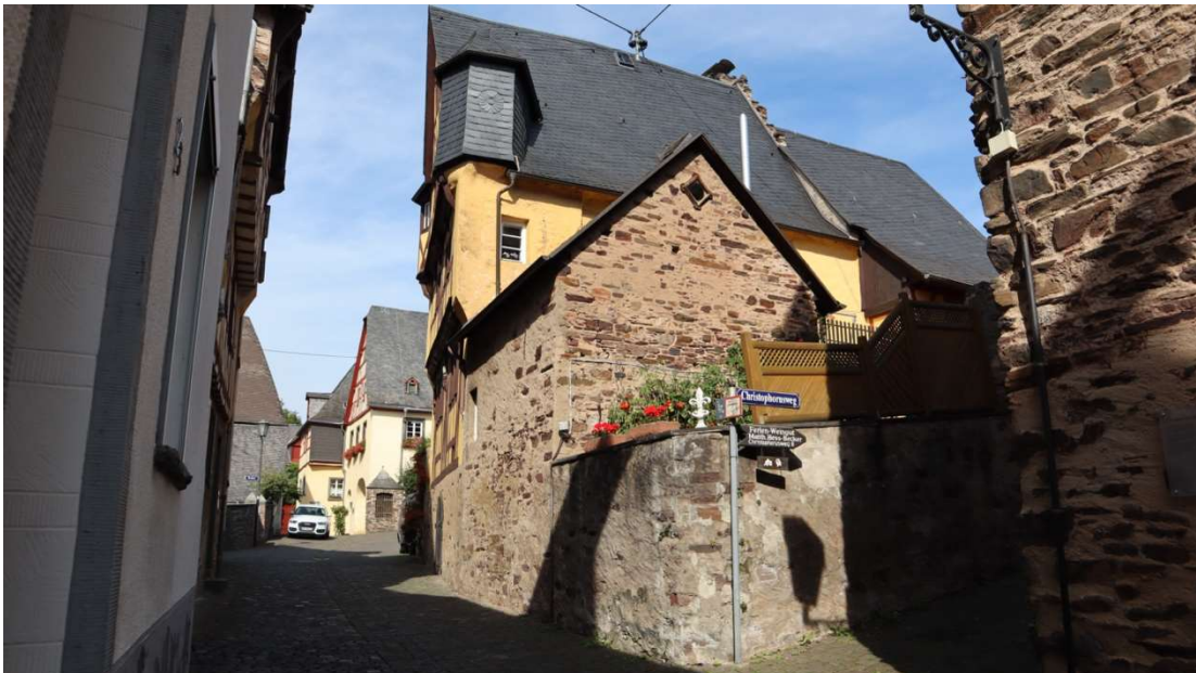
Abb. 40: Brunnenstraße 22, Ansicht von Südwesten auf einen Anbau und Verlauf der Einfriedung, davor die Einmündung des Christophoruswegs.
