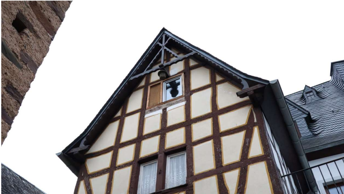
Abb. 91: Brunnenstraße 13, Detailaufnahme des Schwebegiebels.
