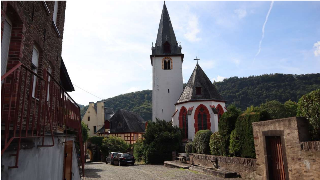
Abb. 51: Brunnenstraße 31, Kath. Pfarrkirche Maria Himmelfahrt, Blick von Osten auf die Ummauerung des 20. Jh., im Hintergrund Rathaus und Hofhaus des Klosters Engelport.
