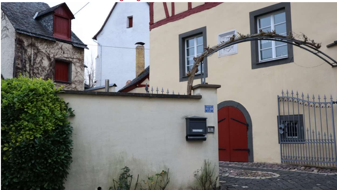
Abb. 86: Rathausstraße 11/13, Blick von Westen auf Hochkeller und Erdgeschoss mit Kellerabgang aus Basaltlava.
