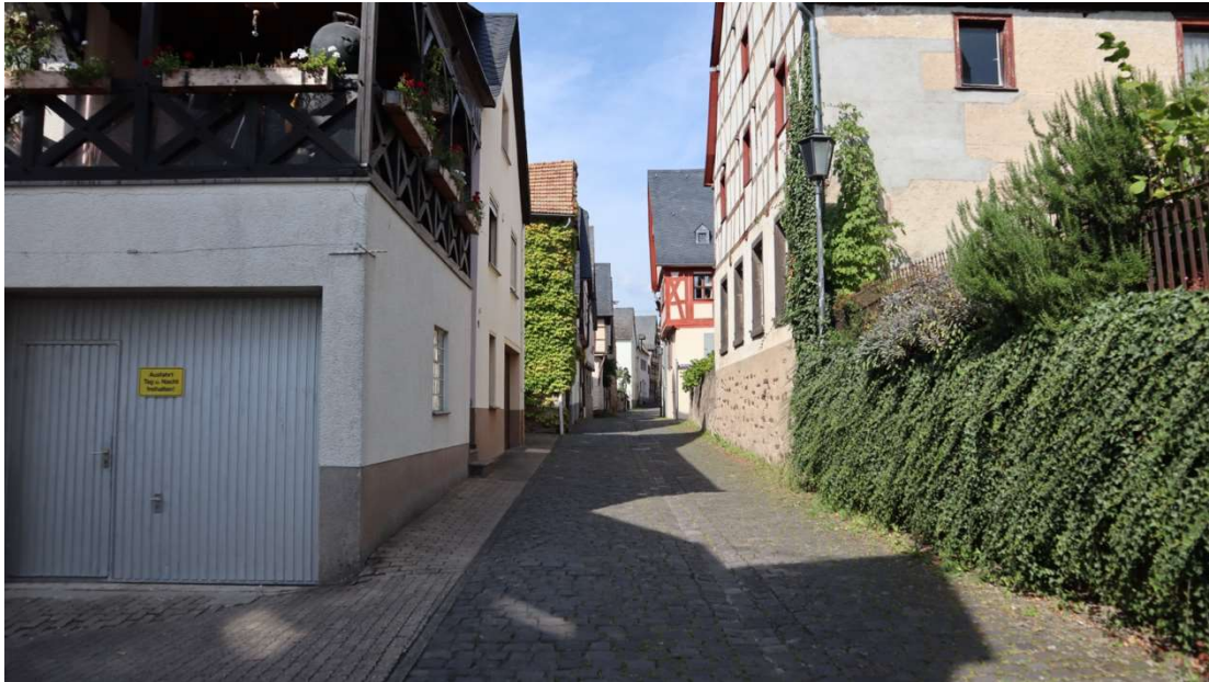
Abb. 11: Brunnenstraße, Ansicht von Süden mit Blick in den Straßenverlauf, rechts die Hofanlage Brunnenstraße 16, dahinter die Einmündung des Martinswegs.
