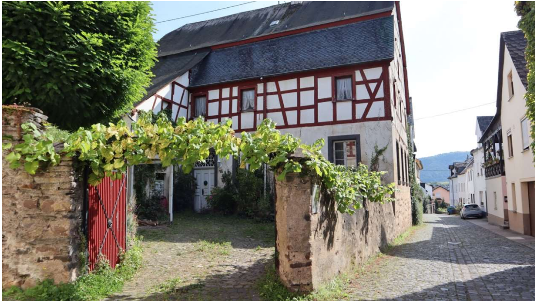
Abb. 29: Brunnenstraße 16, Ansicht von Nordwesten mit Blick in den Innenhof mit historischer Pflasterung sowie die historische Einfriedung mit schmiedeeisernem Hoftor.
