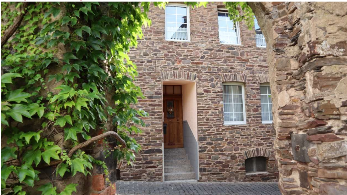
Abb. 50: Brunnenstraße 26, Ansicht vom Kirchhof aus mit Blick auf die Eingangssituation mit bauzeitlichem Türblatt der 1920er Jahre.
