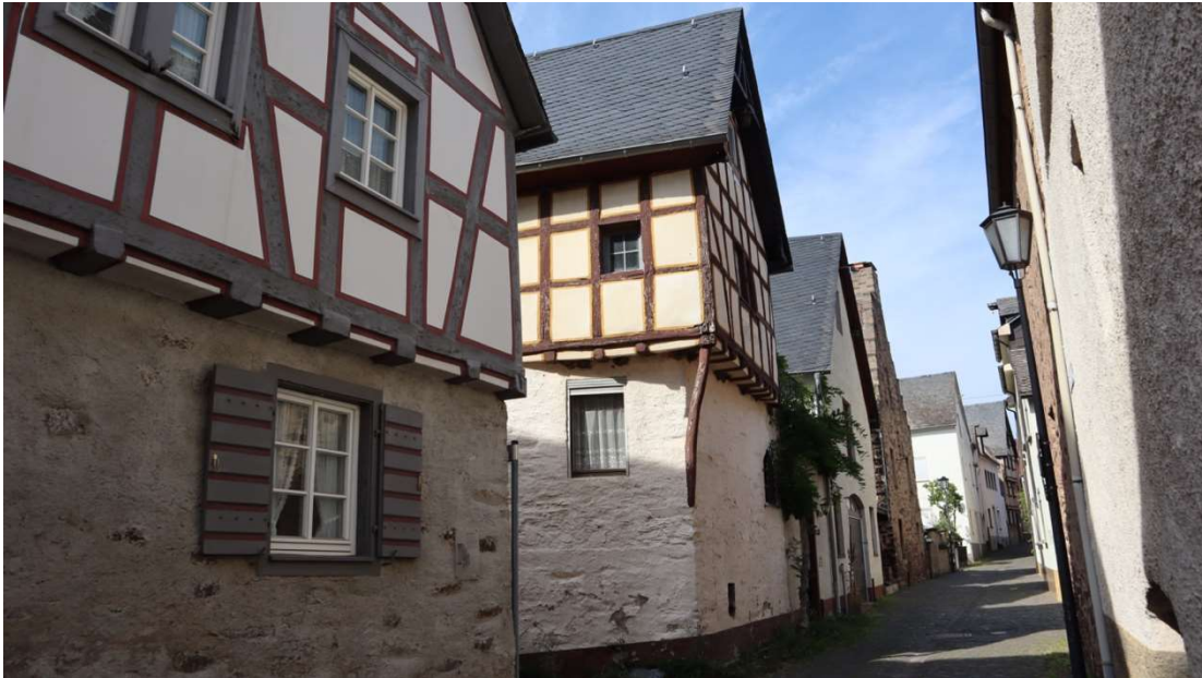
Abb. 25: Brunnenstraße 13, Ansicht von Südosten mit Blick auf den hohen Sockel des Fachwerk-Wohnhauses, davor die Einmündung der Nikolausstraße mit Haus Nr. 4.
