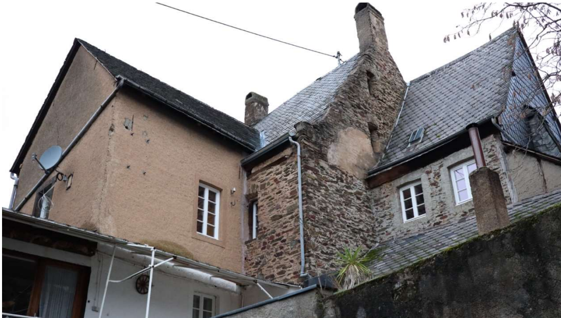
Abb. 65: Christophorusweg 2, Blick von Südosten auf die rückwärtige Situation.
