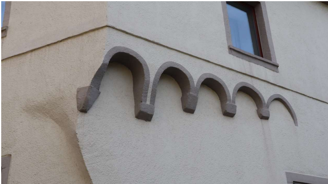
Abb. 90: Rathausstraße 16, Detailaufnahme der rundbogigen Konsolsteine am Obergeschoss der nordöstlichen Gebäudeecke.
