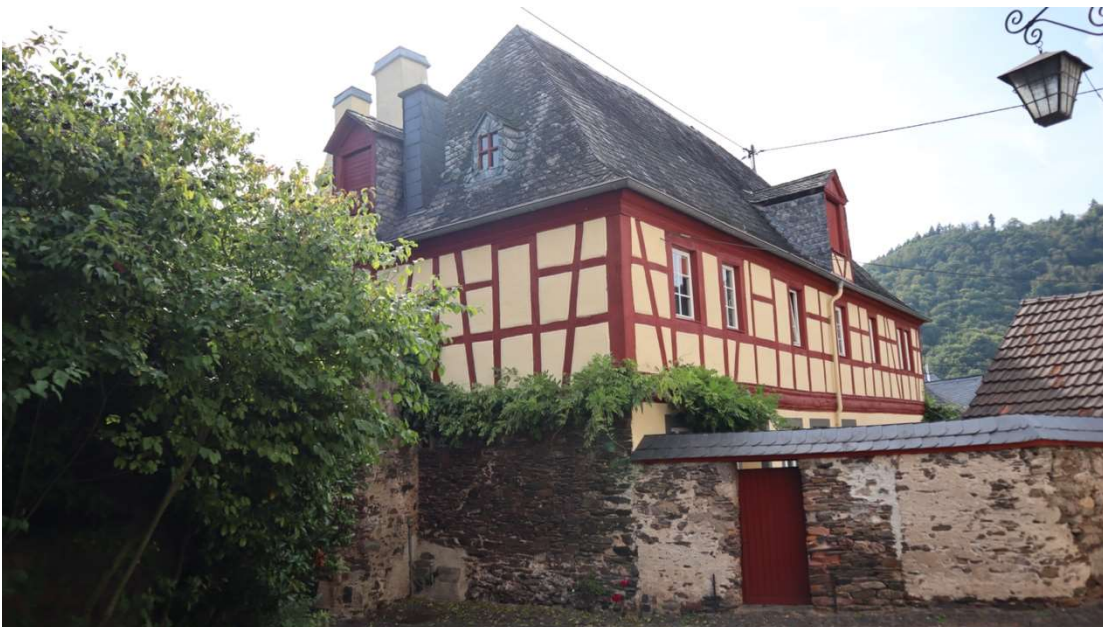
Abb. 88: Rathausstraße 11/13, Ansicht von Nordosten auf das Fachwerkgefuge des Obergeschosses sowie die vorgelagerte Grenzmauer zum Kirchareal.
