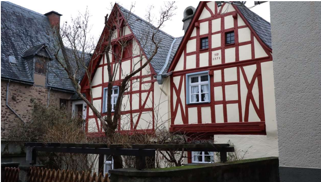
Abb. 35: Brunnenstraße 19, Blick von Nordosten auf die Fachwerkfassaden der Doppelhausanlage mit mittig verbindendem Satteldach.
