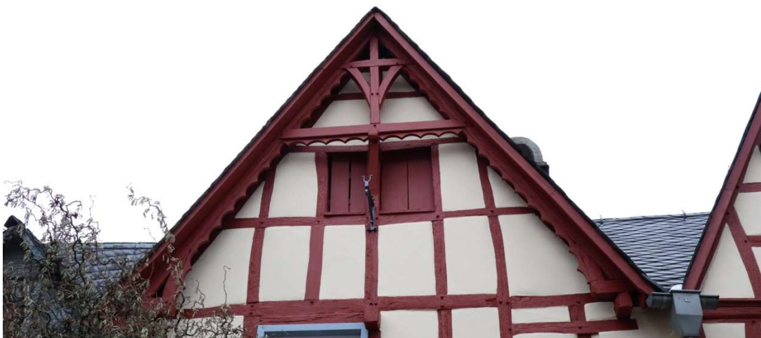
Abb. 92: Brunnenstraße 19, Detailaufnahme des Schwebegiebels am südlichen Wohnhaus.
