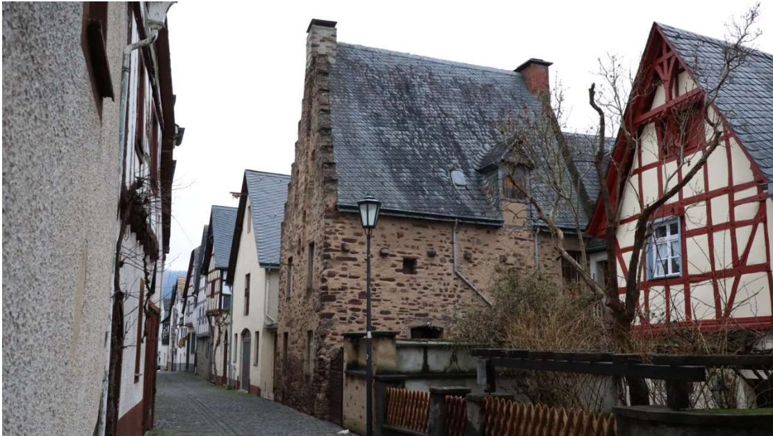
Abb. 33: Brunnenstraße 17, Ansicht von Nordosten mit Blick in den Verlauf der Brunnenstraße, rechts das südliche Fachwerkhaus der Doppelhausanlage Nr. 19 mit Schwebegiebel.
