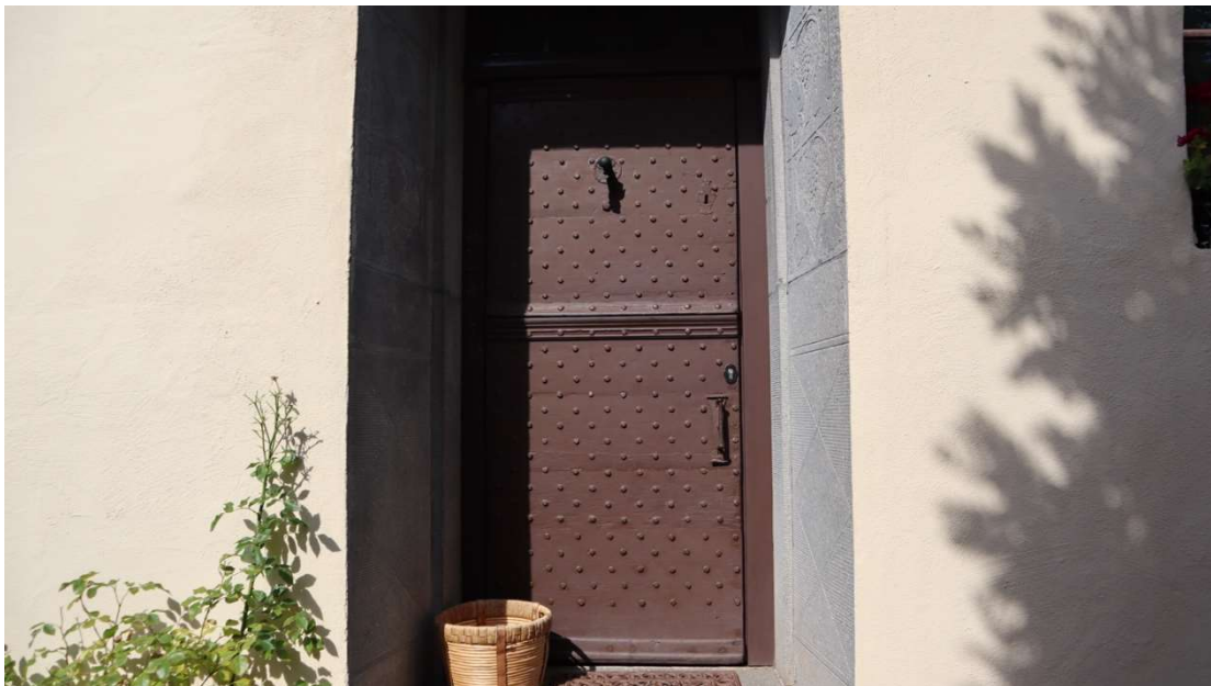
Abb. 96: Martinsweg 1, Detailaufnahme der eines mit Nieten beschlagenen, zweigeteilten Türblatts des wohl 16. Jh.
