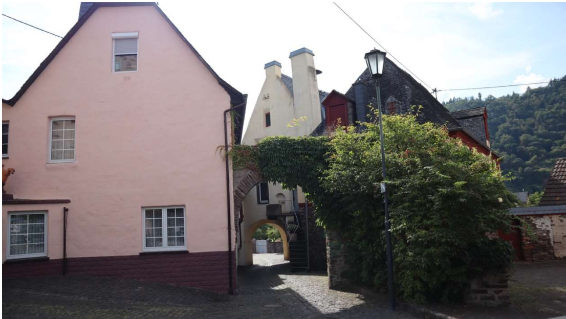
Abb. 15: Brunnenstraße, Blick in den nordöstlichen Straßenarm und das Kirchtor, im Hintergrund der steinerne Giebel sowie Laubengang des Spiel- und Rathauses.
