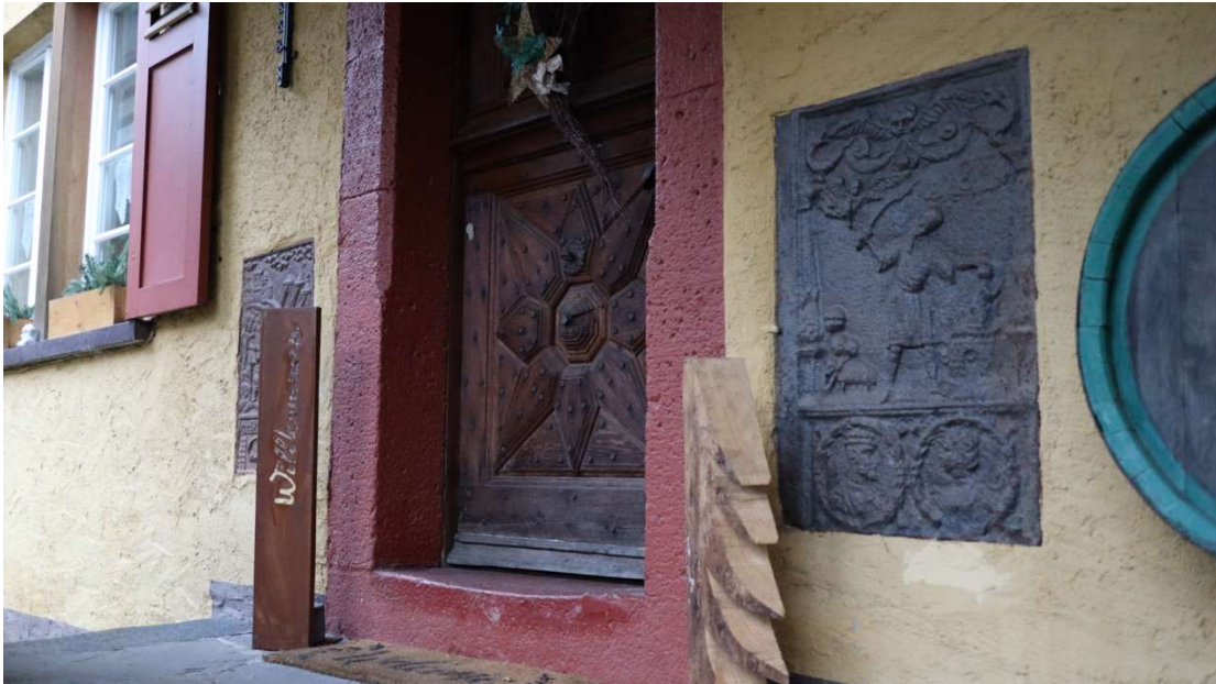
Abb. 97: Brunnenstraße 22, Detailaufnahme der Eingangssituation mit zweigeteiltem, barockem Türblatt und gusseisernen Takenplatten.
