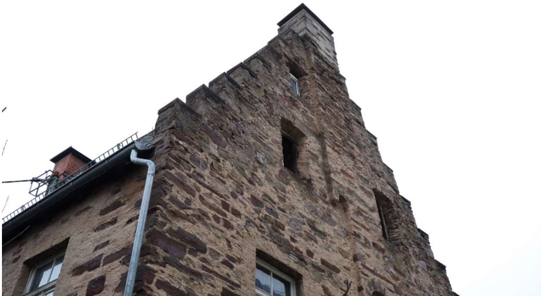
Abb. 94: Brunnenstraße 17, Detailaufnahme des Treppengiebels.
