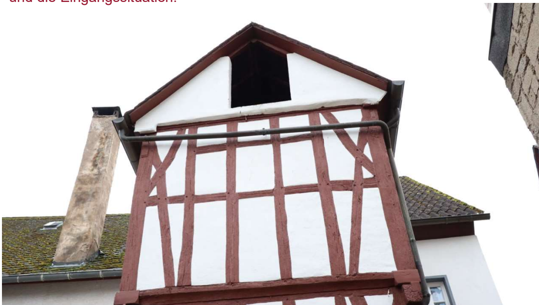
Abb. 68: Christophorusweg 4, Detailaufnahme des Fachwerkgiebels mit offener Speicherluke.
