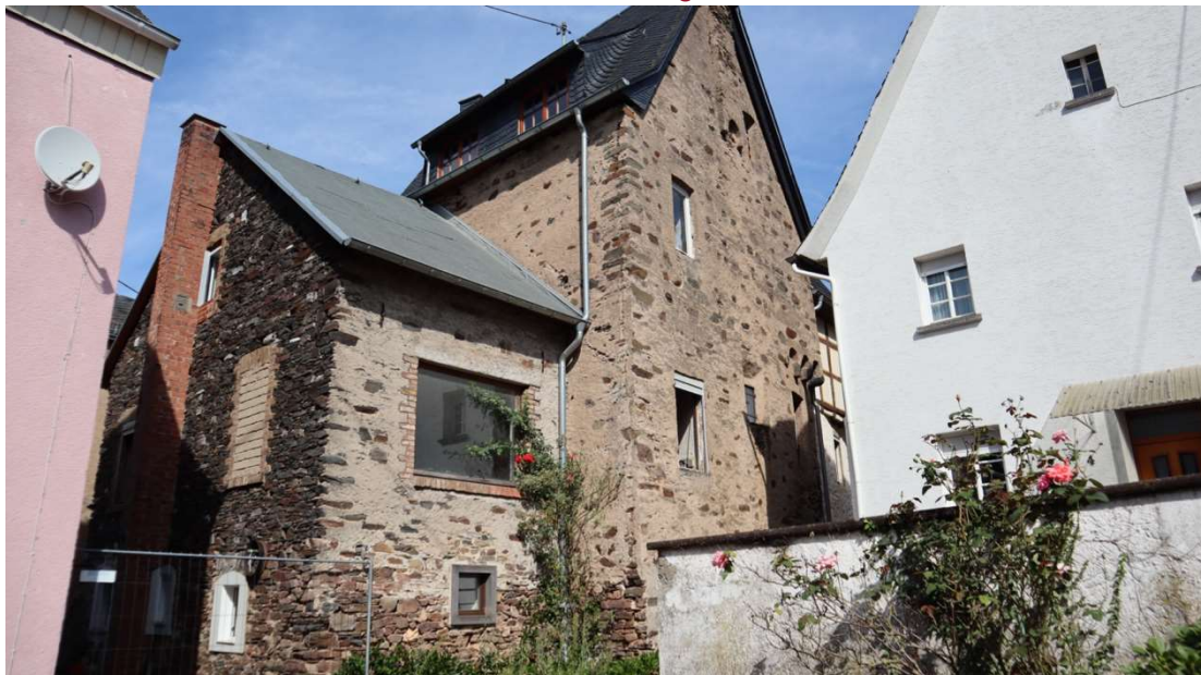
Abb. 26: Brunnenstraße 13, Blick von Südwesten auf den rückwärtigen Bruchsteinmauerbau mit rundbogigen Konsolsteinen und Kaminlisenen sowie den niedrigeren Anbau, rechts die Rückseite des Hauses Nikolausstraße 4.
