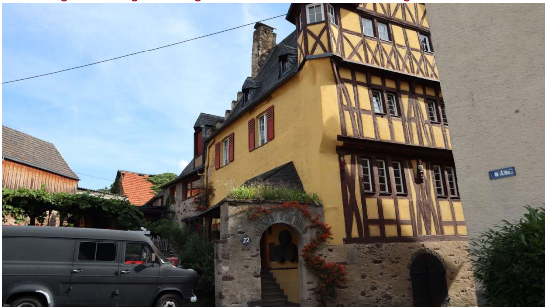
Abb. 38: Brunnenstraße 22, Blick aus der Bachstraße auf die Fachwerk-Giebelseite mit Kellerabgang sowie auf das angrenzende rundbogige Portal als Fragment der ehemaligen Einfriedungsmauer des Hofes.
