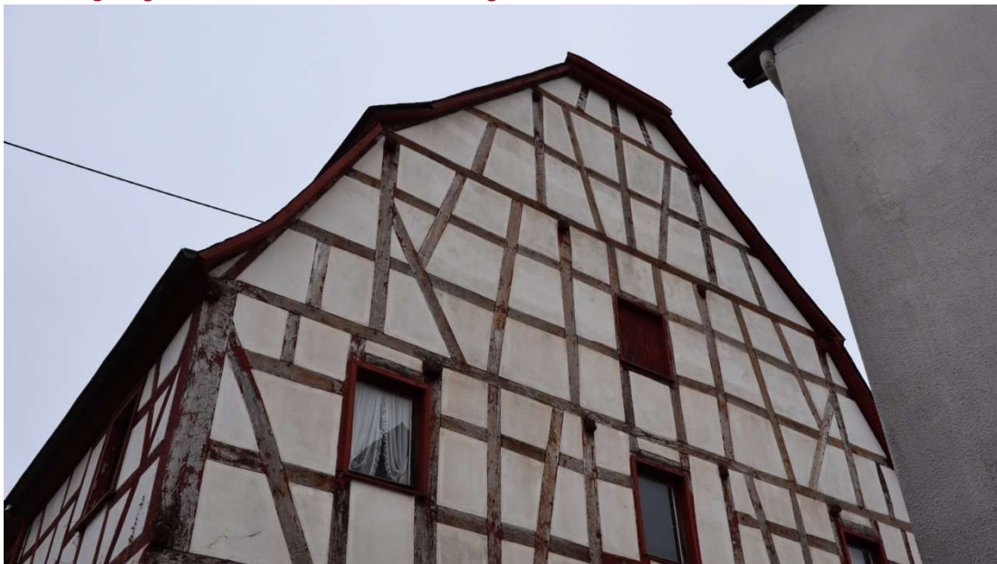
Abb. 32: Brunnenstraße 16, Detailaufnahme des zweizonigen Fachwerkgiebels von Nordwesten aus gesehen.
