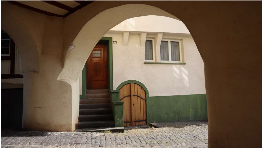
Abb. 45: Brunnenstraße 24, Blick von Norden durch den Laubengang des Rathauses auf die Hausfassade mit Kellerabgang und vorkragendem Obergeschoss.
