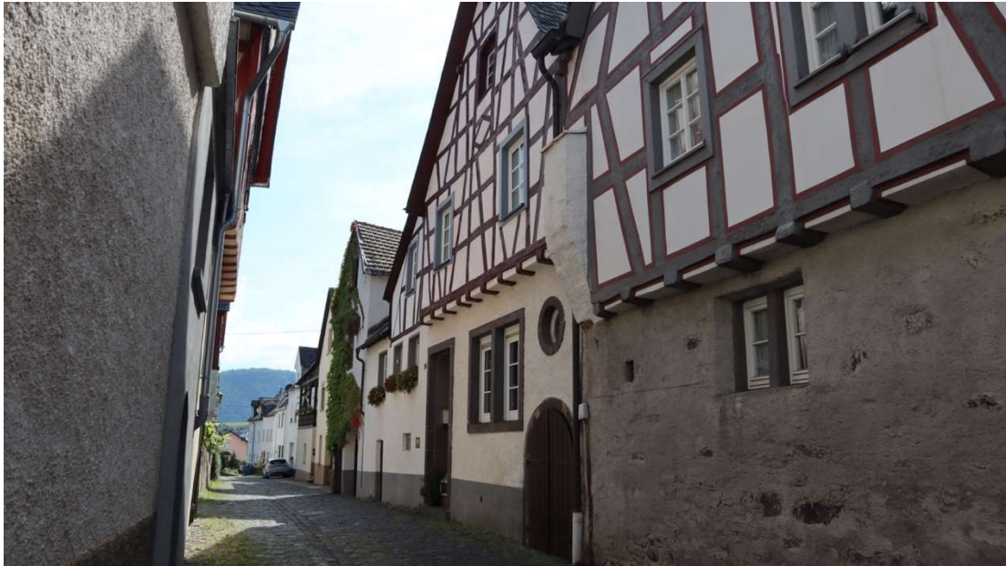
Abb. 23: Brunnenstraße 11 & Nikolausstraße 4, Blick von Nordosten auf beide Häuserfassaden mit den Resten einer dazwischenliegenden Brandmauer.
