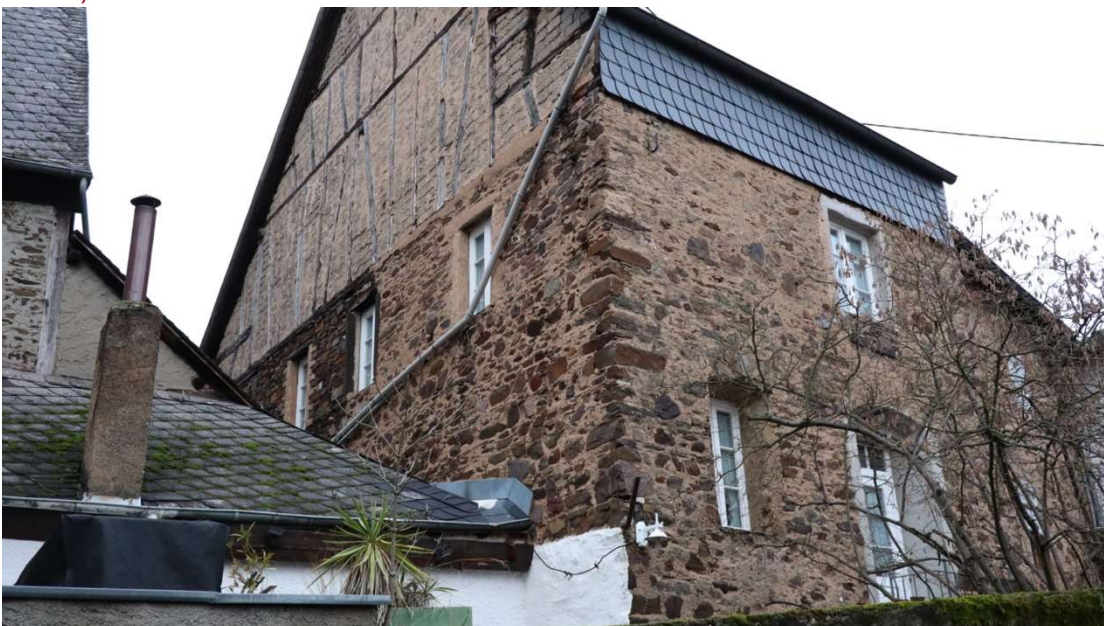
Abb. 70: Christophorusweg 4, Ansicht von Südwesten, rückwärtiger Bruchsteinmauerbau mit hohen Fachwerkgiebel, links außen die Anbauten von Nr. 2.
