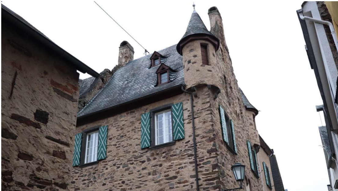
Abb. 61: Christophorusweg 2, Blick von Nordwesten auf Obergeschoss, Dachsituation und Treppengiebel.
