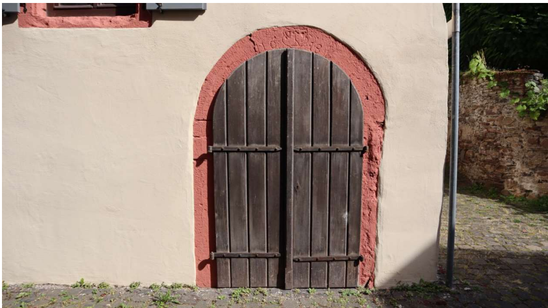
Abb. 74: Martinsweg 1, Detailaufnahme des rundbogigen Kellerabgangs mit Inschrift.
