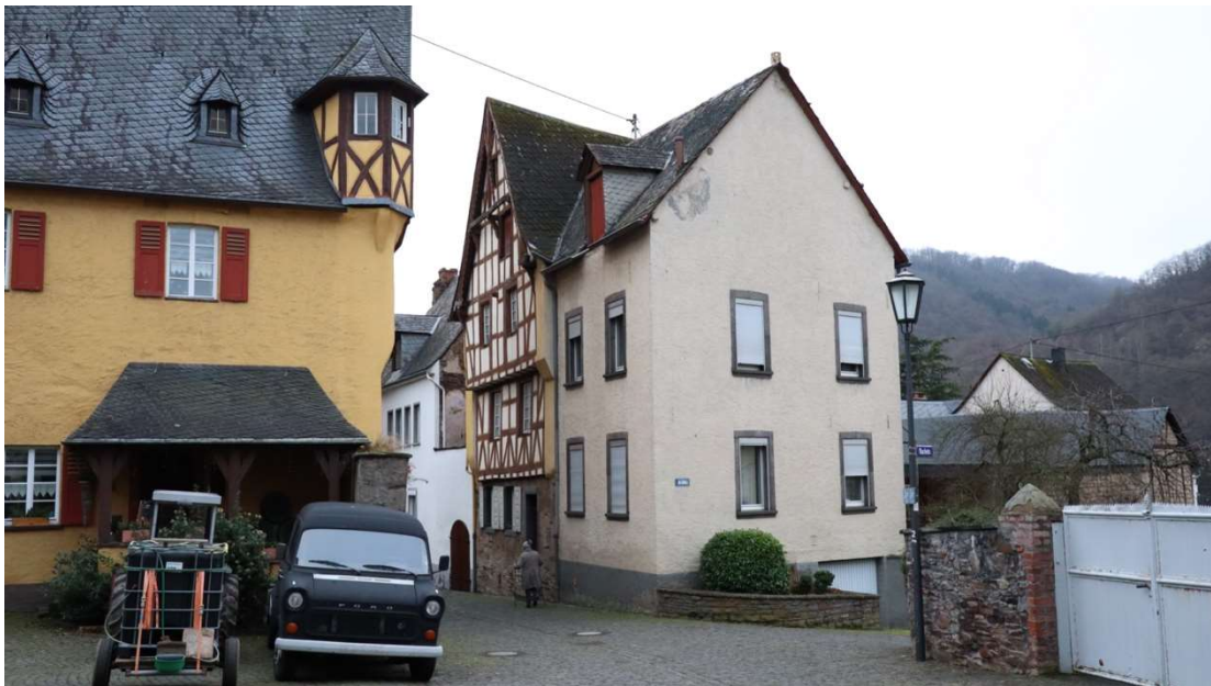
Abb. 47: Brunnenstraße 25, Blick von Nordosten auf das historische Fachwerkhaus mit Schwebegiebel sowie den nördlich angrenzenden Massivbau, links Nr. 22.
