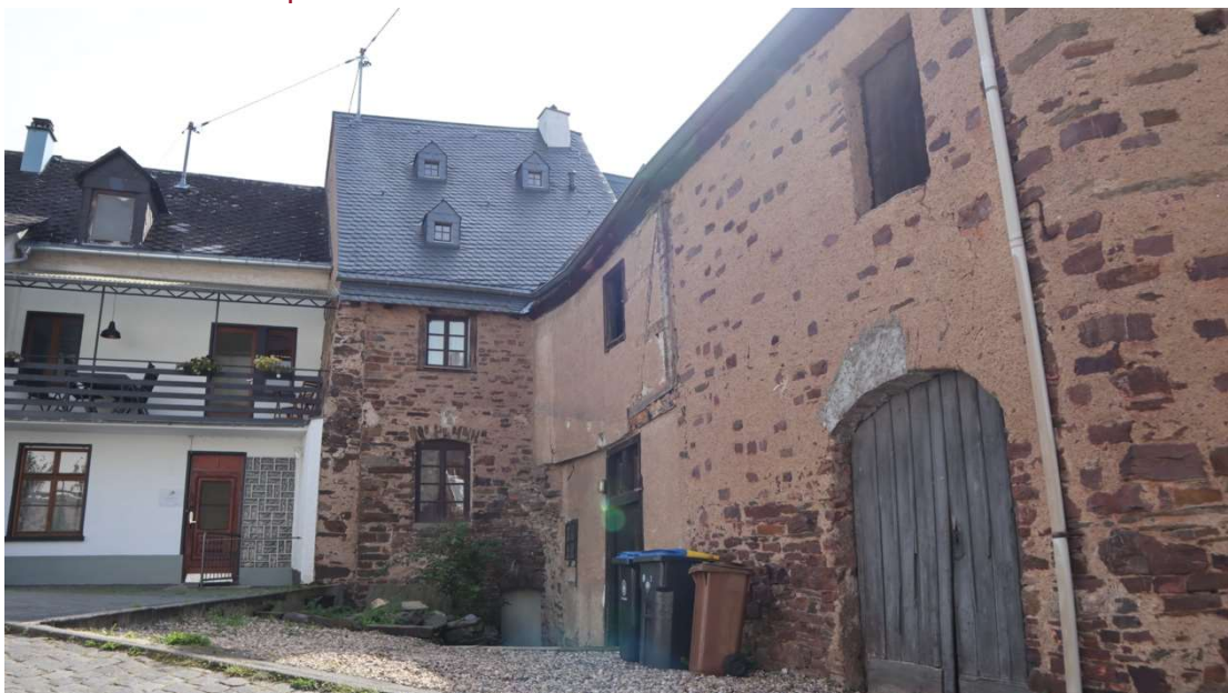
Abb. 76: Martinsweg 1, Ansicht von Nordosten auf die Rückseiten des Anbaus und der beiden Ökonomiegebäude mit vorgelagerter Hoffläche entlang der Straße Am alten Spritzenhaus.
