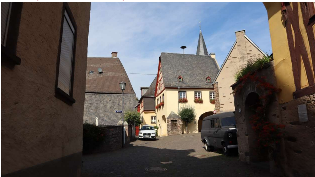
Abb. 14: Brunnenstraße, Blick von Süden in den Dorfmittelpunkt, im Zentrum das Spiel- und Rathaus mit Dorfbrunnen mit sich davor verbreiterndem Straßenraum.
