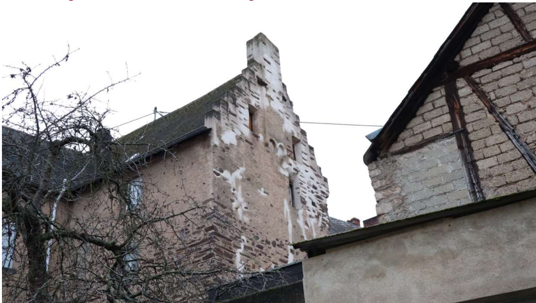
Abb. 48: Brunnenstraße 25, Ansicht aus der Bachstraße auf den rückwärtigen Treppengiebel.
