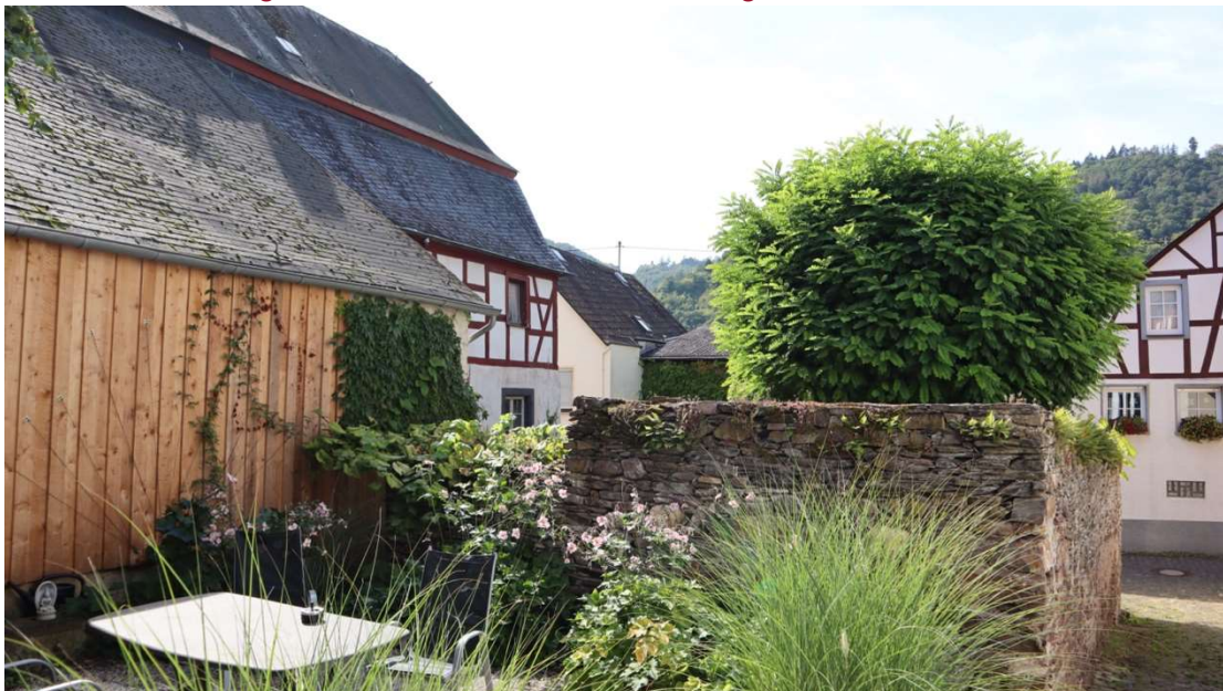
Abb. 30: Brunnenstraße 16, Blick von Osten aus dem Martinsweg heraus auf die historische Einfriedung der Hofanlage.
