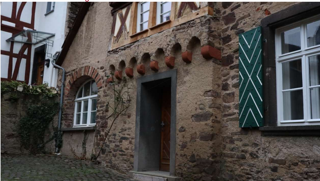
Abb. 64: Christophorusweg 2, Ansicht von Nordwesten auf die Eingangssituation des östlichen Anbaus von 1550 sowie den angrenzenden eingeschossigen Anbau mit Pultdach, links außen eine Begrenzungsmauer zu Nr. 4.
