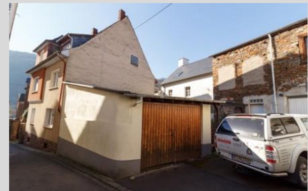
Ansicht von Nordosten.
