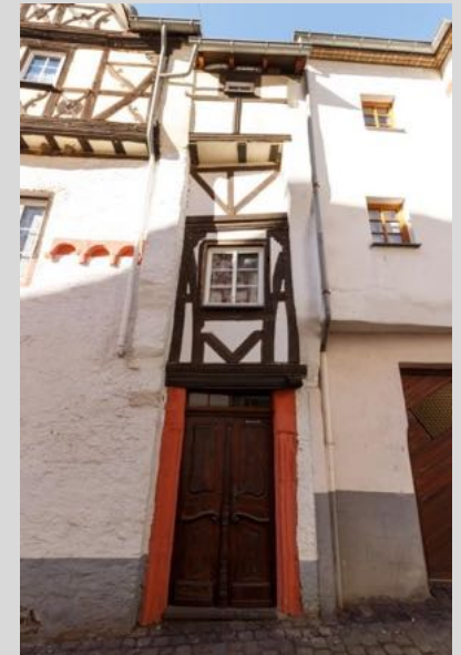
Anbau mit Rokokotür.
