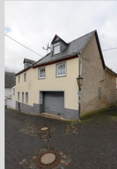
Ansicht von Nordosten.
