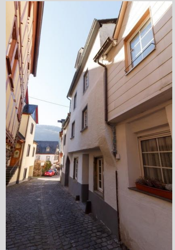
Ansicht von Nordosten.
