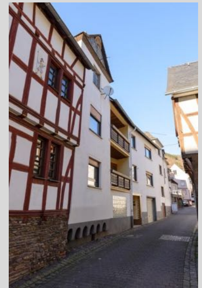
Straßenansicht von Südosten.
