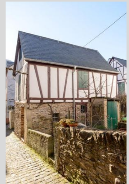
Stall, Ansicht von Nordosten.
