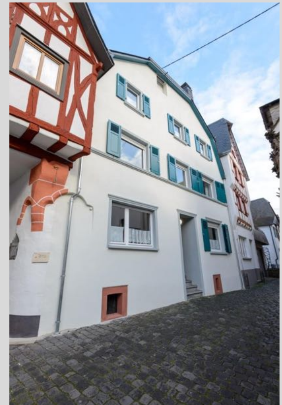
Ansicht von Westen.
