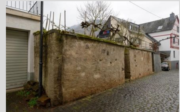
Garten mit Mauer, südöstlich an Nr. 13 angrenzend.
