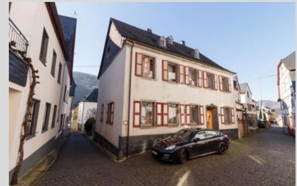
Ansicht von Nordosten.
