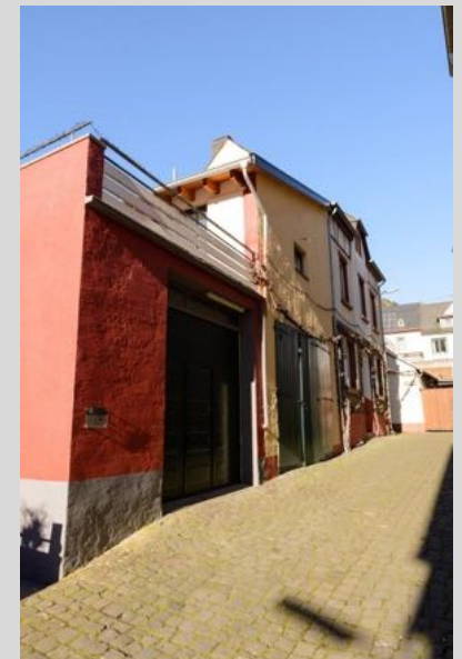
Ensemble aus Wohnhaus und Wirtschaftsgebäuden.
