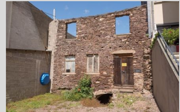
Bruchsteinfassade unterhalb Unterbachstraße 8.
