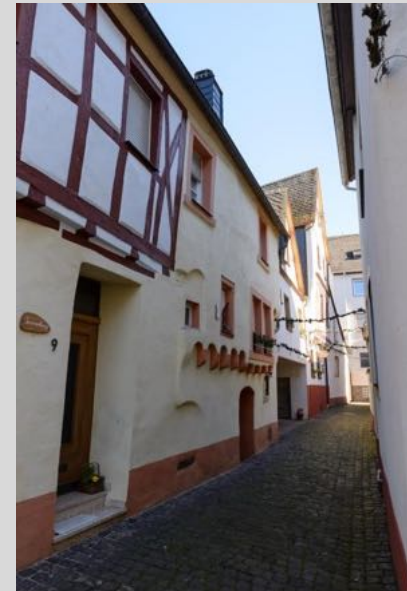
Straßenansicht von Nordwesten.
