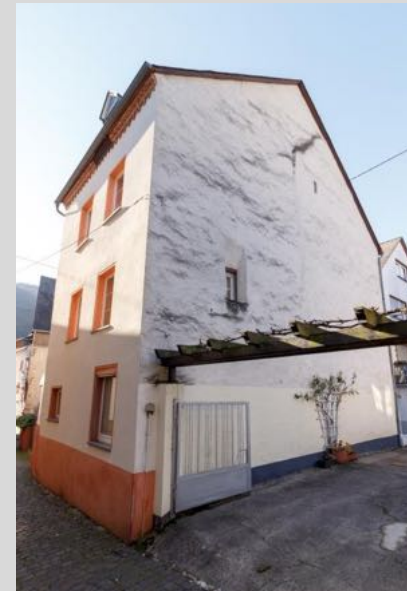
Haus Nr. 10, Ansicht von Nordosten.
