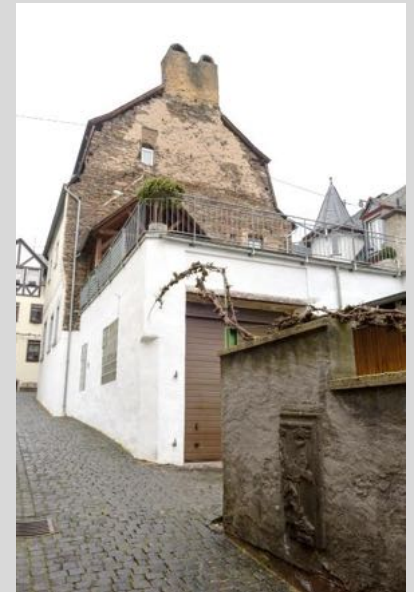
Ansicht von Südwesten, Mauer rechts im Bild.
