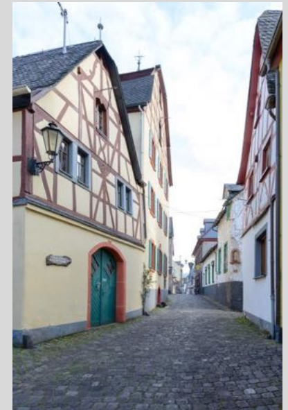
Straßenansicht von Nordwesten.
