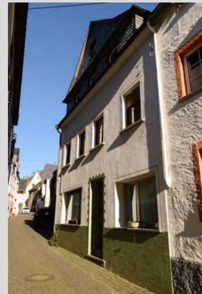
Pützstraße 1, Ansicht von Südwesten.
