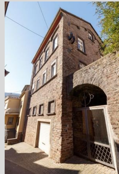
Ansicht von Nordosten, unterhalb.
