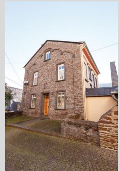
Ansicht von Nordosten, oberhalb.
