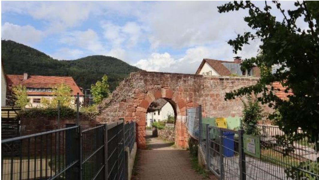
Abb. 55: Rest eines Stadtmauerturms (verändert wiederaufgebaut) an der südwestlichen Ecke der Denkmalzone Altstadt (nahe Flitschberg). Ansicht von Süden. Vorgelagerte Gärten (ehem. Stadtmauergraben).
