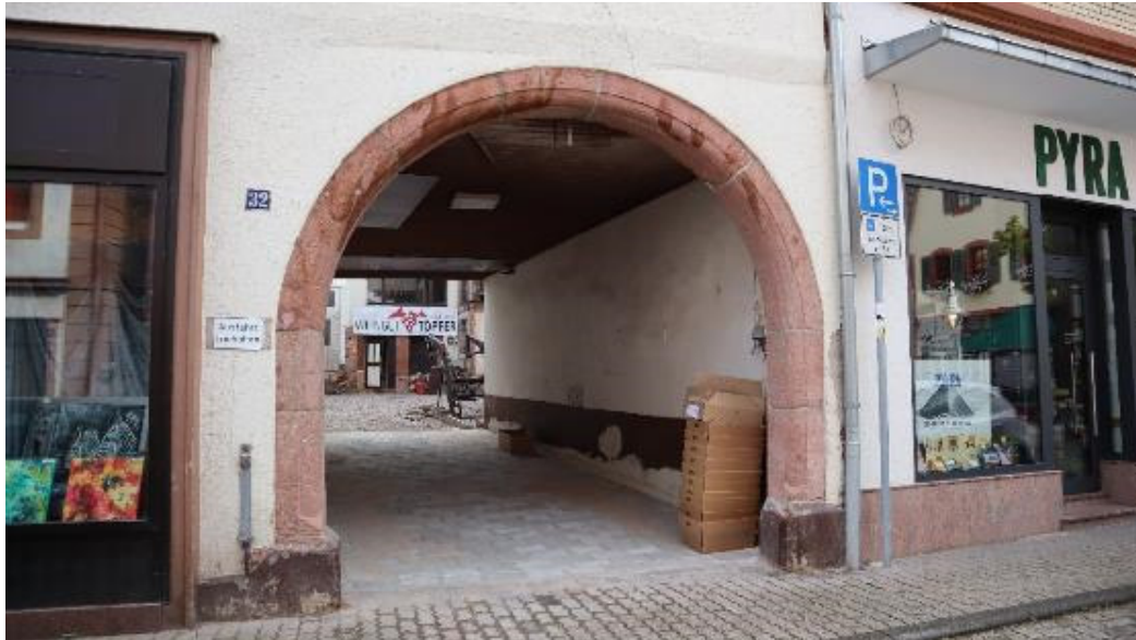
Abb. 94: Torbogen an Hauptstraße 32, Ansicht von Nordosten.
