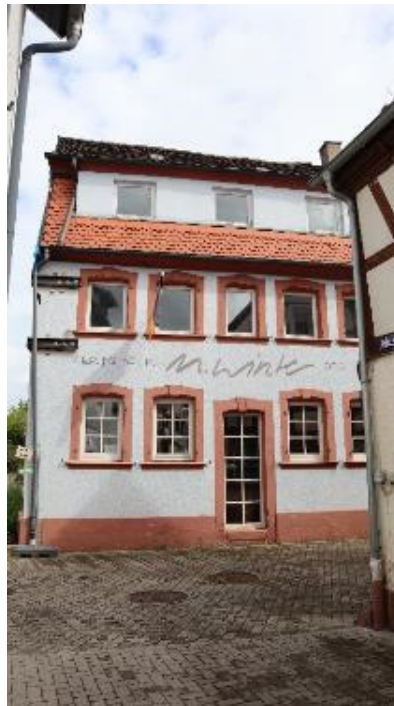
Abb. 136: Quodgasse 10, Ansicht von Nordwesten.
