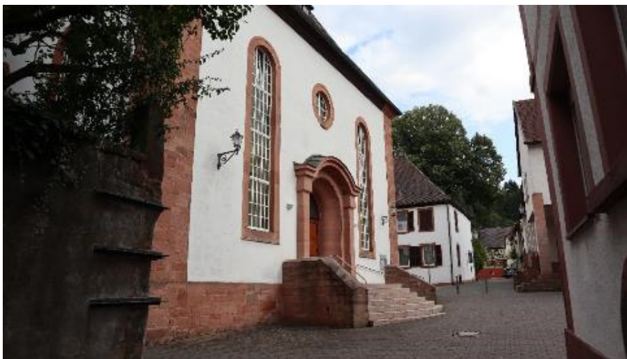
Abb. 108: Hauptstraße 5/7, Stadtkirche. Ansicht von Nordwesten.
