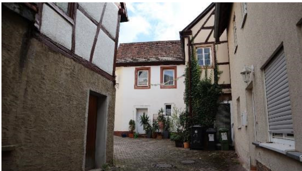
Abb. 38: Diakonissengasse, Straßenansicht und Haus Nr. 2, Ansicht von Norden.
