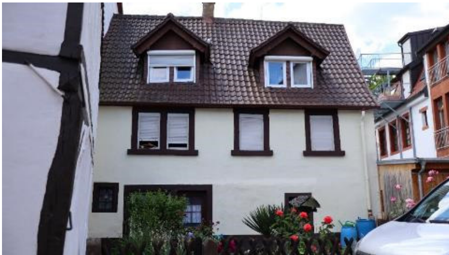
Abb. 28: Am Storchentor 4, Ansicht von Osten.
