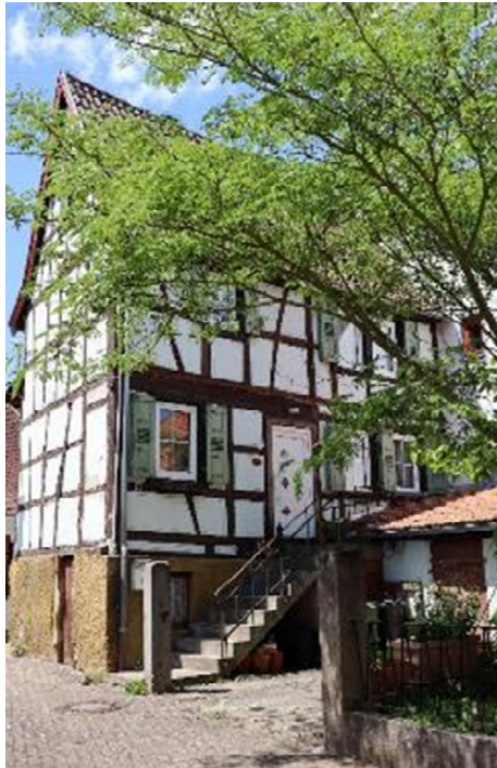
Abb. 26: Am Storchentor 2, Ansicht von Südosten.
