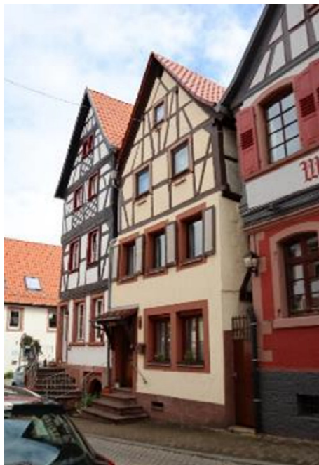
Abb. 42: Flitschberg 3 & 5, Ansicht von Nordwesten.
