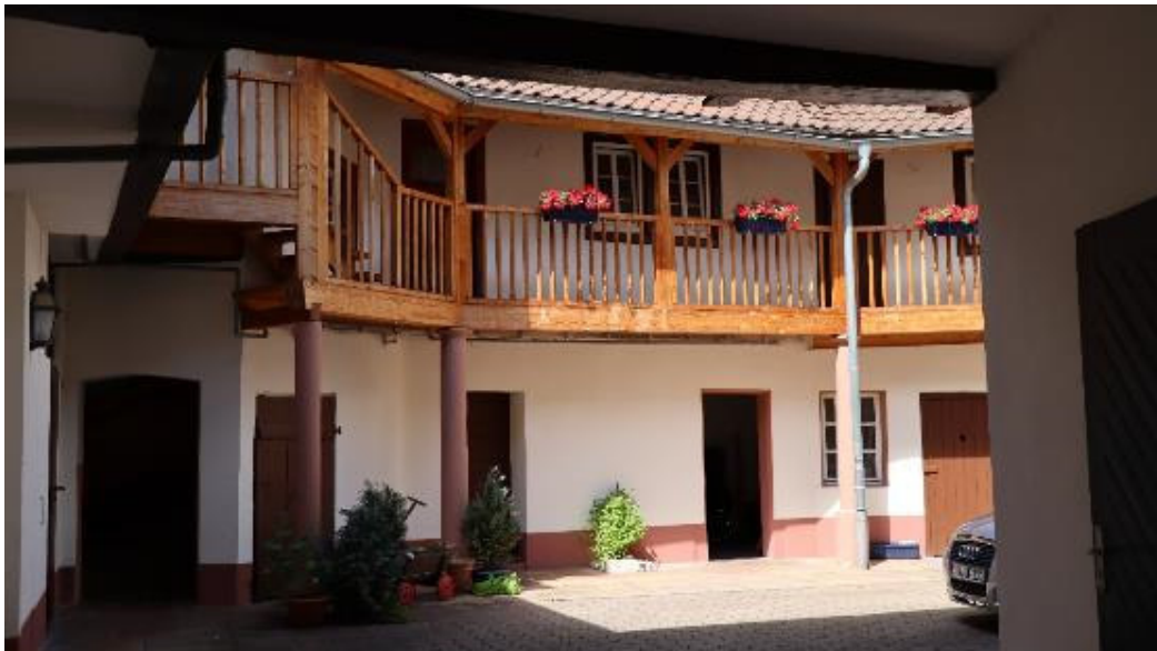
Abb. 77: Polygonaler Renaissance-Treppenturm im Innenhof von Hauptstraße 7. Hier auch Galerie (erneuert), gestützt auf Sandsteinsäulen.
