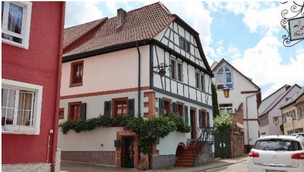
Abb. 14: Altenstraße 19, Ansicht von Nordosten.
