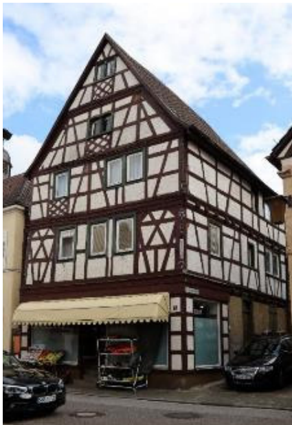
Abb. 8: Altenstraße 11, Ansicht von Nordwesten.
