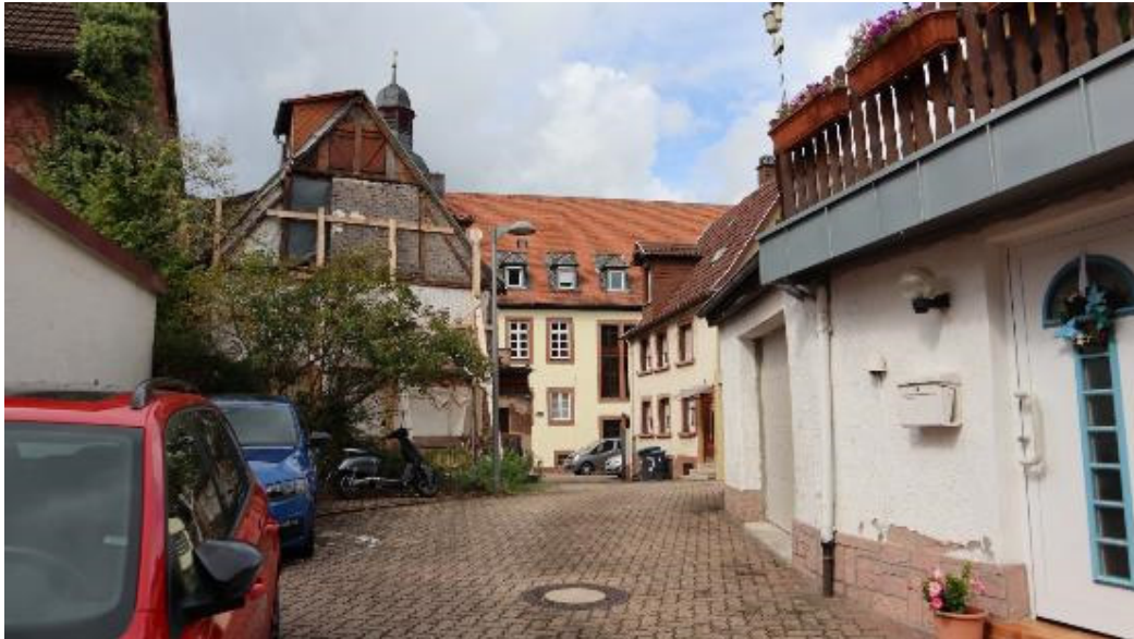
Abb. 113: Klostergasse, Straßenansicht von Süden. Blick auf die Rückseite des Rathauses.
