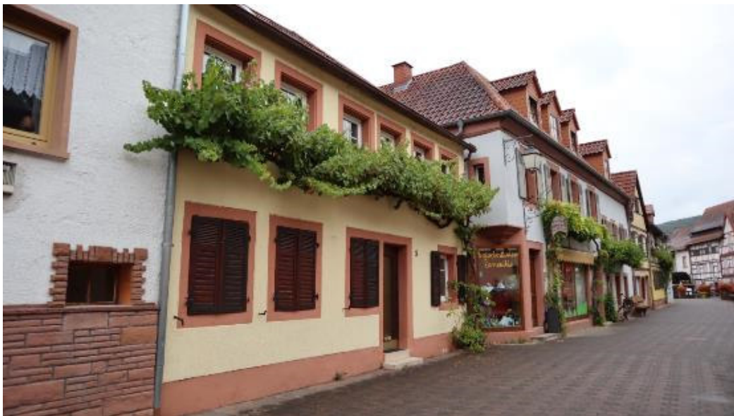
Abb. 159: Wassergasse 5 und 7, Ansicht von Südwesten.
