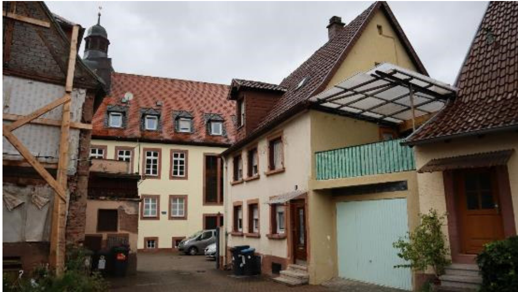
Abb. 115: Klostergasse 2, Ansicht von Südwesten.
