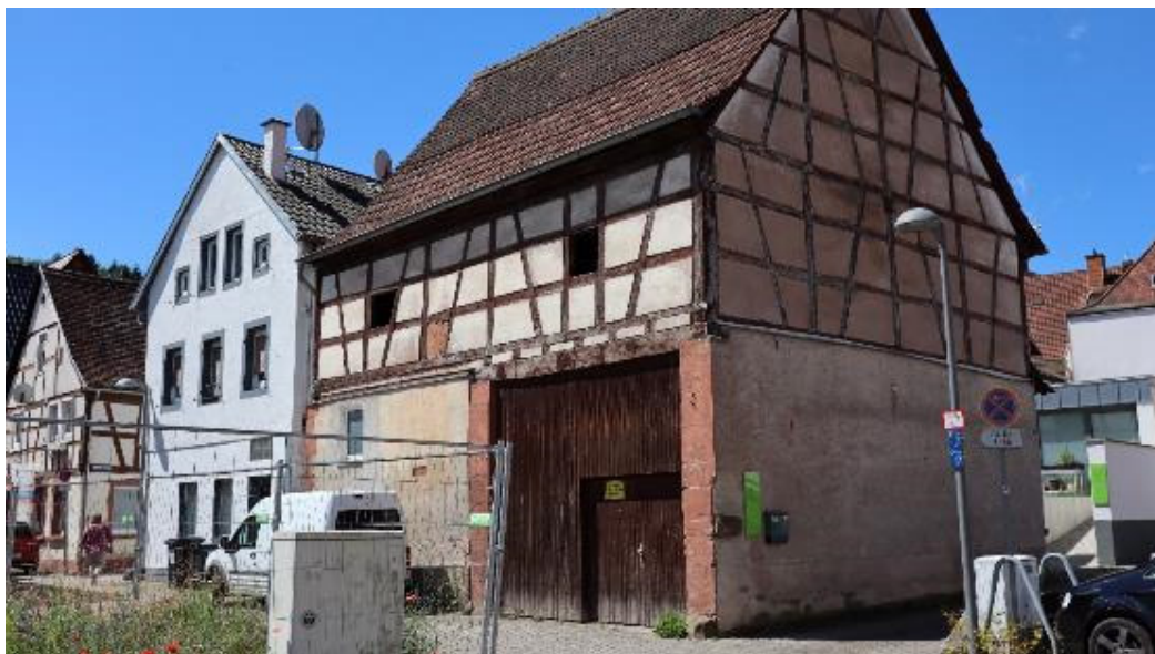
Abb. 134: Quodgasse 3 und angrenzendes Wirtschaftsgebäude (bez. 1750). Ansicht von Nordosten.
