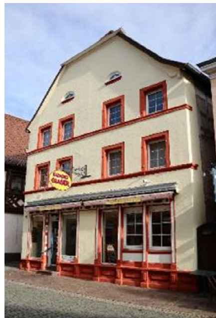
Abb. 90: Hauptstraße 29, Ansicht von Südwesten.
