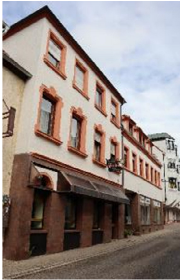
Abb. 96: Hauptstraße 39 und 41, Ansicht von Südwesten.
