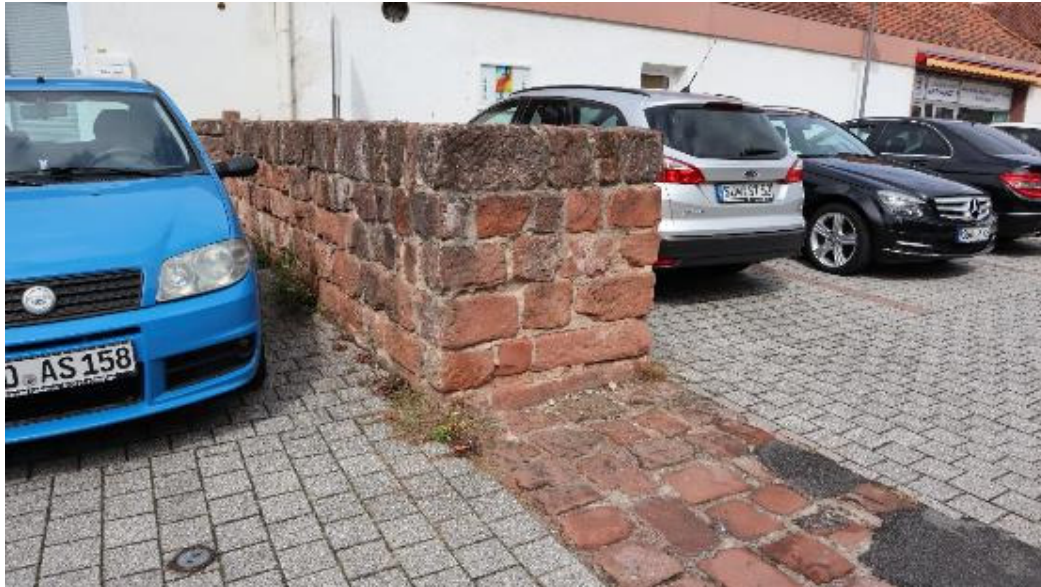
Abb. 140: Stadtmauerrest östlich der Quodgasse. Ansicht von Südwesten.
