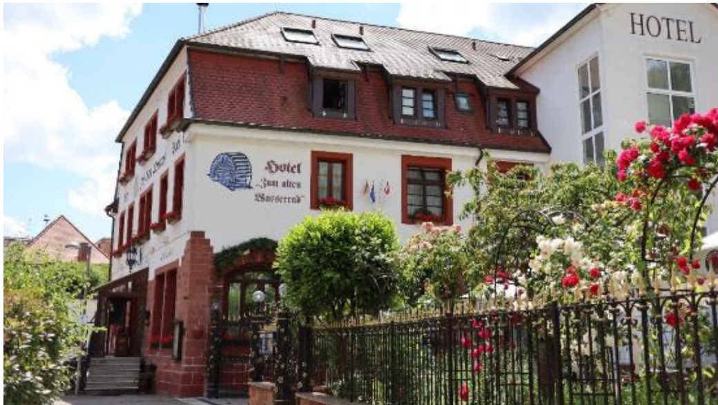
Abb. 31: Am Storchentor 8, Ansicht von Norden.
