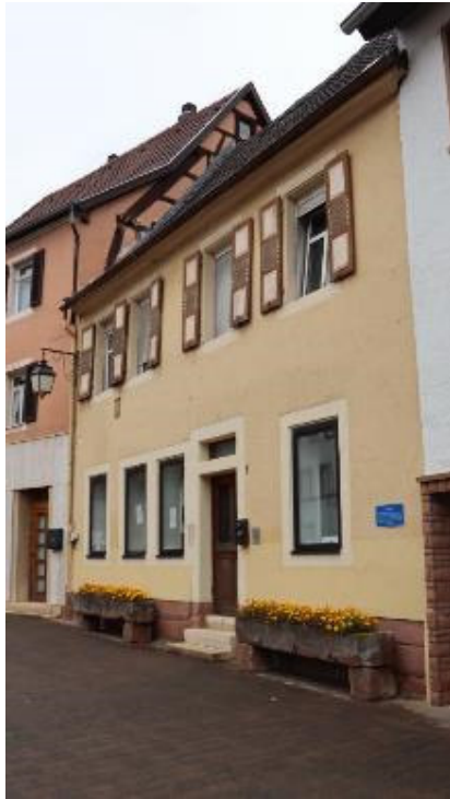
Abb. 160: Wassergasse 1, Ansicht von Südosten.
