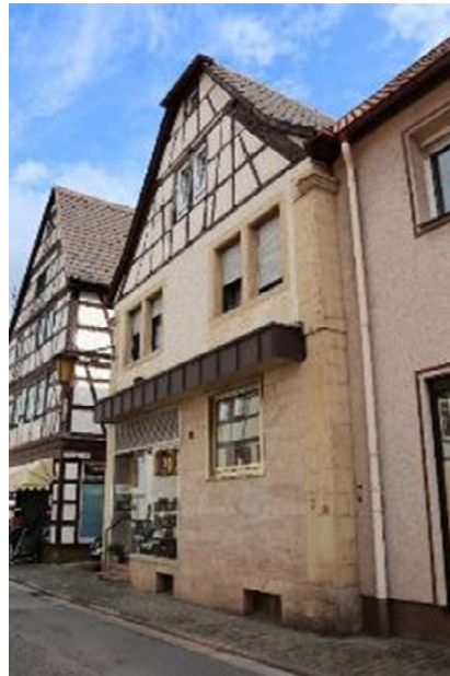
Abb. 9: Altenstraße 13, Ansicht von Nordwesten.
