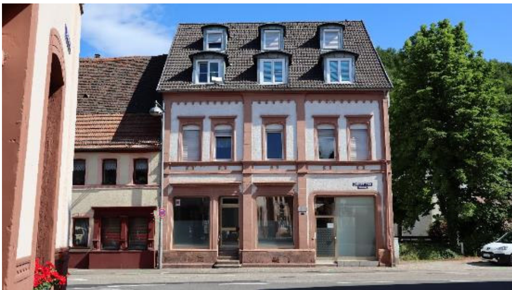
Abb. 166: Zweibrückerstraße 2, Ansicht von Süden.
