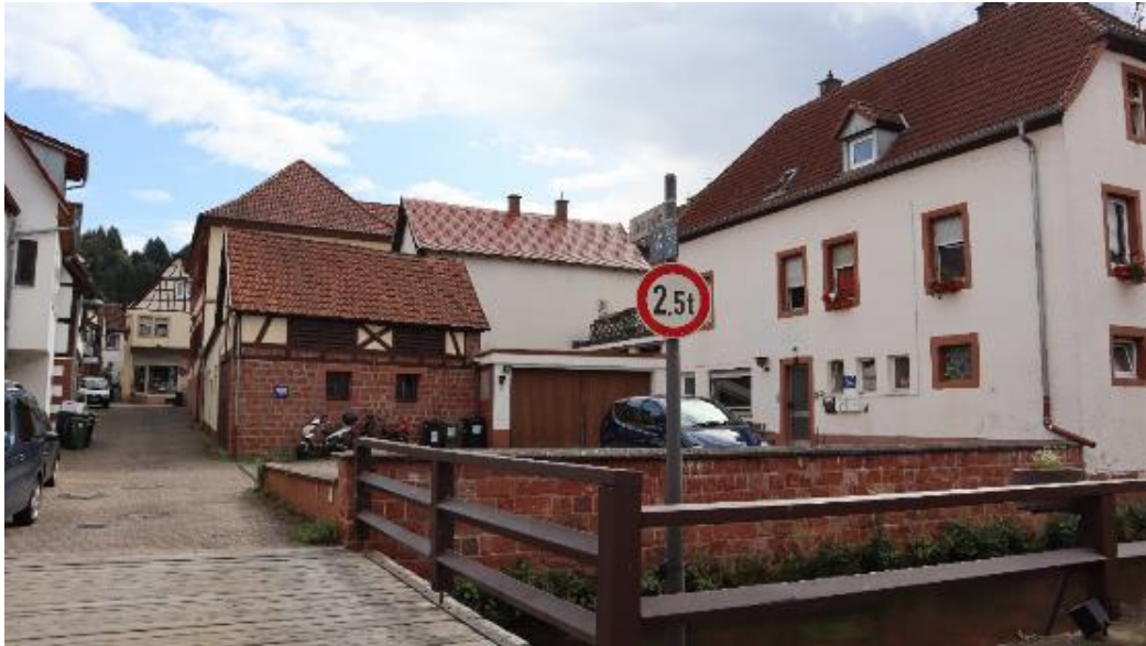
Abb. 120: Korn gasse 3, Ansicht von Nordosten.
