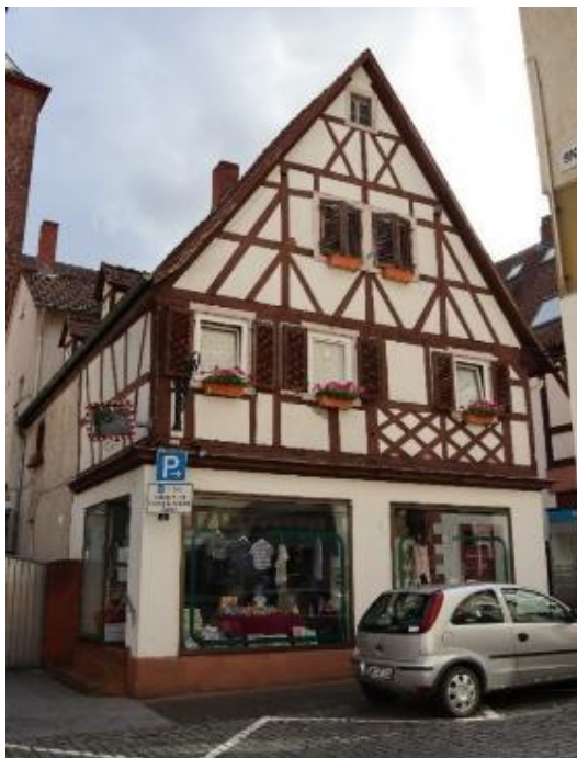
Abb. 3: Altenstraße 1, Ansicht von Nordosten.
