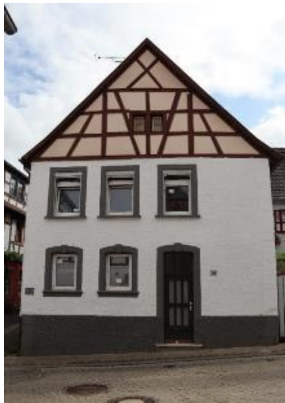
Abb. 49: Flitschberg 13, Ansicht von Nordwesten.
