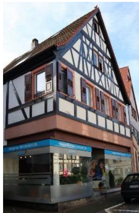
Abb. 2: Altenstraße 3, Ansicht von Nordosten.
