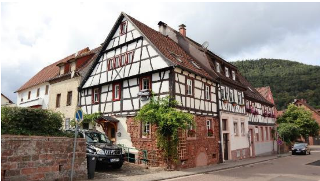
Abb. 157: Spitalstraße 2, 4 und 6 (von rechts nach links). Ansicht von Nordosten.
