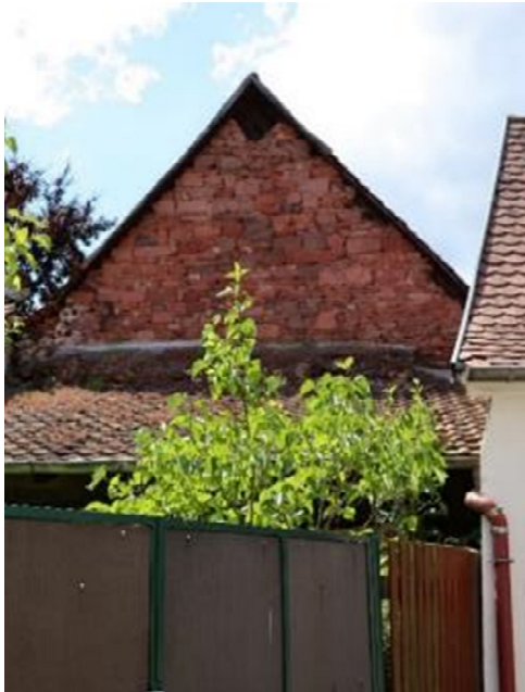
Abb. 19: Altenstraße 28, Ansicht von der Straße Am Storchentor.
