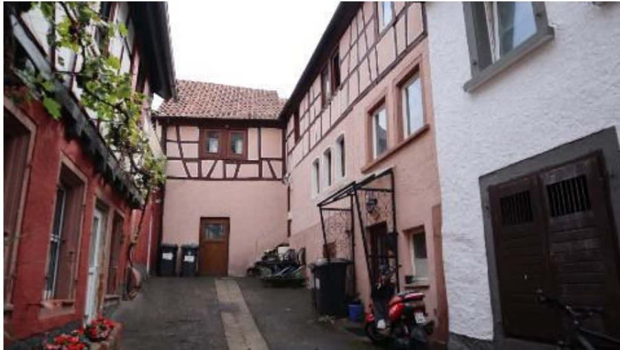
Abb. 48: Flitschberg 9 & 11. Ansicht von Nordwesten.
