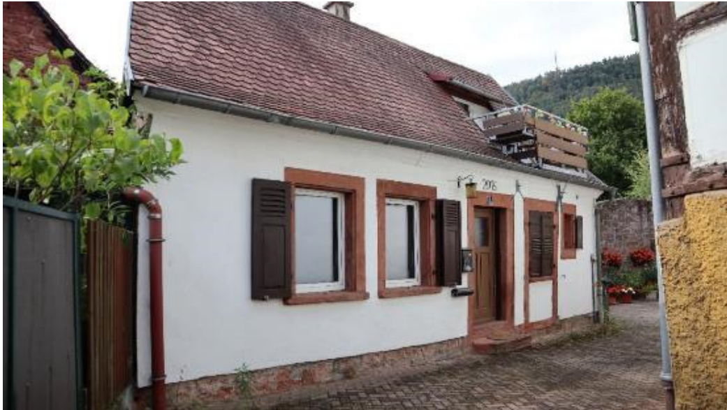
Abb. 24: Am Storchentor 1, Ansicht von Südosten.
