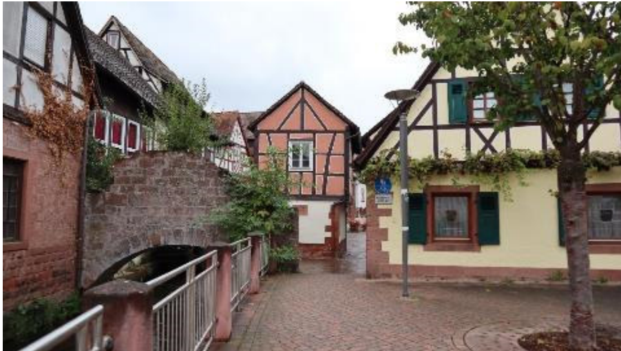
Abb. 148: Schipkapass, Ansicht des Zugangs zur Straße von Osten. Hier auch Mauerbogen über der Queich, Häuser Nr. 2 und 7 (von links nach rechts).
