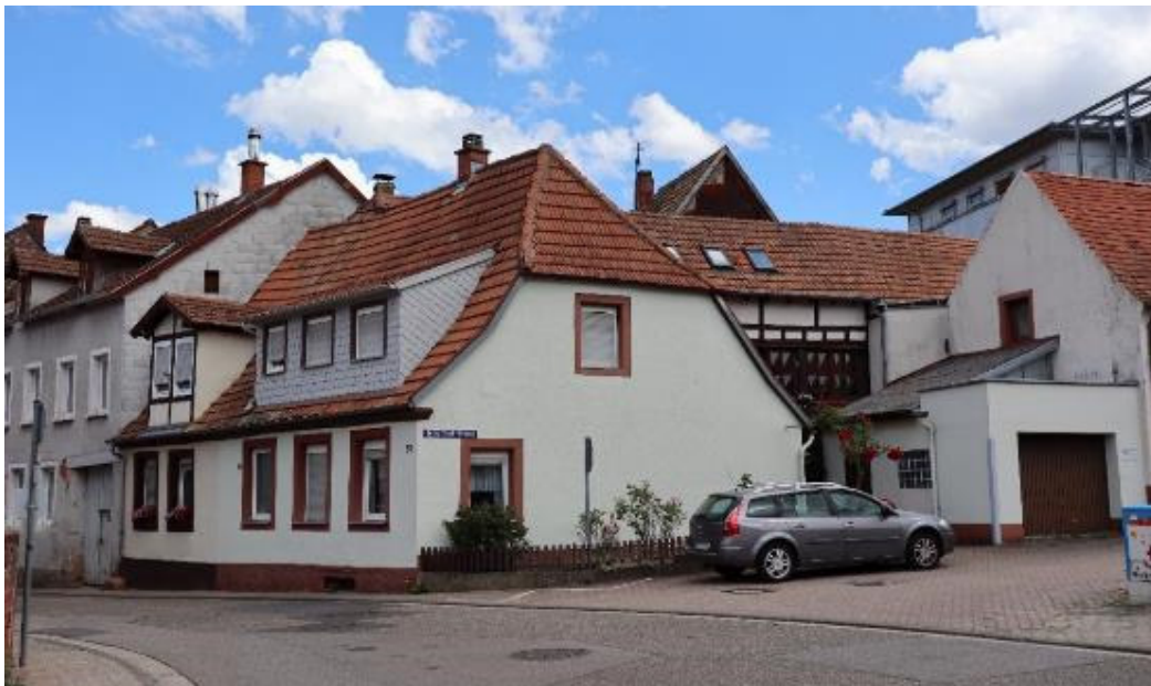
Abb. 21: Altenstraße 35 & 37, Ansicht von Nordwesten.
