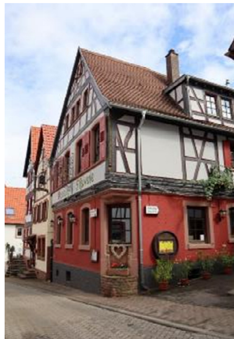
Abb. 43: Flitschberg 7, Ansicht von Nordwesten.
