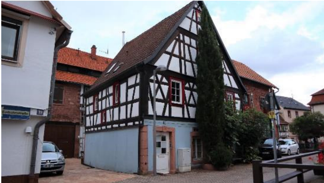
Abb. 62: Gerbergasse 23, Ansicht von Südwesten.
