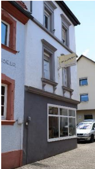
Abb. 135: Quodgasse 8, Ansicht von Nordwesten.
