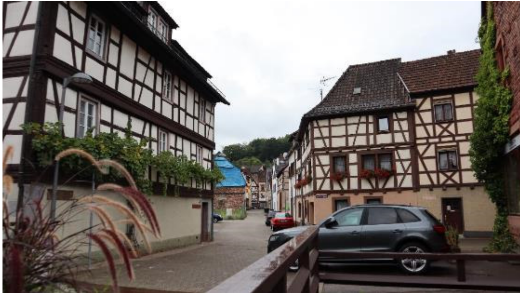
Abb. 131: Quodgasse, Straßenansicht von Nordwesten. Blick von der Wassergasse über die Freifläche an der Ecke Apothekergasse. Links: Haus Nr. 32. Rechts an der Ecke: Haus Nr. 7.
