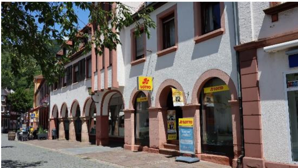
Abb. 83: Hauptstraße 21 und 23, Ansicht von Südwesten.
