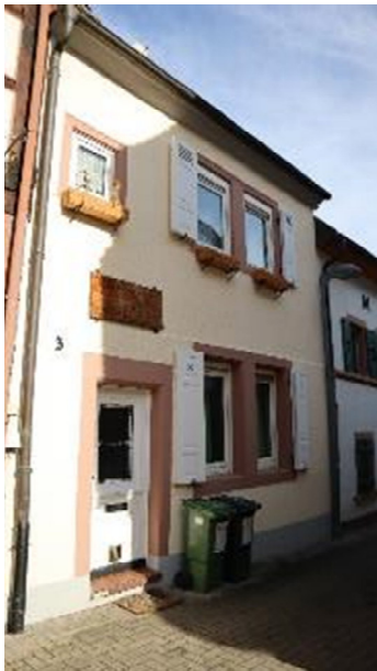
Abb. 144: Römergasse 3, Ansicht von Südwesten.
