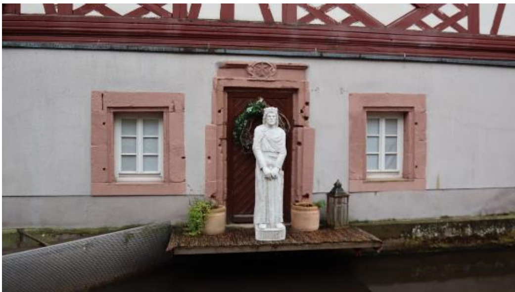
Abb. 139: Quodgasse 32 (30), Erdgeschoss-Fenster mit nachgotischen Stabprofilen, Türsturz des Barockportals mit Zunftzeichen. Ansicht von Norden (Schipkapass).
