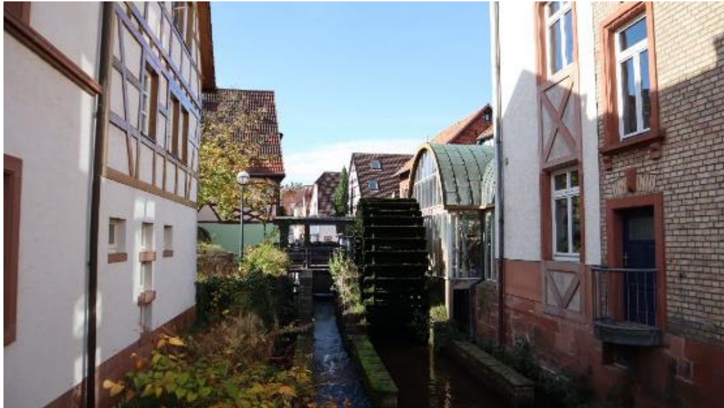
Abb. 74: Technische und wasserbauliche Anlagen, zugehörig zu Hauptstraße 6, gelegen an der Queich. Ansicht von Osten.
