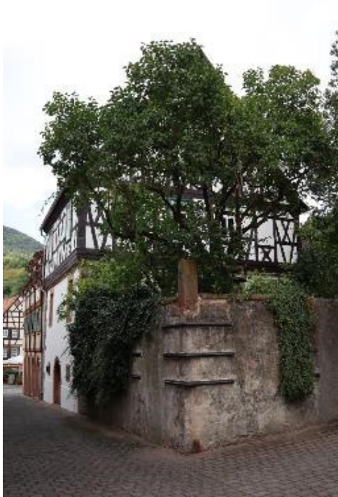
Abb. 106: Kirchgasse 3, Ansicht von Südwesten.
