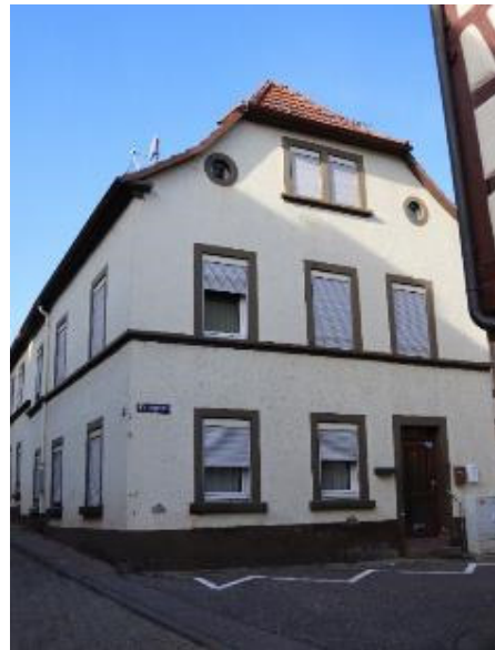
Abb. 50: Flitschberg 14, Ansicht von Südosten.
