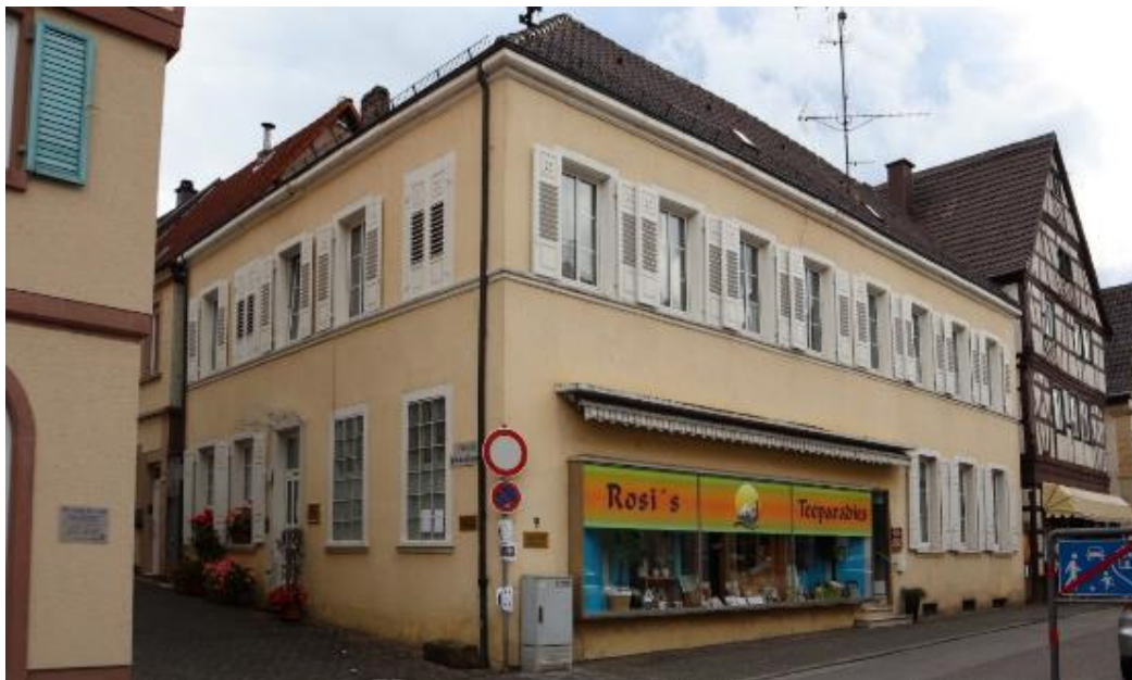
Abb. 6: Altenstraße 9, Ansicht von Nordosten.
