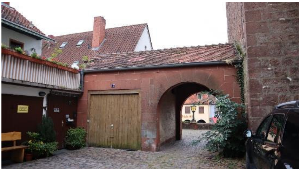
Abb. 105: Durchgang nördlich der Stadtkirche in Richtung Rathausplatz. Hier auch historisches Kopfsteinpflaster.
