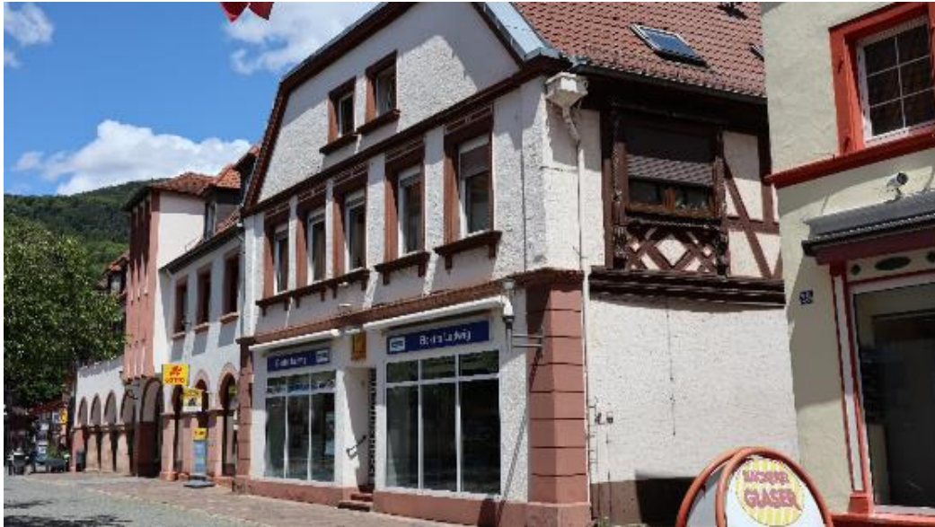
Abb. 86: Hauptstraße 25 mit Fenstererker, Ansicht von Südwesten.
