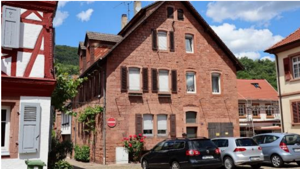
Abb. 29: Am Storchentor 5 und 6, Ansicht von der Altenstraße.
