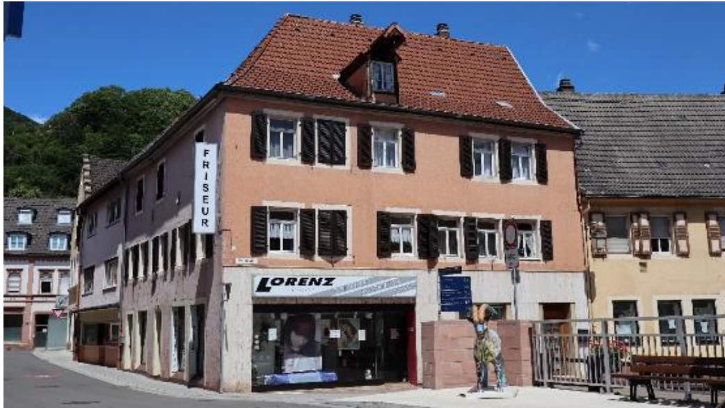
Abb. 72: Hauptstraße 5, Ansicht von Südwesten.
