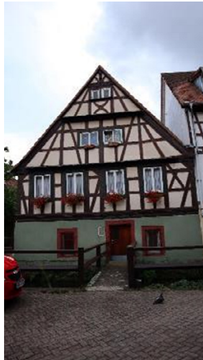
Abb. 127: Prangertshof 8 von Nordwesten.
