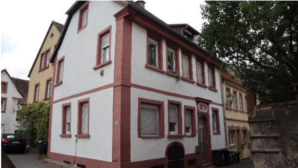
Abb. 104: Kirchgasse 4, Ansicht von Südosten.
