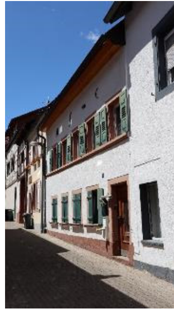
Abb. 145: Römergasse 5, Ansicht von Südosten.
