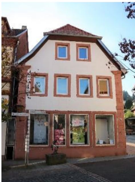
Abb. 89: Hauptstraße 28, Ansicht von Norden.
