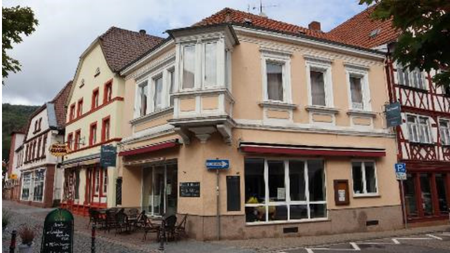
Abb. 91: Hauptstraße 31, Ansicht von Südwesten.
