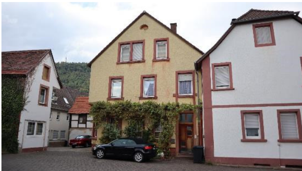
Abb. 40: Diakonissengasse 1, Ansicht von Südosten.
