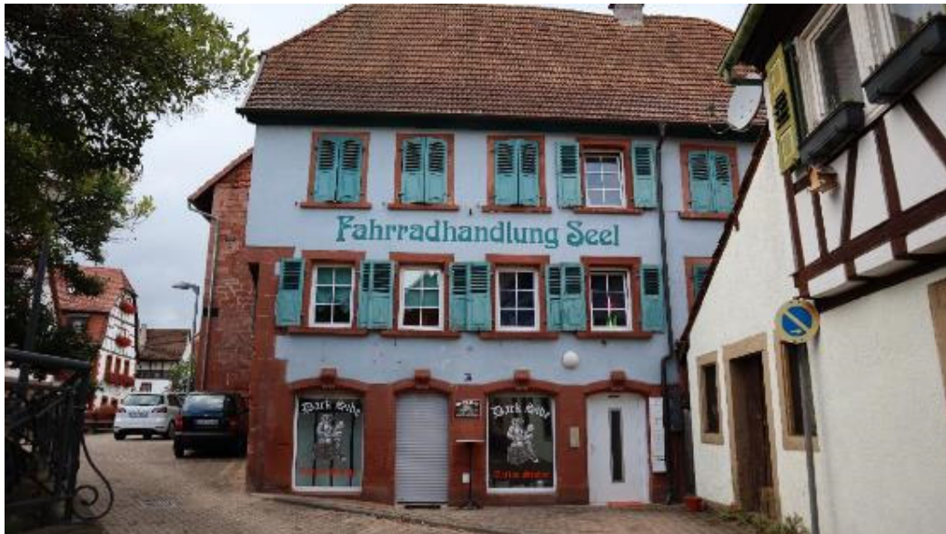
Abb. 64: Gerbergasse 27, Ansicht von Osten.
