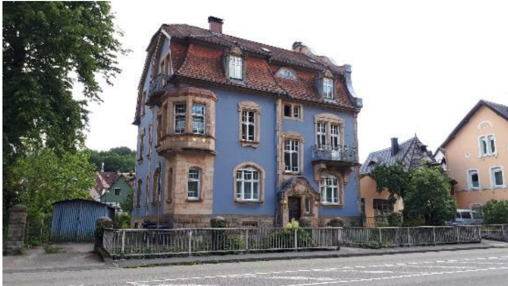
Abb. 146: Saarlandstraße 6, Ansicht von Nordosten.
