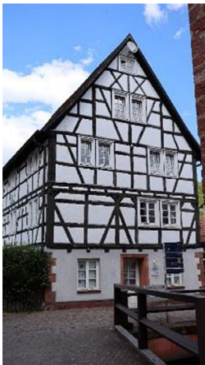
Abb. 58: Gerbergasse 1, Ansicht von Südwesten.
