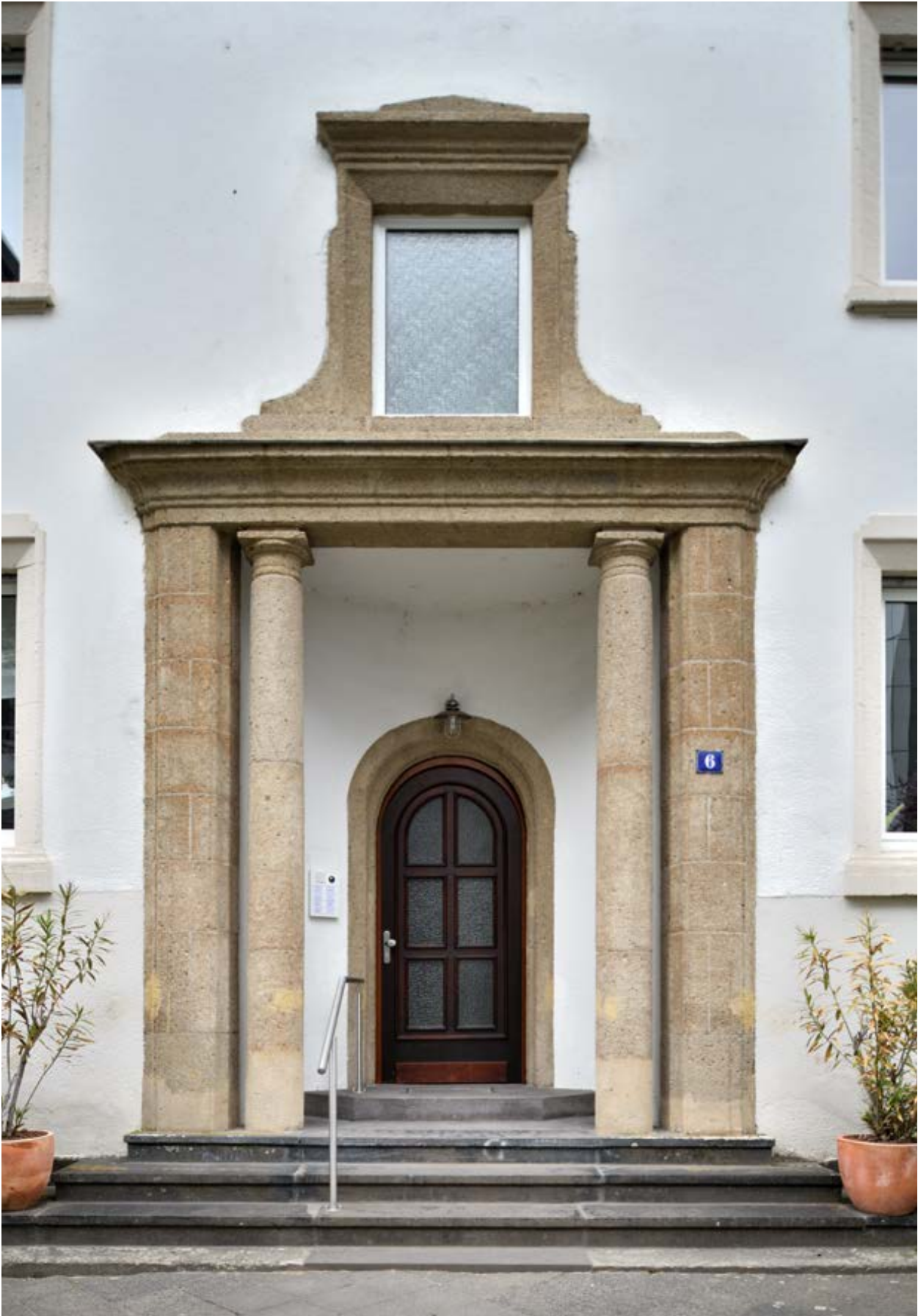
Abb. 25 Repräsentatives Rundbogenportal als Hauseingang
