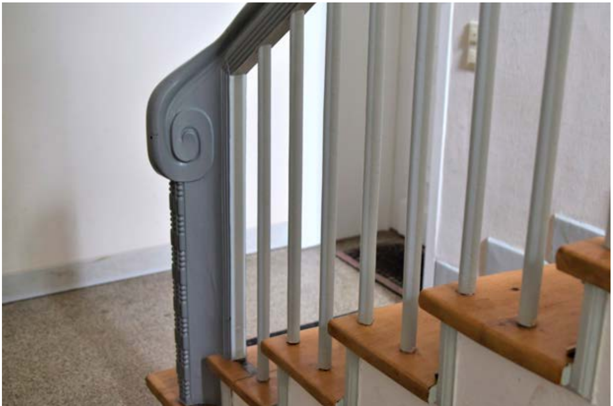
Abb. 11 Treppe mit dekorativem Anfangspfosten
