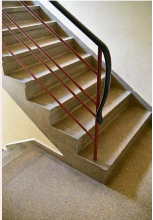
Abb. 15 Treppenaufgang der 1950er Jahre
