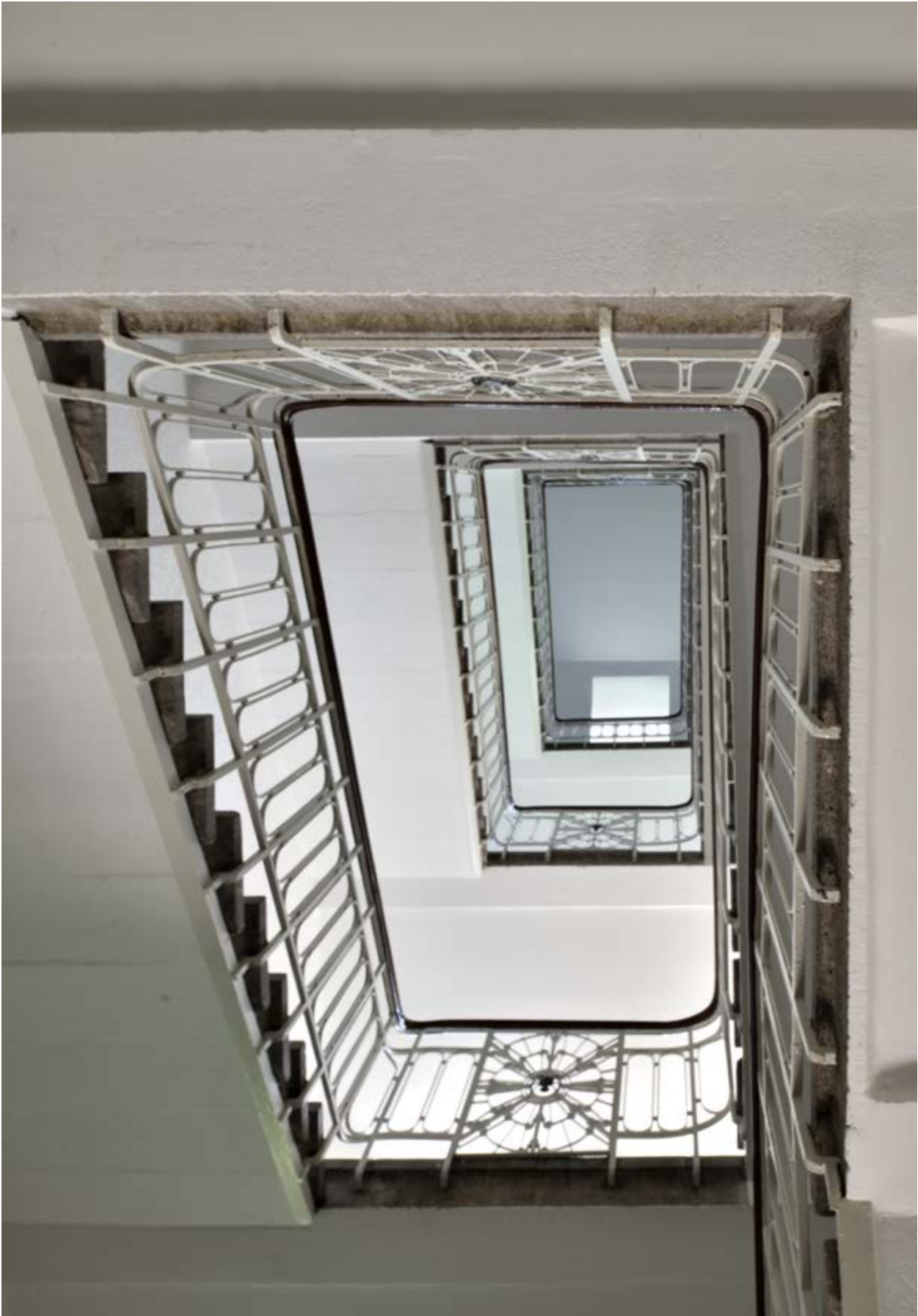
Abb. 12 Offenes Treppenauge im Haus Südallee 64
