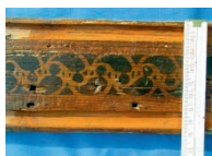
Detail einer Holzdecke im Nordbau
