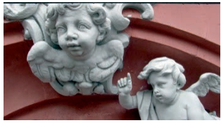
Fassadendetail nach der Sanierung
