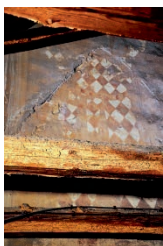
Malereifragment an der ehem. Außen- wand des Turms
