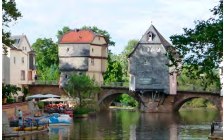
Bad Kreuznach, Alte Nahebrücke (S. 3), Foto: Georg Peter Karn, GDKE
