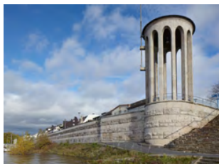
Neuwied, Deichmauer mit Pegelturm
