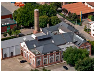
Worms, EWR-Kesselhaus und Turbinenhalle
