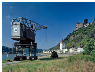
Sankt Goarshausen, „Häusener Kran“
