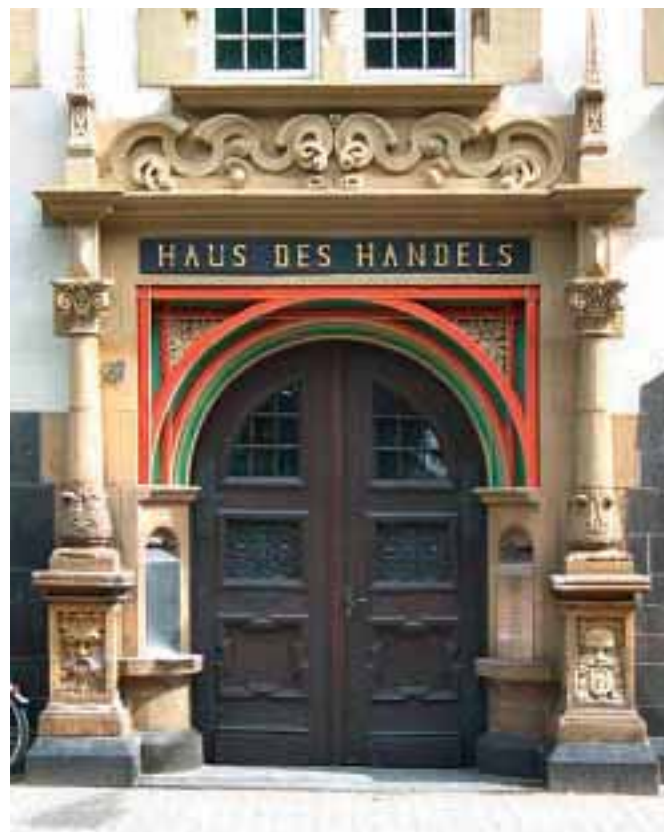
Trier, Kaiserstraße 27: Ehem. Handelskammer, Haupteingang nach der Restaurierung
