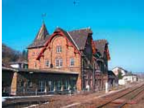
Jünkerath , Bahnhofs- empfangs- gebäude
