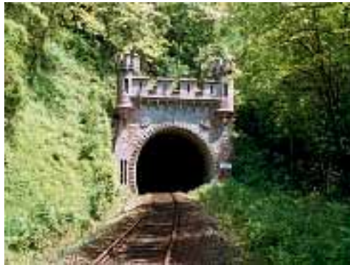
Südportal des 333 m langen Friedrich- Wilhelm- Tunnels
