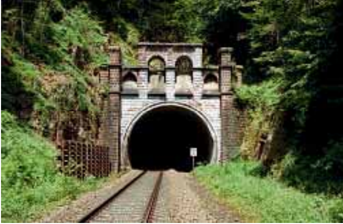
Südportal des Philipstunnels bei Speicher
