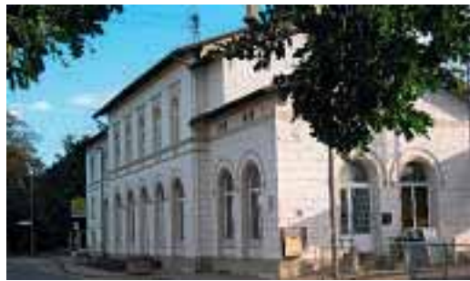
Weißenthurm, Bahnhofs- Empfangs- gebäude
