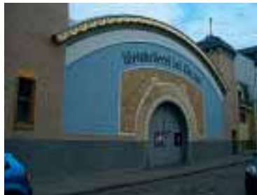
Trier, Ehem. Weinkellerei Joh. Förster, Jugendstilfassade nach der Restaurierung
