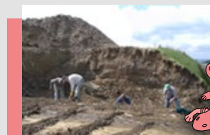
Perm: Callbach Baustelle B420
