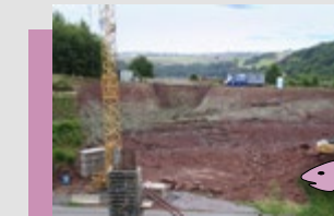
Trias: Pirmasens Baustelle L600
