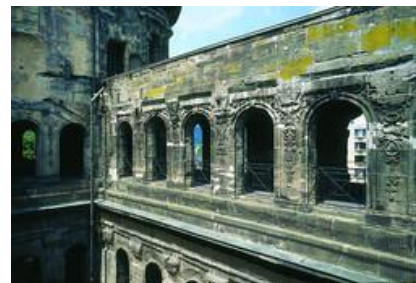
Verzierung der Fassadengliederung in Form von Säulen, Kapitellen und Gesimsen.
