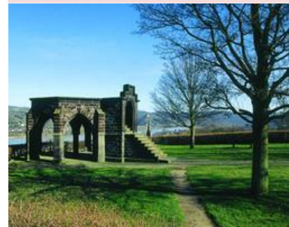
Das heutige Denkmal ist eine Konstruktion aus Treppengiebeln, Strebebfeilern und unverputzten Steinen.
