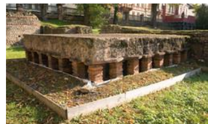
Heizungssystem im Kellergeschoss der Anlage
